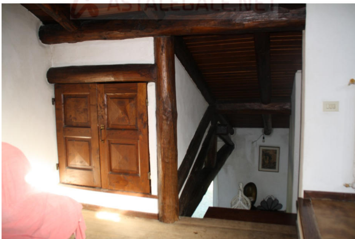
Foto 28 Accesso alla mansarda e armadio nel sottotetto
