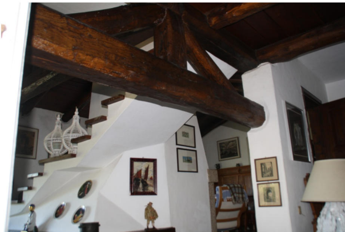
Foto 25 Particolare capriata tetto
