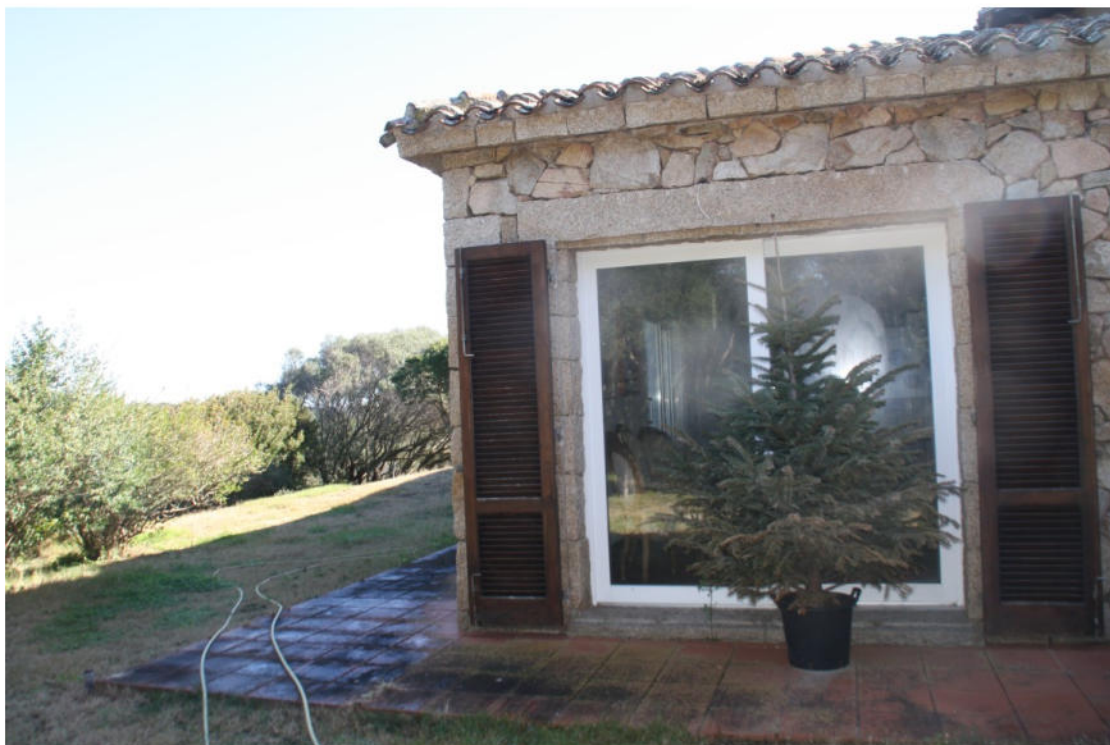
Foto 05 Ripresa lato ovest - Vetrata soggiorno
