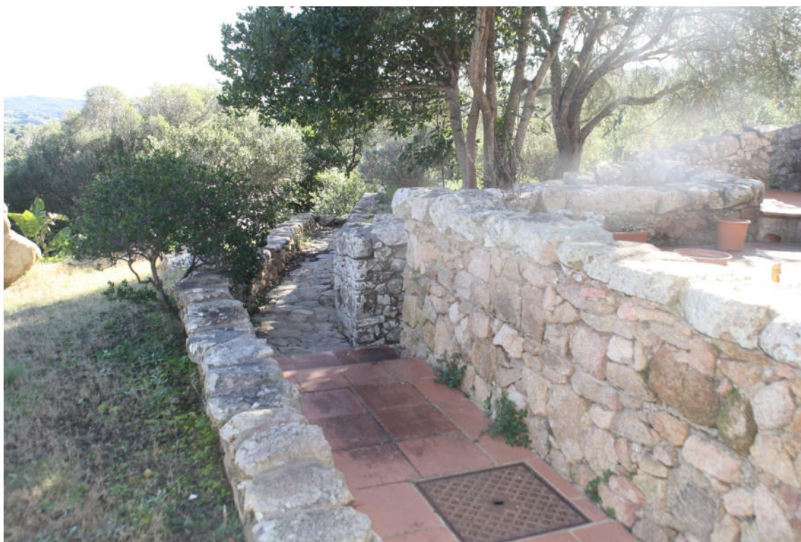
Foto 09 Ripresa lato nord- Camminamenti
