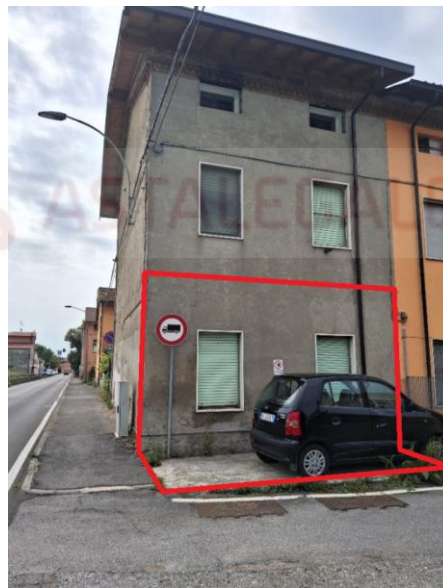
IMMOBILE LATO NORD
