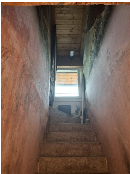
Vista 1 Scale - per accesso piano sottotetto
