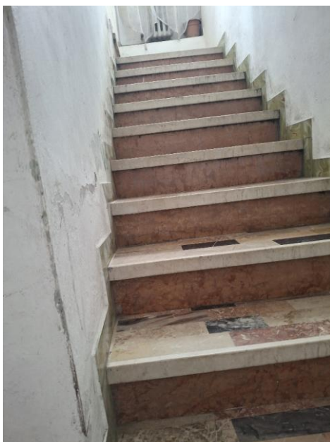
Scale d'accesso al piano primo
