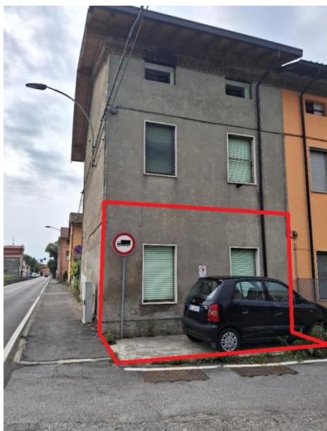
Vista coerenziata lato nord facciata
