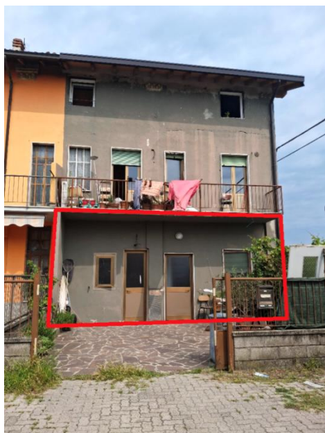
Vista coerenziata lato sud facciata
