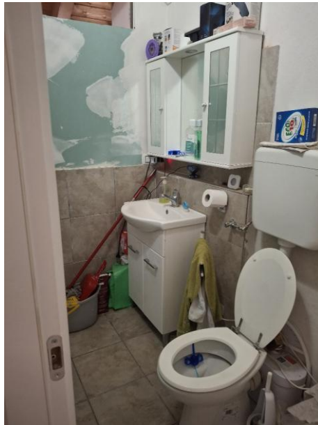
Vista 1 - Bagno- piano sottotetto
