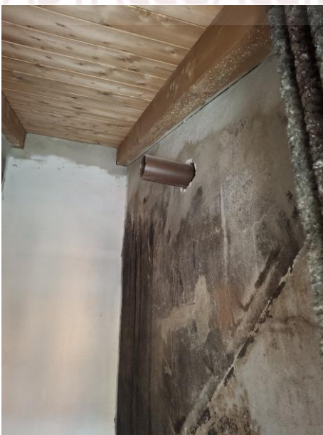
Vista 2 vano Scale per accesso piano sottotetto
