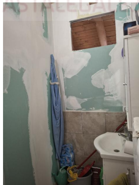
Vista 2 - Bagno- piano sottotetto
