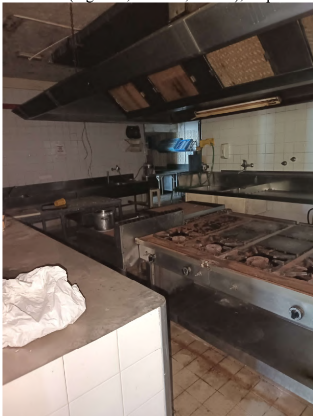
FOTO 10 – stabile civ. 323 di v.le Miramare – zona centrale (ingresso, area bar, cucina), dispense
