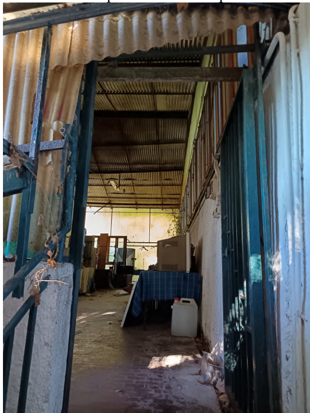
FOTO 39 – stabile civ. 323 di v.le Miramare – Primo piano: terrazza coperta
