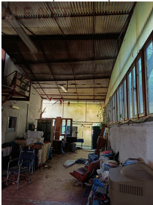
FOTO 40 – stabile civ. 323 di v.le Miramare – Primo piano: terrazza coperta
