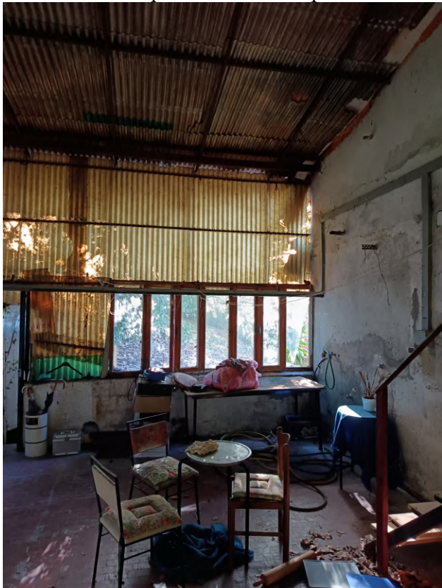
FOTO 41 – stabile civ. 323 di v.le Miramare – Primo piano: terrazza coperta
