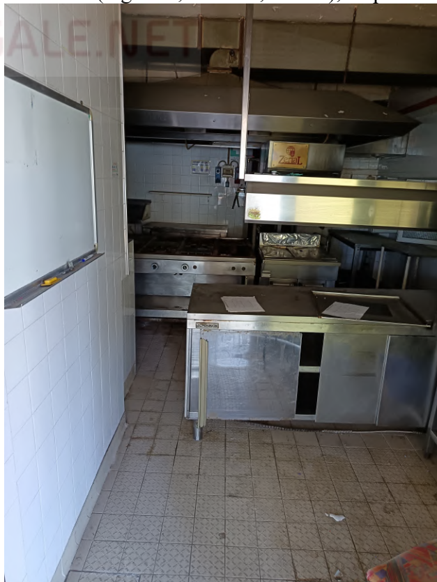
FOTO 9 – stabile civ. 323 di v.le Miramare – zona centrale (ingresso, area bar, cucina), dispense
