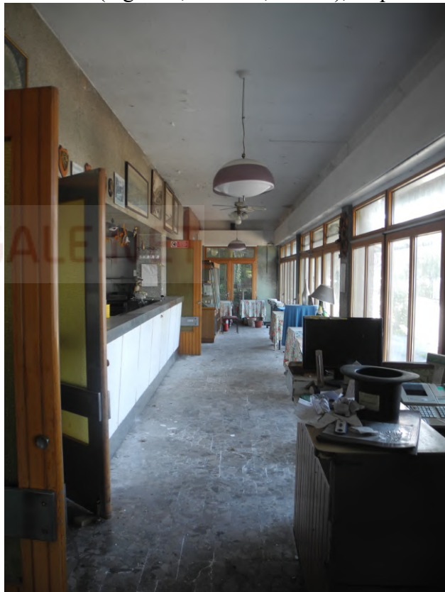
FOTO 5 – stabile civ. 323 di v.le Miramare – zona centrale (ingresso, area bar, cucina), dispense
