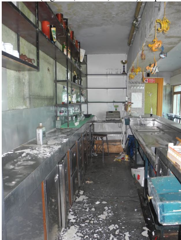
FOTO 8 – stabile civ. 323 di v.le Miramare – zona centrale (ingresso, area bar, cucina), dispense
