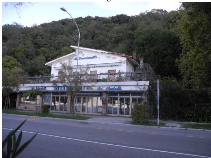
FOTO 3 – facciate stabile civ. 323 di v.le Miramare – lato ingresso
