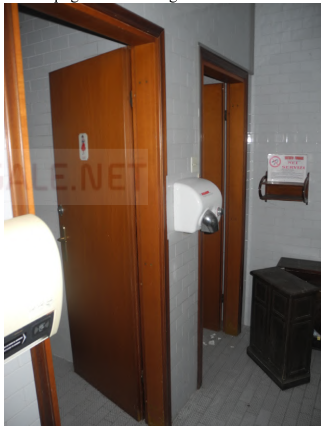
FOTO 21 – stabile civ. 323 di v.le Miramare – zona spogliatoi/servizi igienici ristorante
