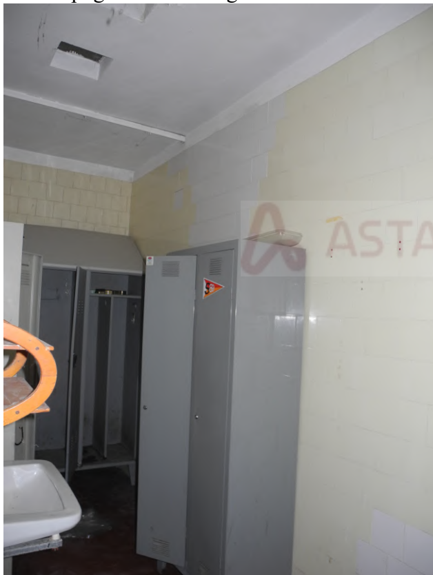
FOTO 19 – stabile civ. 323 di v.le Miramare – zona spogliatoi/servizi igienici ristorante
