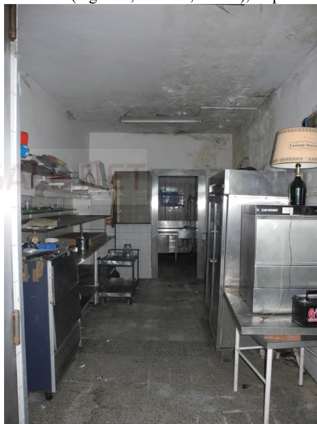
FOTO 323 – stabile civ. 323 di v.le Miramare – zona centrale (ingresso, area bar, cucina), dispense
