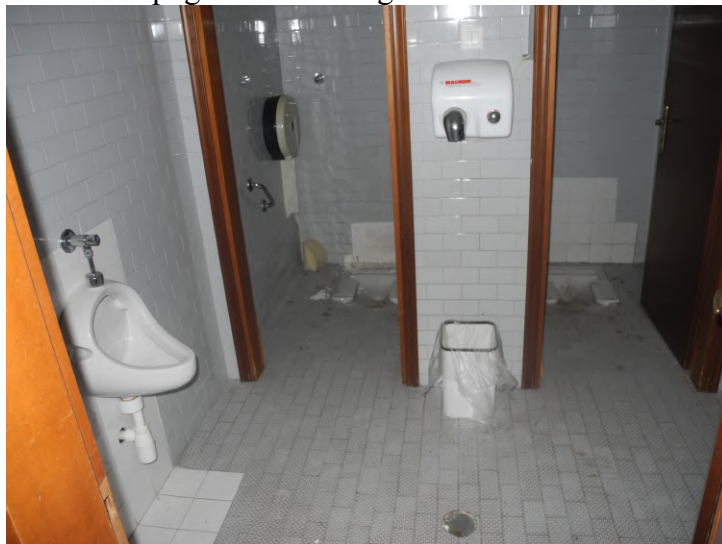
FOTO 20 – stabile civ. 323 di v.le Miramare – zona spogliatoi/servizi igienici ristorante
