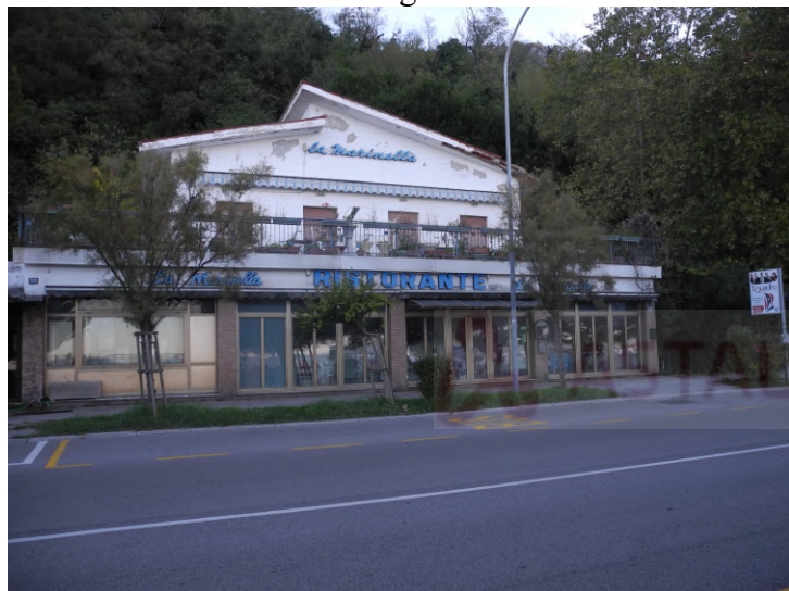
FOTO 2 – facciate stabile civ. 323 di v.le Miramare – lato ingresso
