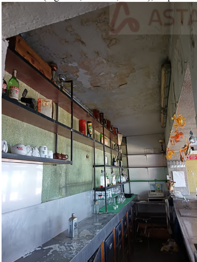
FOTO 7 – stabile civ. 323 di v.le Miramare – zona centrale (ingresso, area bar, cucina), dispense
