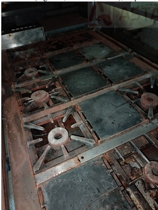
FOTO 11 – stabile civ. 323 di v.le Miramare – zona centrale (ingresso, area bar, cucina), dispense
