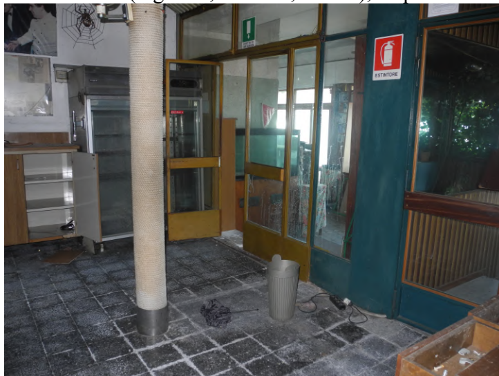
FOTO 4 – stabile civ. 323 di v.le Miramare – zona centrale (ingresso, area bar, cucina), dispense
