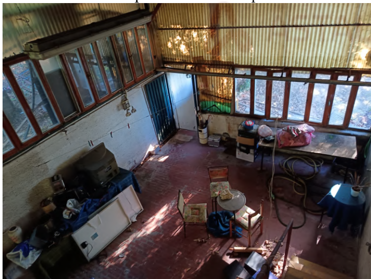
FOTO 42 – stabile civ. 323 di v.le Miramare – Primo piano: terrazza coperta
