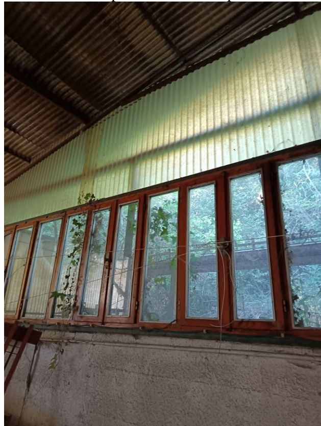
FOTO 43 – stabile civ. 323 di v.le Miramare – Primo piano: terrazza coperta
