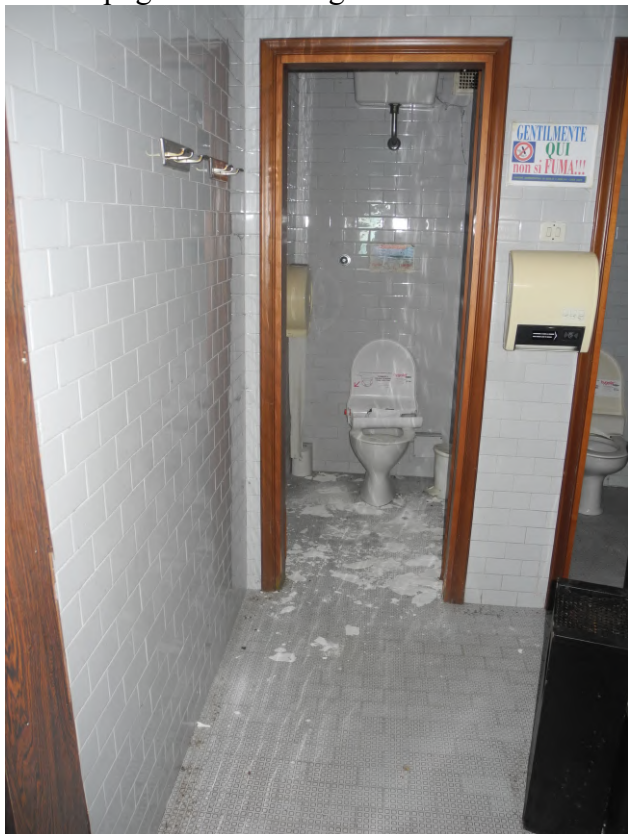
FOTO 22 – stabile civ. 323 di v.le Miramare – zona spogliatoi/servizi igienici ristorante
