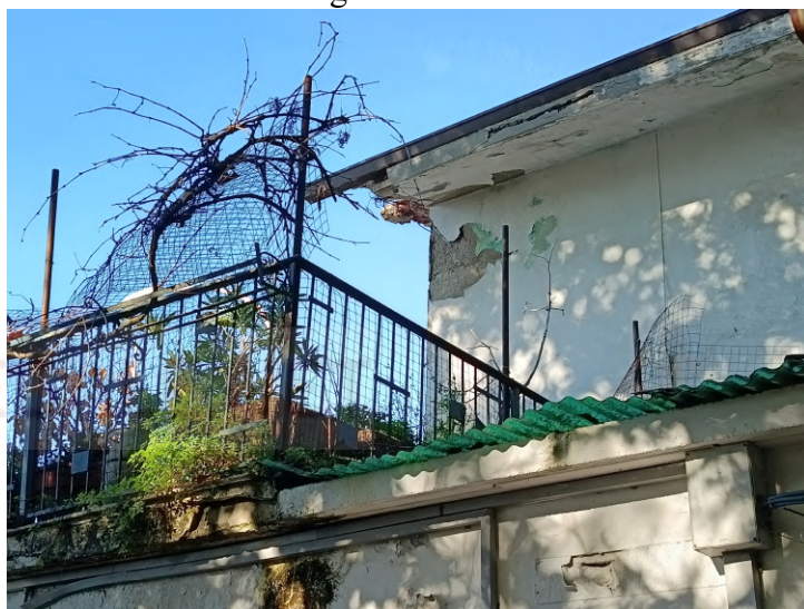
FOTO 63 – stabile civ. 323 di v.le Miramare – Condizioni generali dell'immobile
