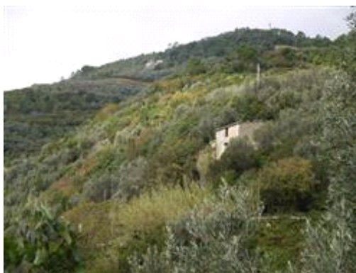
porzione di fabbricato viste dalla strada provinciale
