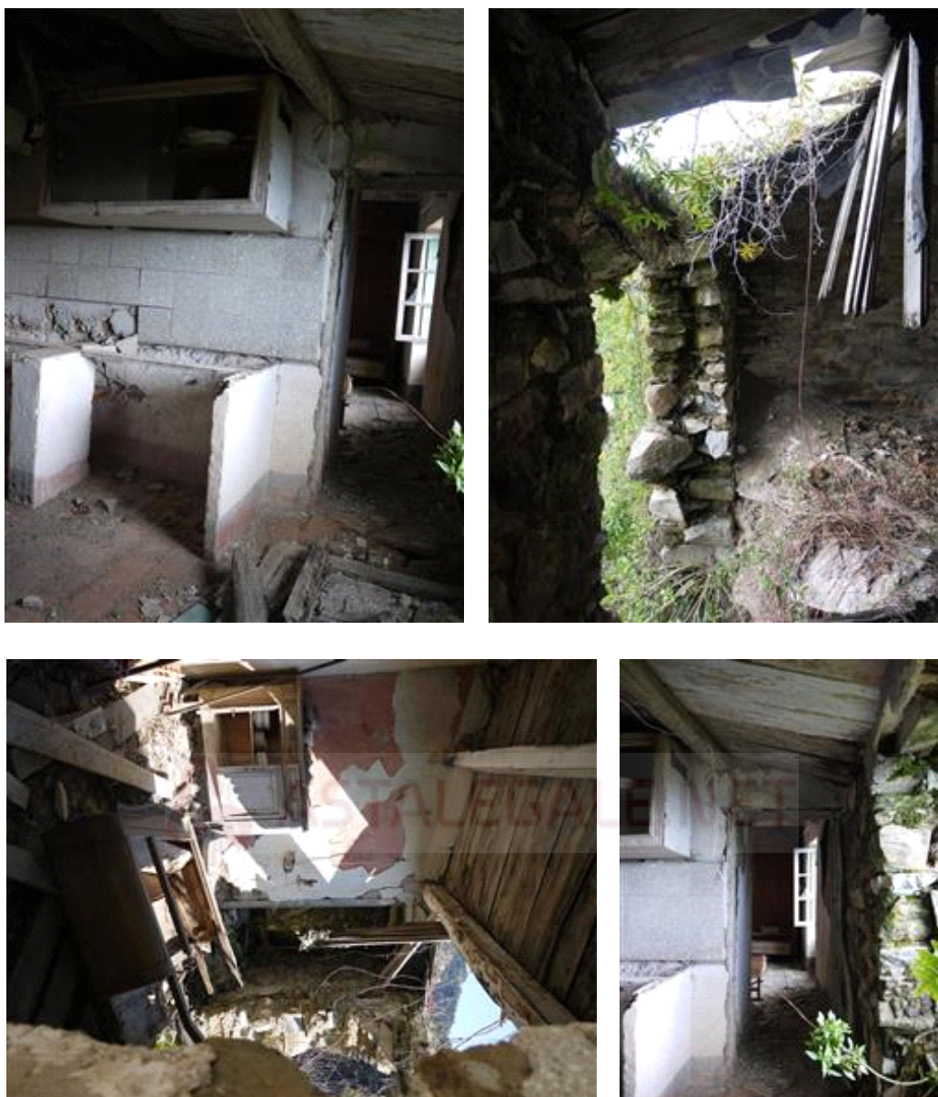
porzione di fabbricato - viste interne
