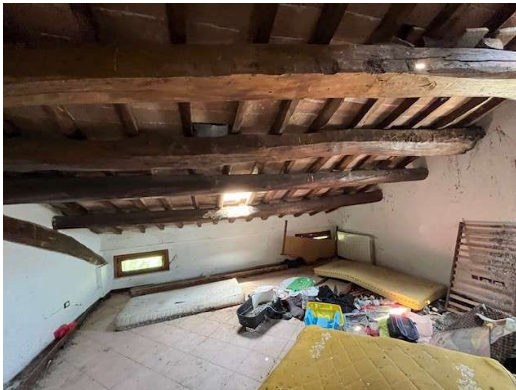
Fotografia 17 – Vista del locale soffitta
