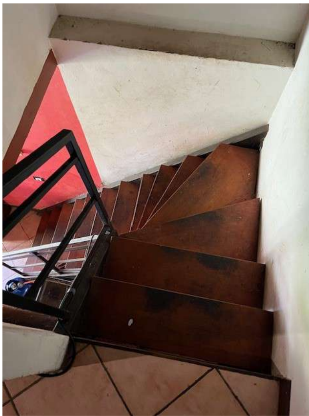
Fotografia 11 – Vista della scala dal disimpegno piano primo
