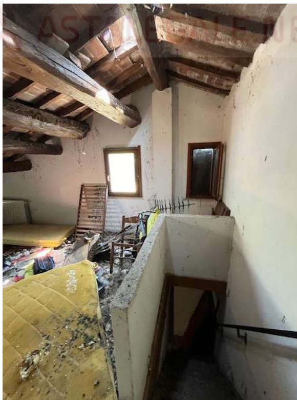
Fotografia 16 – Vista della scala accesso piano soffitta
