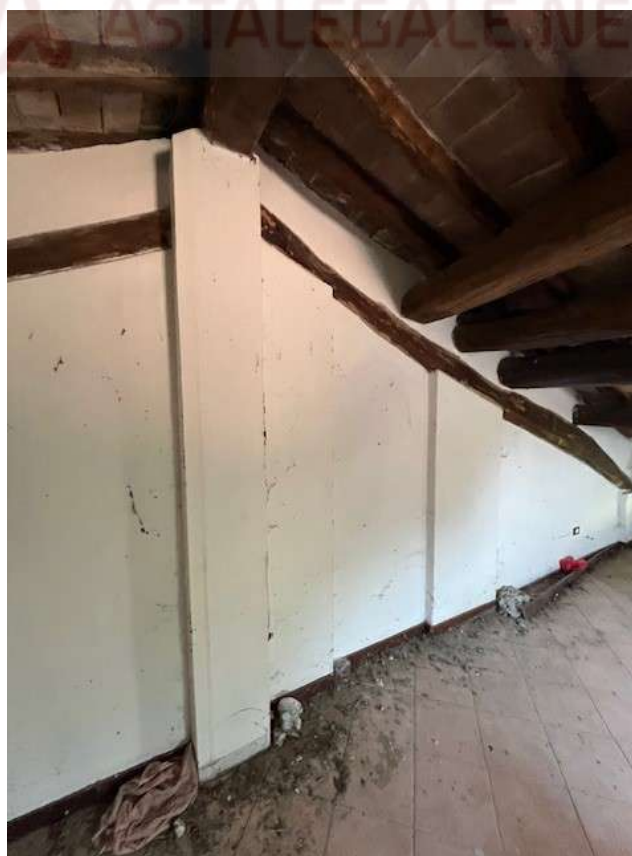
Fotografia 18 – Vista del locale soffitta
