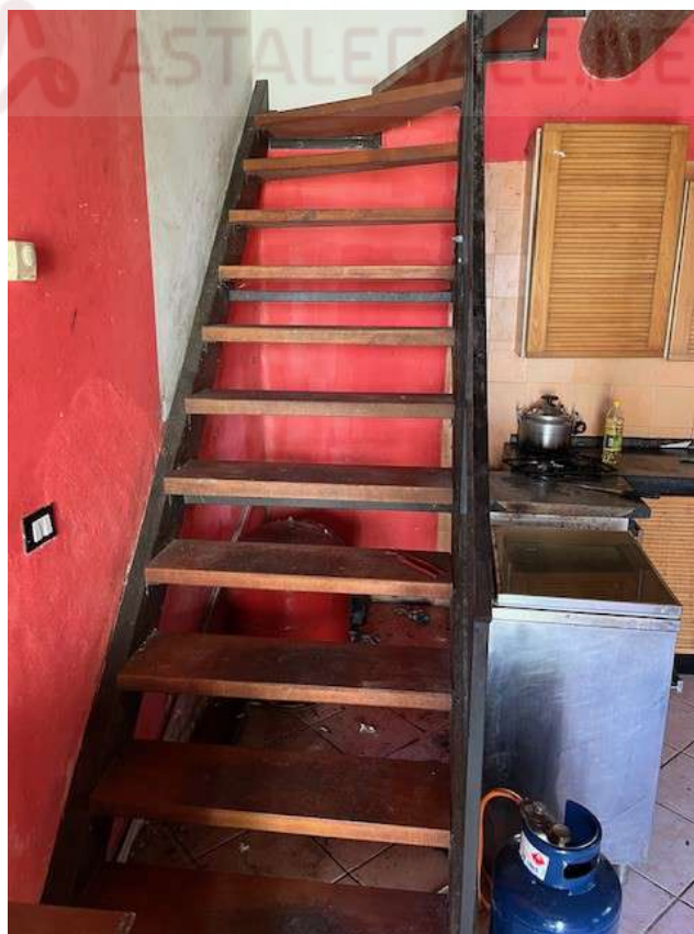
Fotografia 10 – Vista della scala
