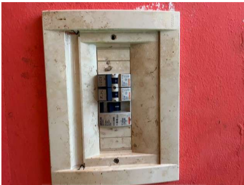
Fotografia 21 – Particolare quadro elettrico posto in cucina
