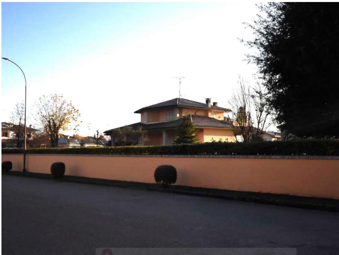
Foto 01: vista da via Pescara
