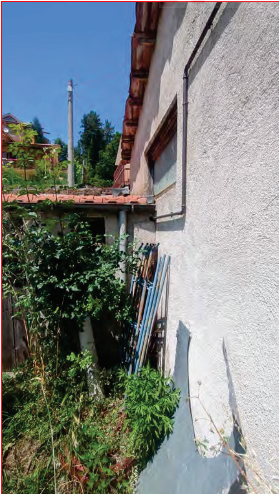
Foto 7 - Cantina esterna piano terra
