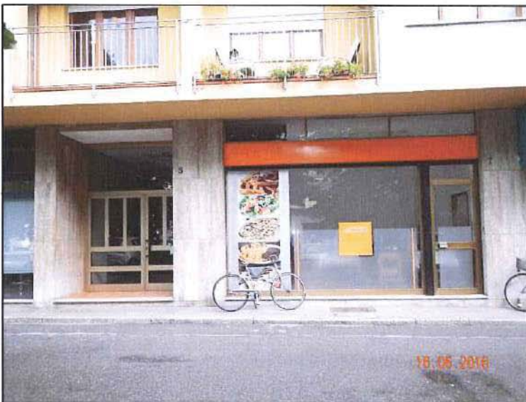
Vista ingresso dall'esterno del sub 48
