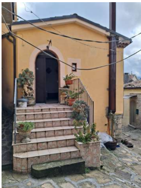
Vista del fabbricato - facciata nord
