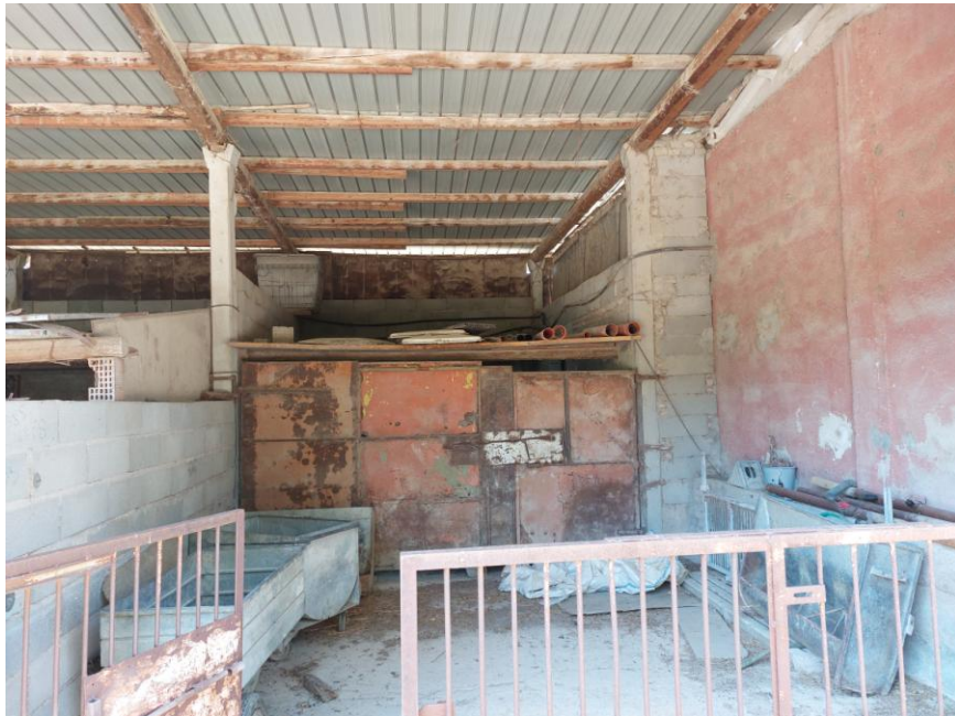
Foto n.72: Particolare interno della rimessa (Bene D).
