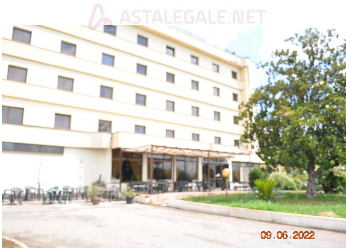
Foto n.4 – Prospetto principale hotel con ingresso
