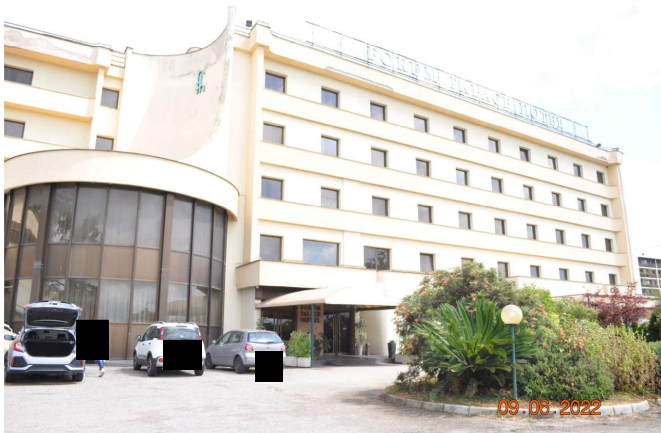
Foto n.3— Prospetto principale hotel
