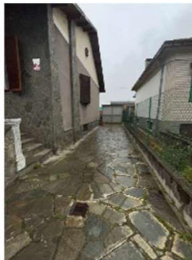
basso fabbricato ad uso autorimessa
