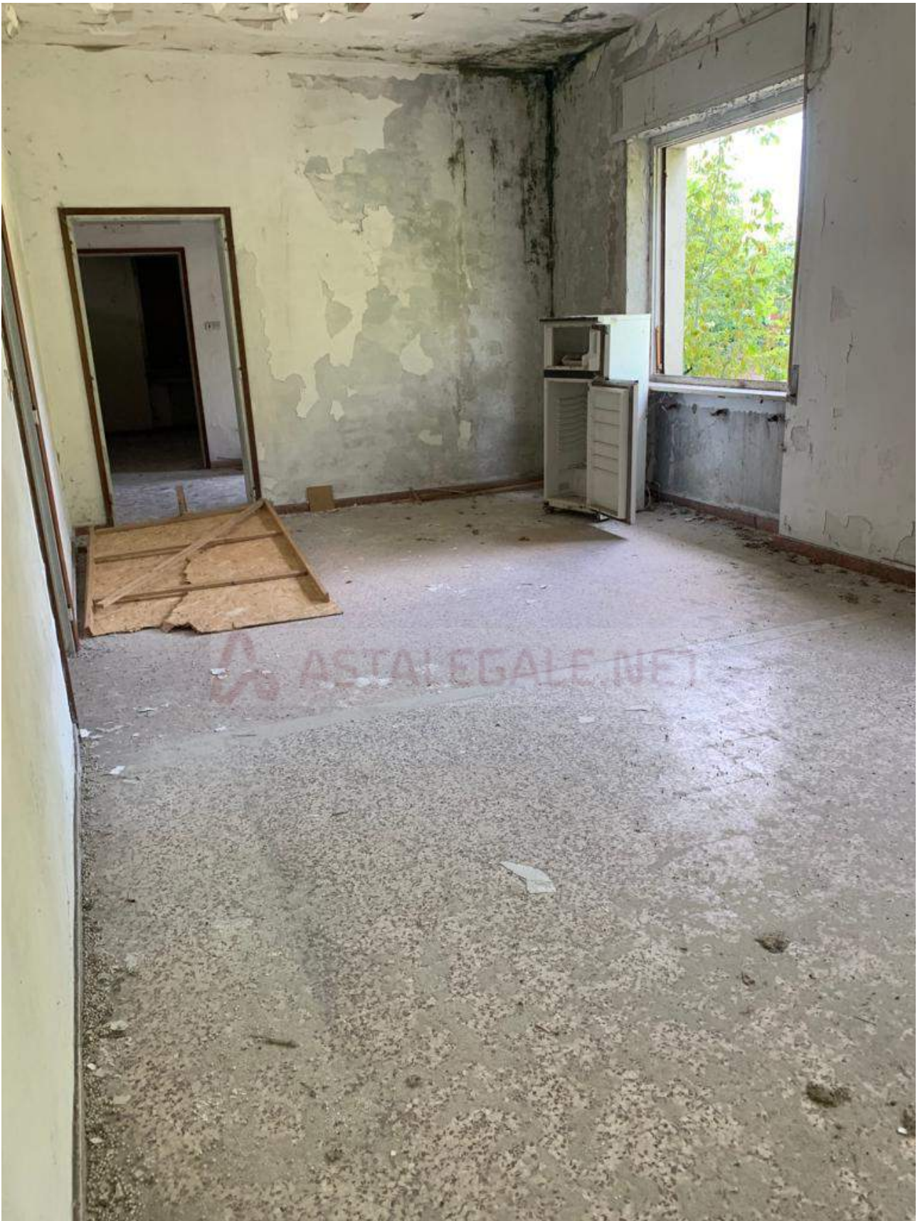
Foto n° 7: Locale corpo principale
