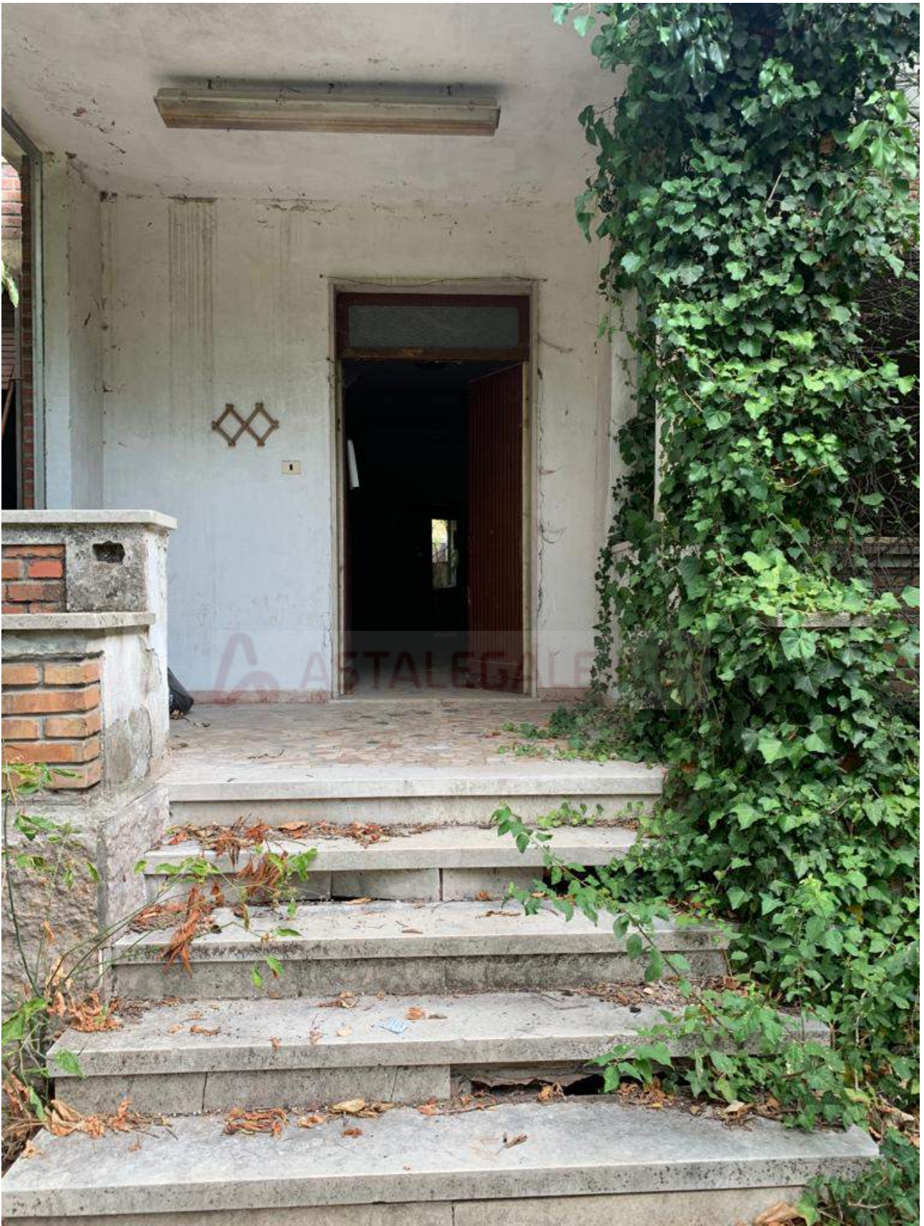
Foto n° 26: Ingresso palazzina Sub 1
