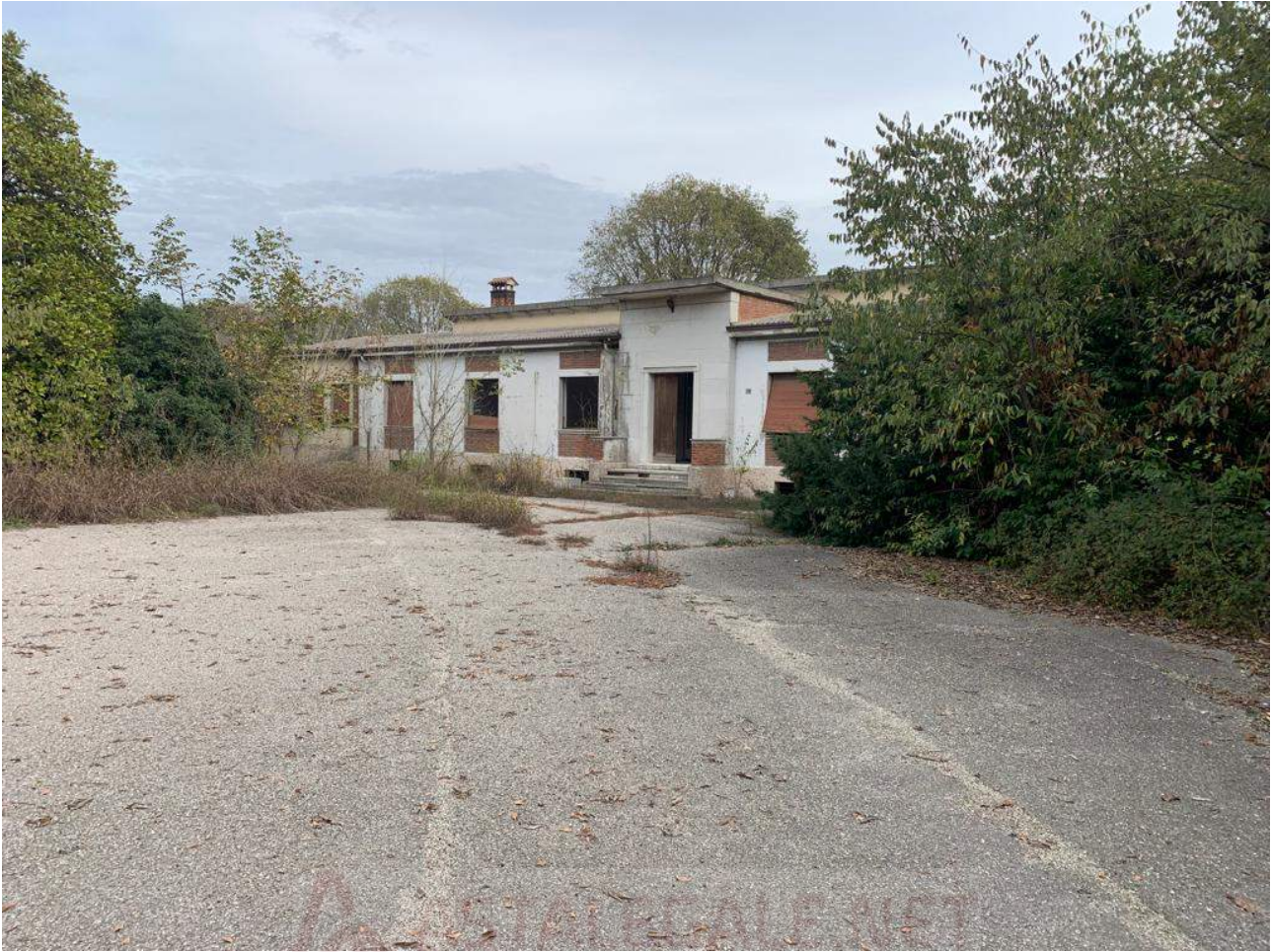
Foto n° 3: Corpo principale lato Ovest
