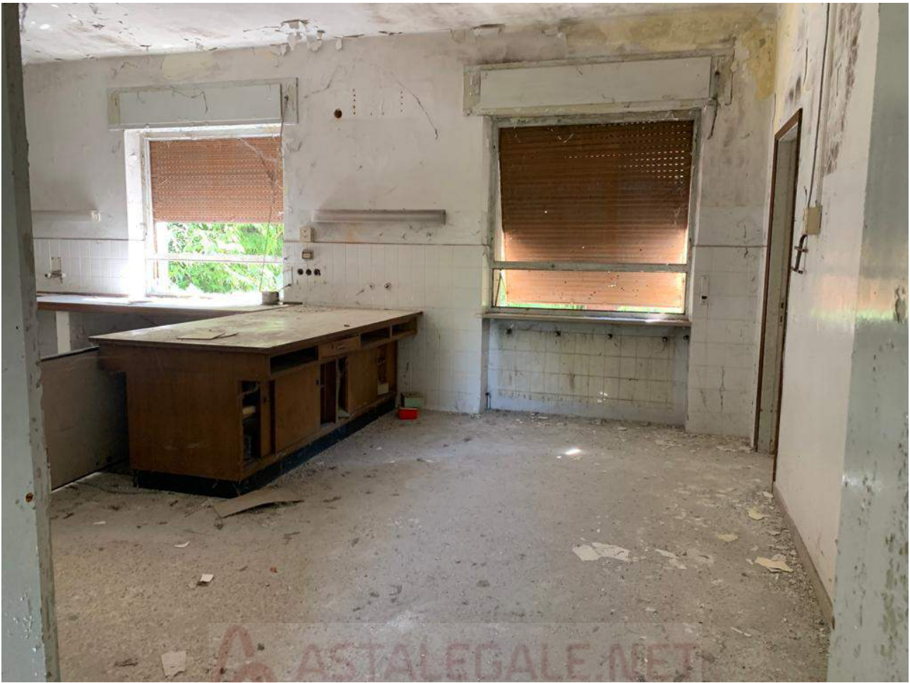
Foto n° 6: Locale corpo principale
