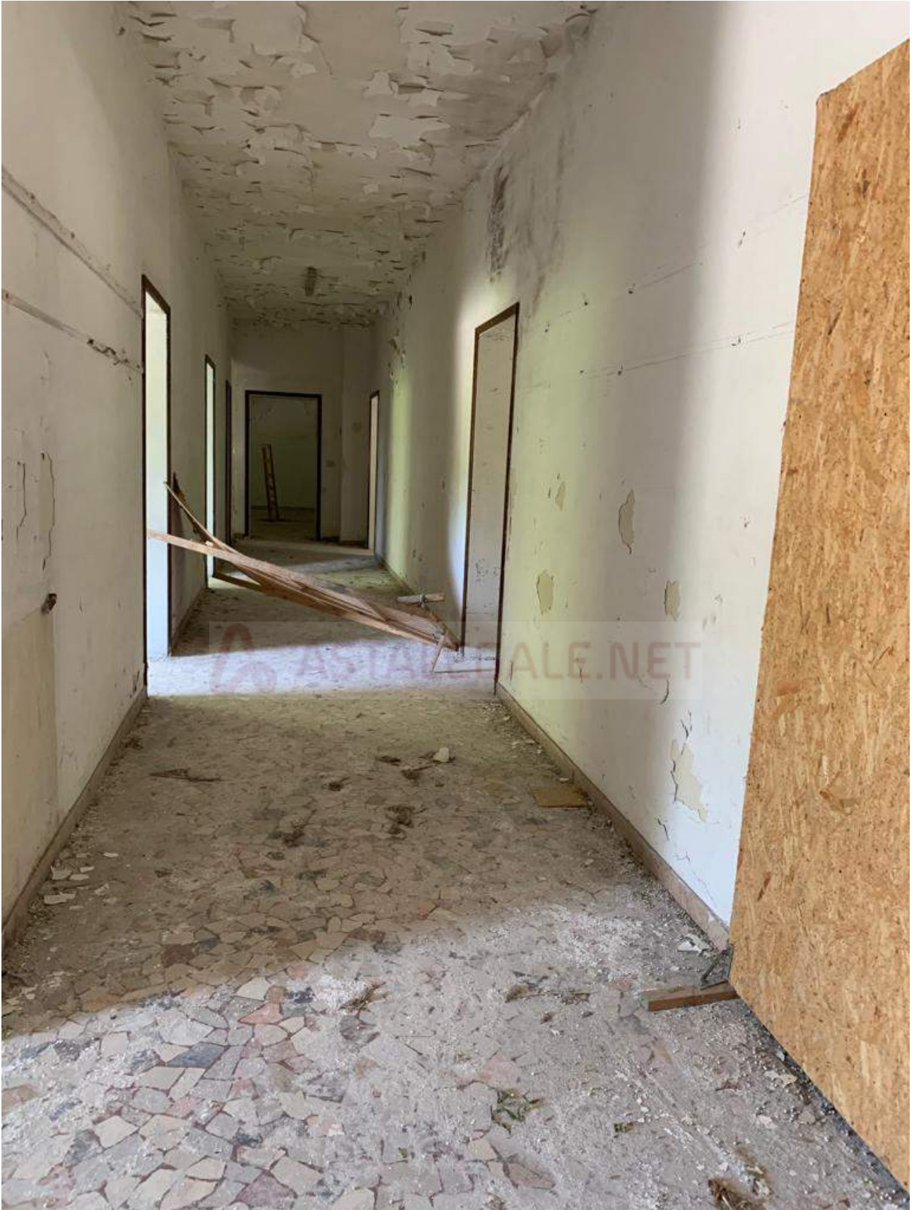
Foto n° 5: Interno corpo principale
