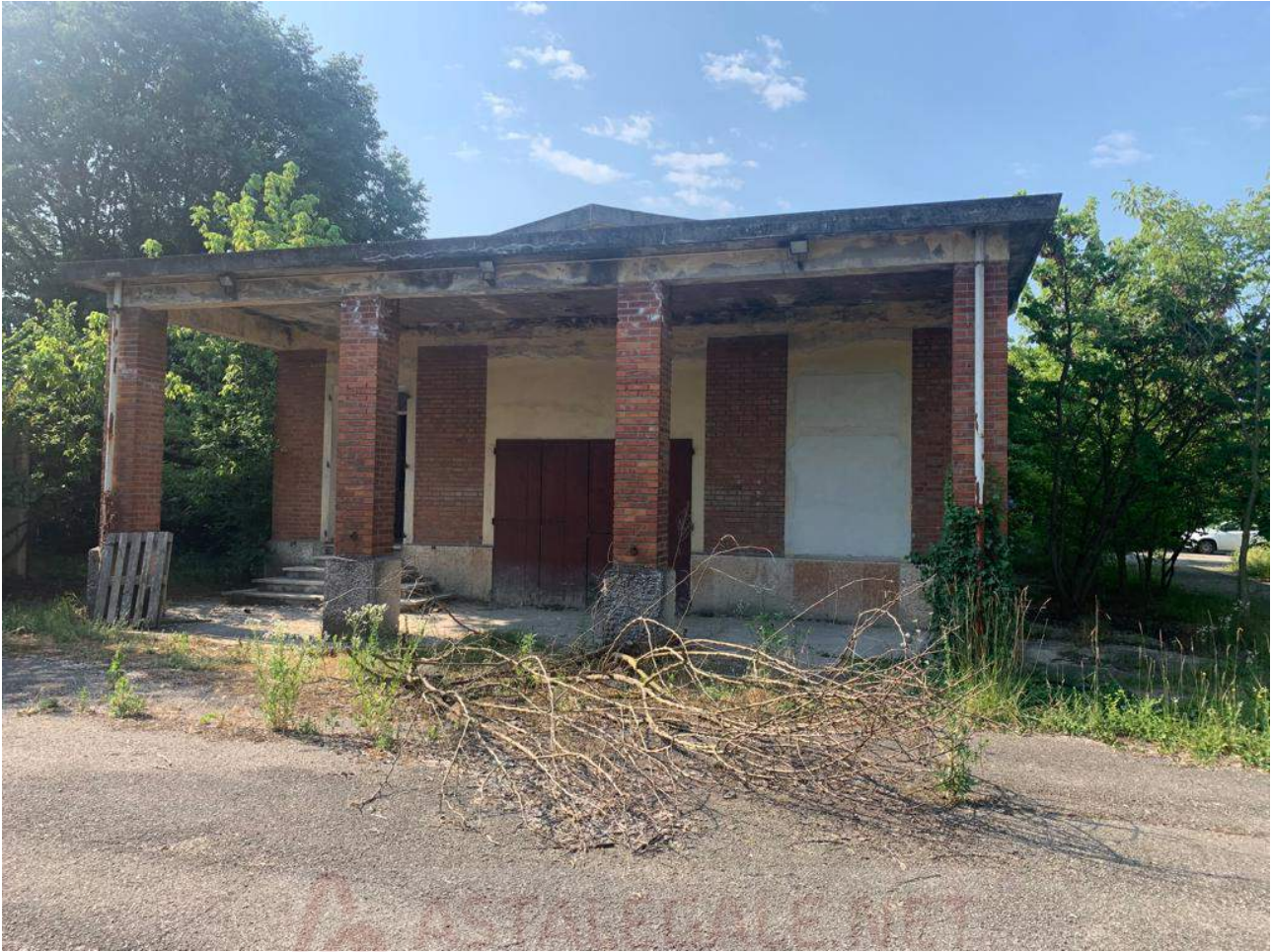
Foto n° 4: Corpo principale lato Nord
