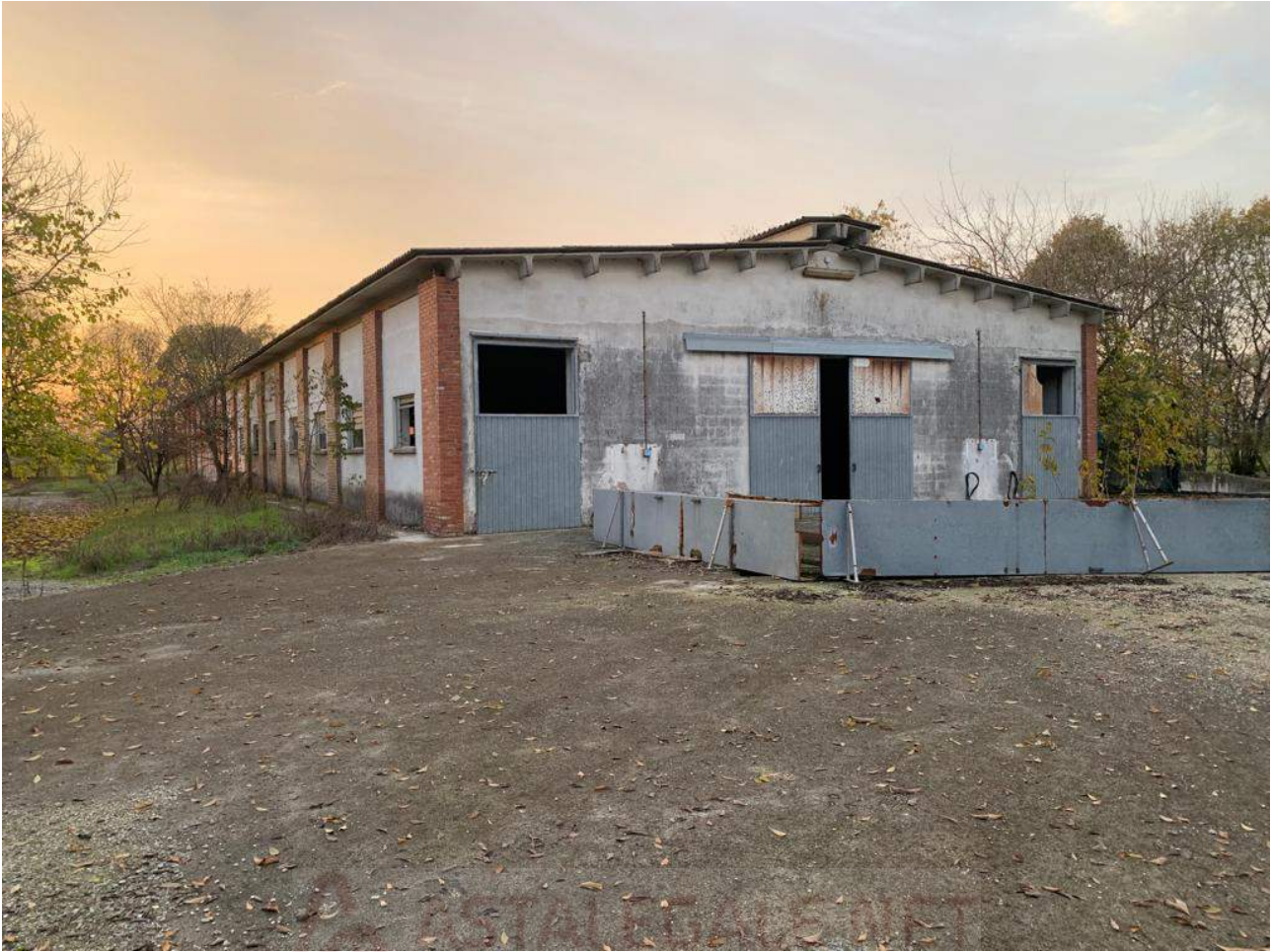
Foto n° 14: corpo particella n. 82
