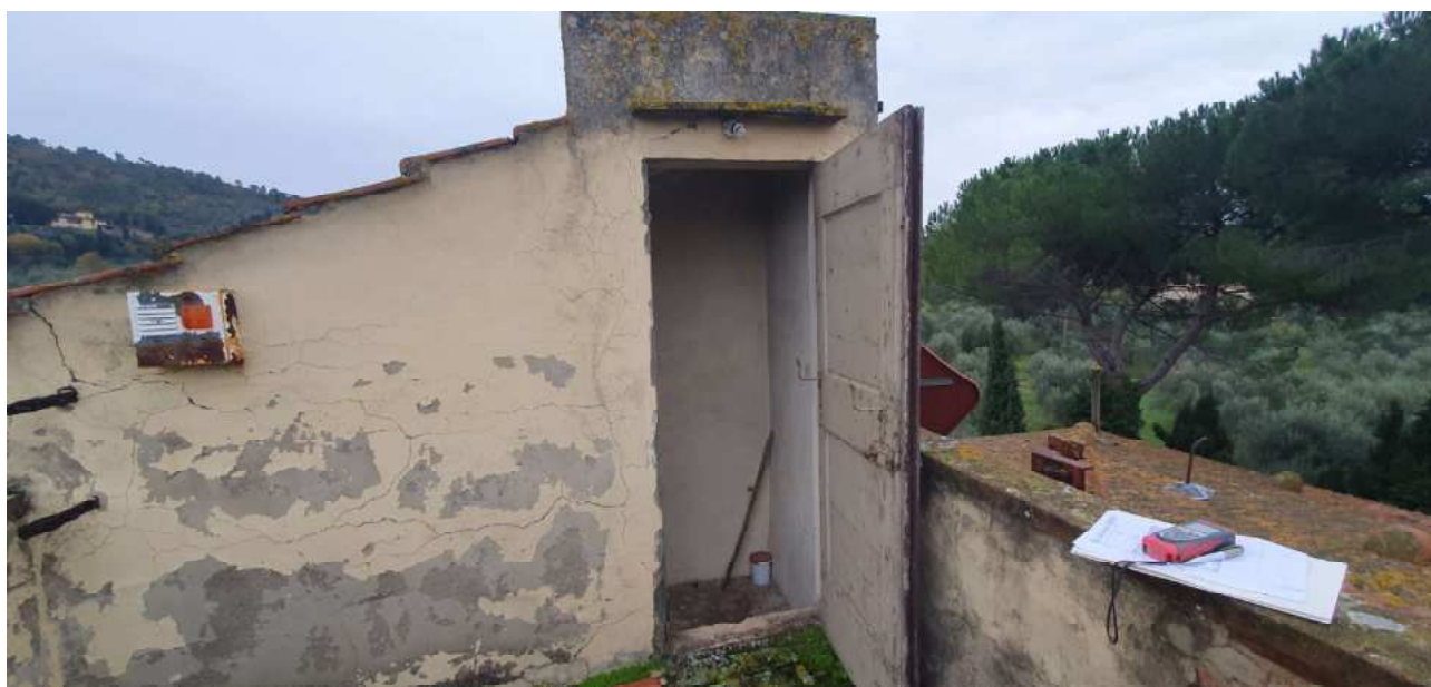
FOTO 29 – Ripresa fotografica dell'uscita sulla terrazza in copertura
