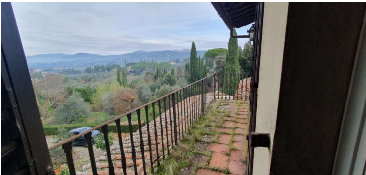
FOTO 25 – Ripresa fotografica del terrazzo dei servizi igienici
