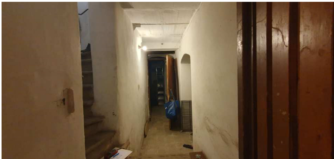
FOTO 27 – Ripresa fotografica del disimpegno delle cantine
