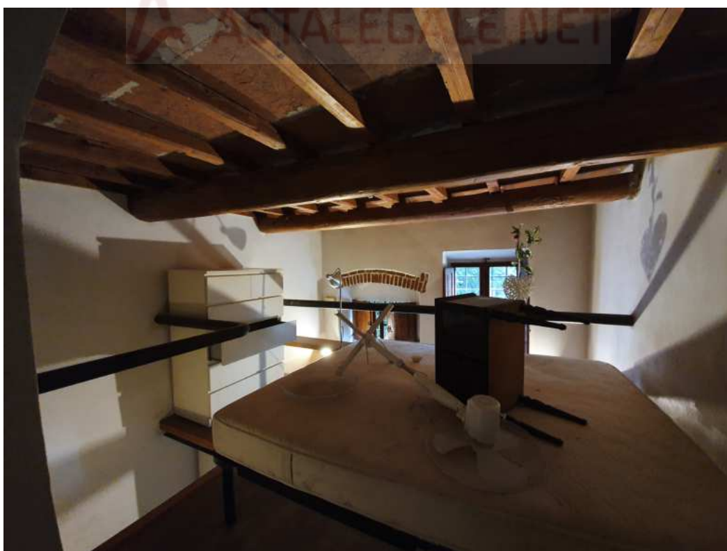
FOTO 10 – Ripresa fotografica del soppalco
