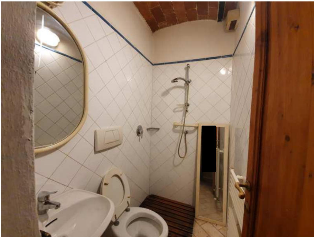
FOTO 11 – Ripresa fotografica del servizio igienico
