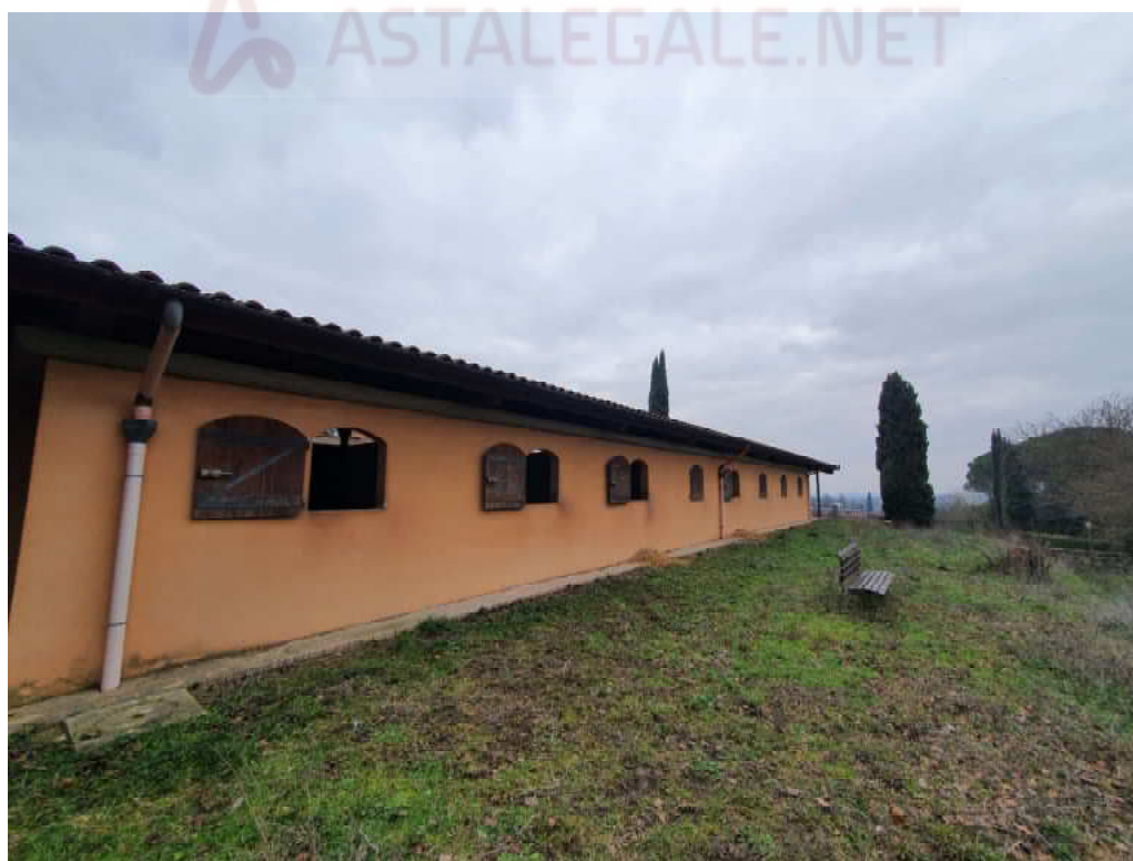
FOTO 08 – Ripresa fotografica blocco A Maneggio/stalla (retro)
