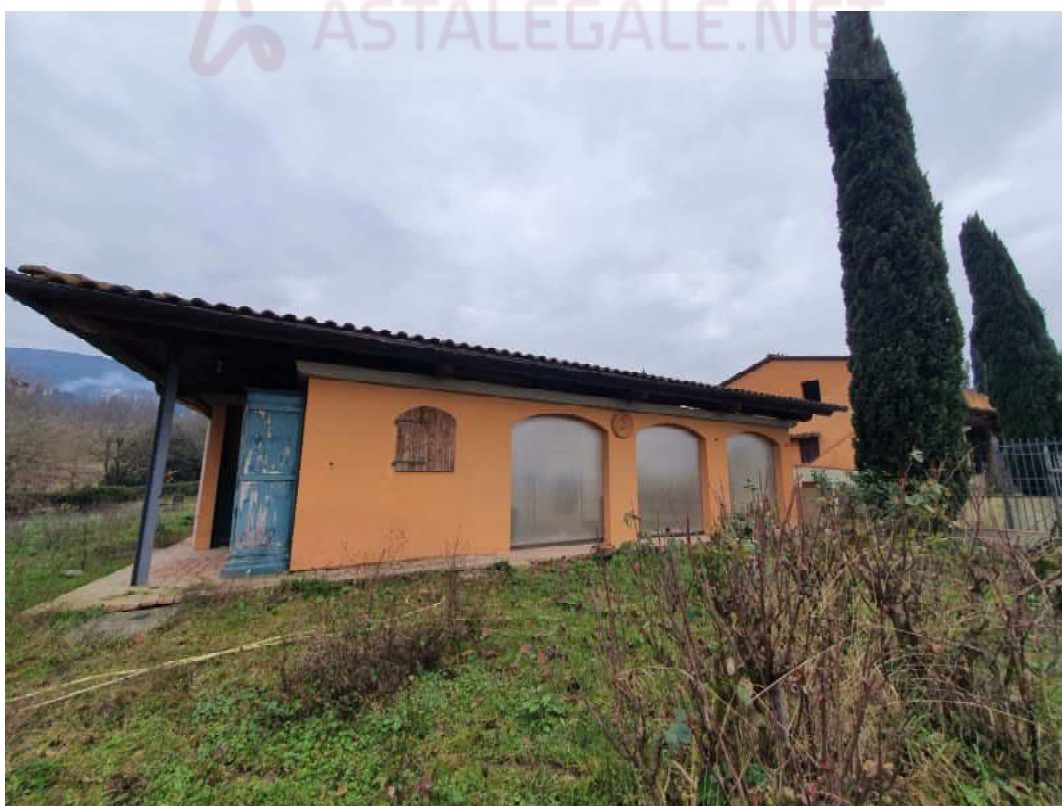
FOTO 10 – Ripresa fotografica blocco A Maneggio/stalla
