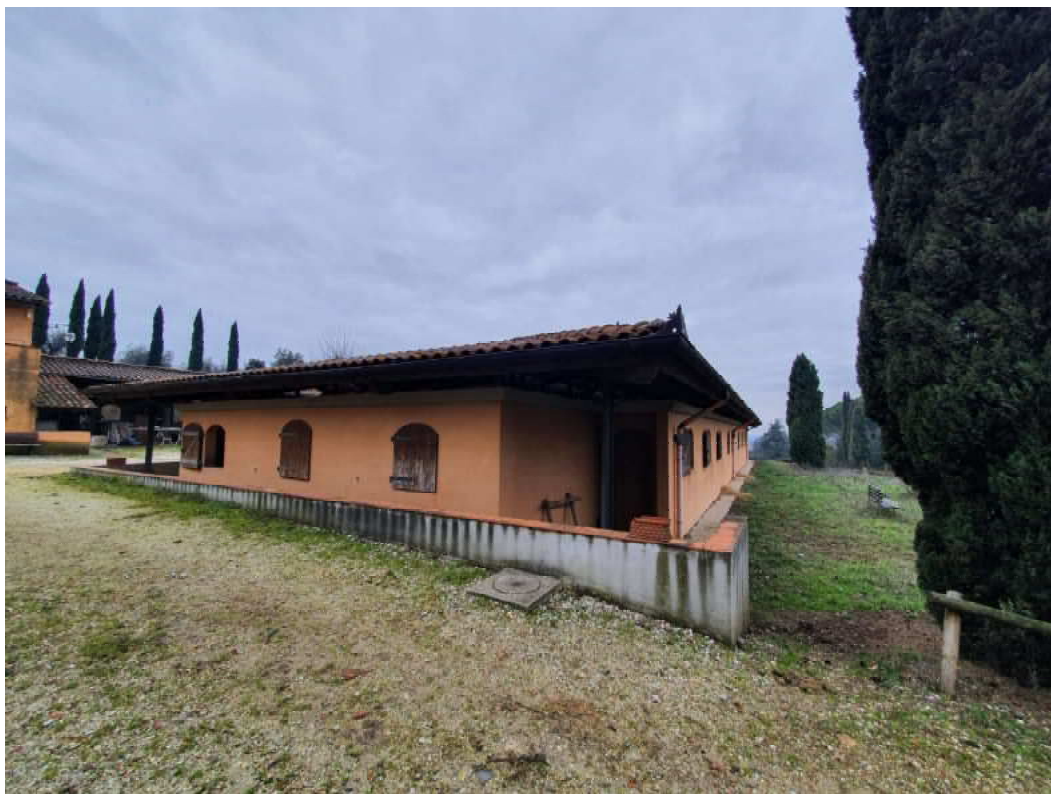
FOTO 07 – Ripresa fotografica blocco A Maneggio/stalla (retro)
