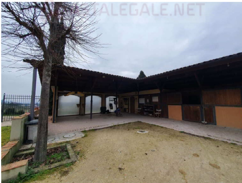
FOTO 04 – Ripresa fotografica blocco A Maneggio/stalla
