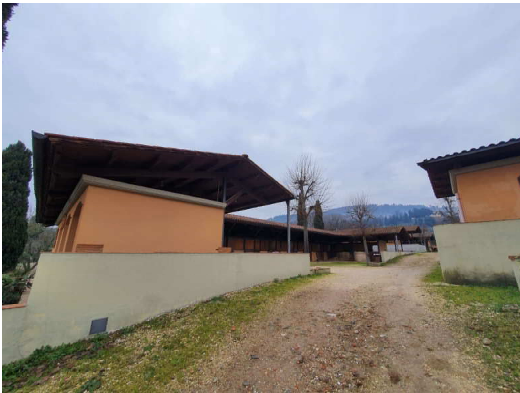
FOTO 03 – Ripresa fotografica blocco A Maneggio/stalla
