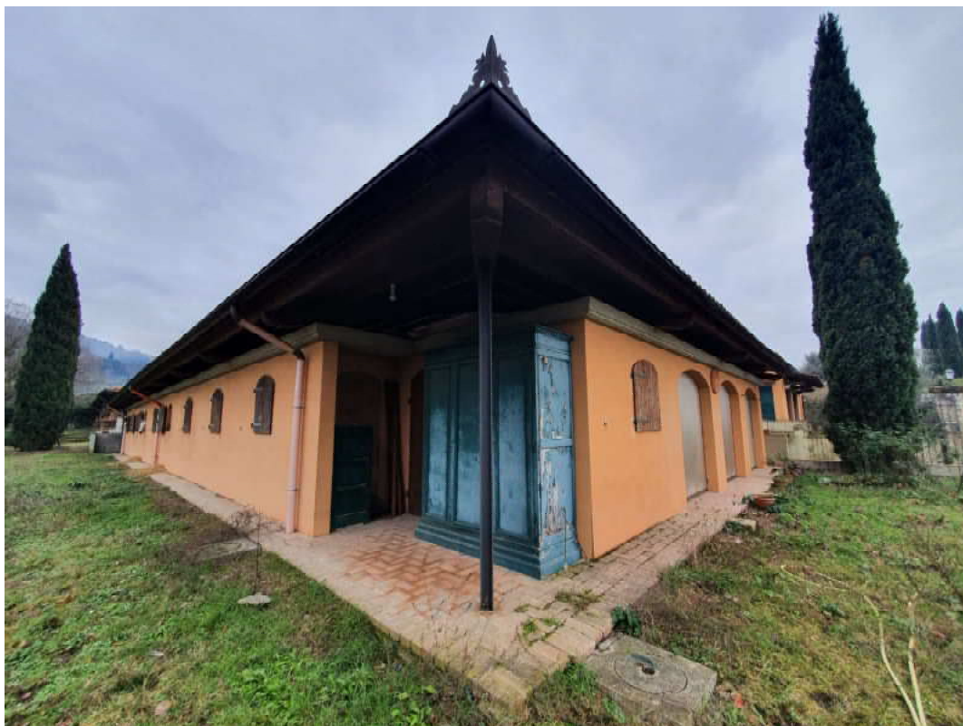
FOTO 09 – Ripresa fotografica blocco A Maneggio/stalla (retro)
