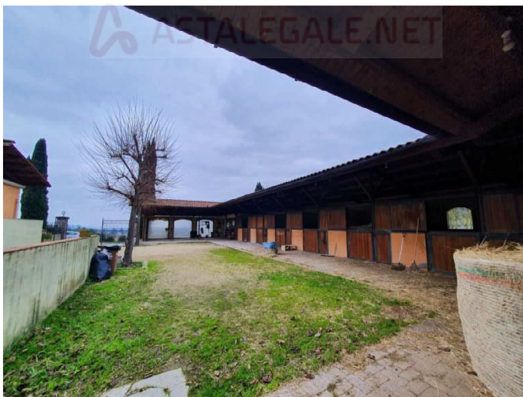
FOTO 06 – Ripresa fotografica blocco A Maneggio/stalla
