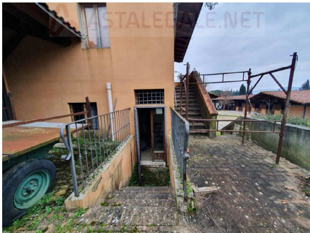
FOTO 26 – Ripresa fotografica blocco C, piano terra
