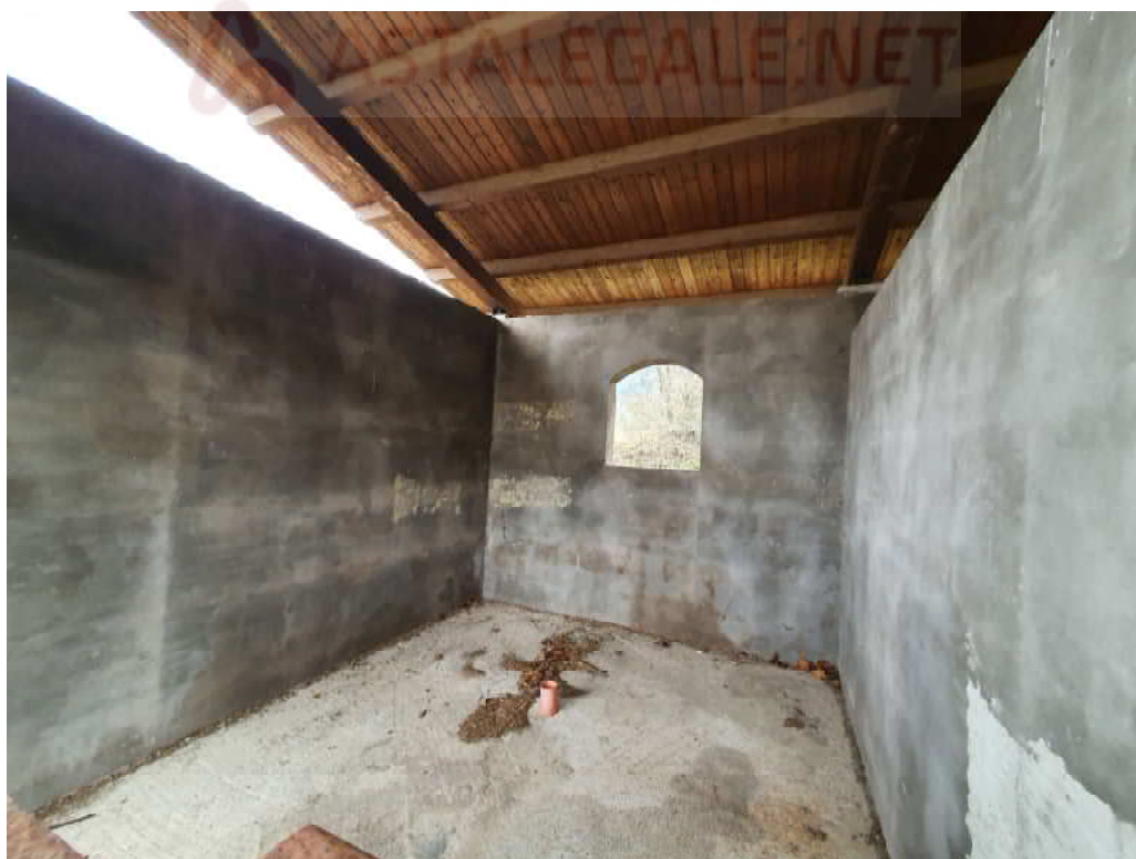
FOTO 40 – Ripresa fotografica blocco C, stalle singole
