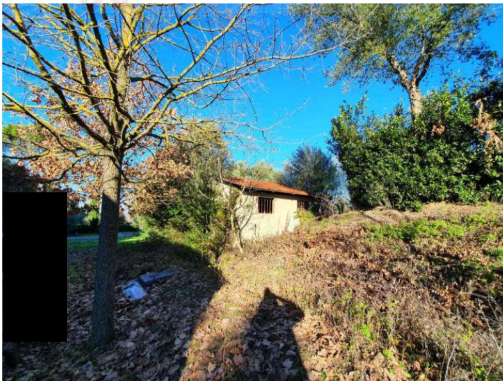
FOTO 22 – Ripresa fotografica ex stalle oggetto di ordinanza di demolizione
