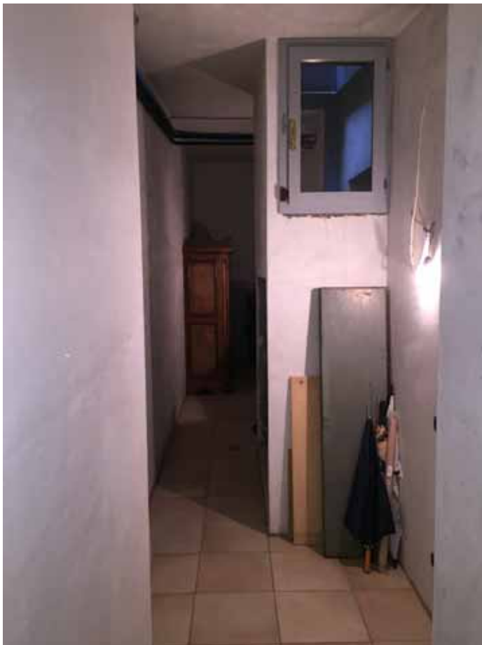
Foto 73 (zona abusiva da ripristinare)
