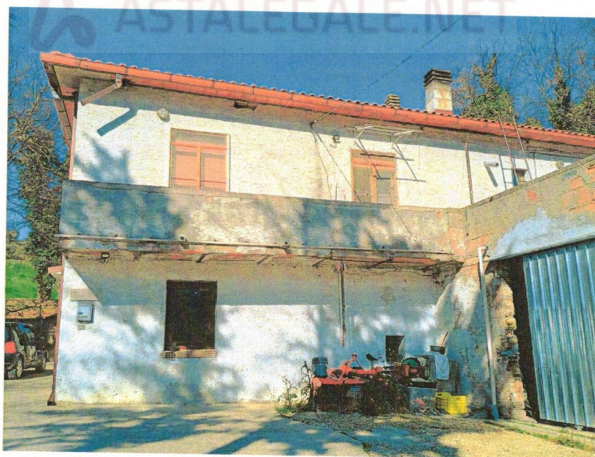
Foto n. 2: prospetto laterale fabbricato
