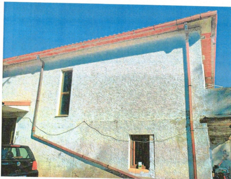
Foto n. 1: prospetto principale fabbricato
