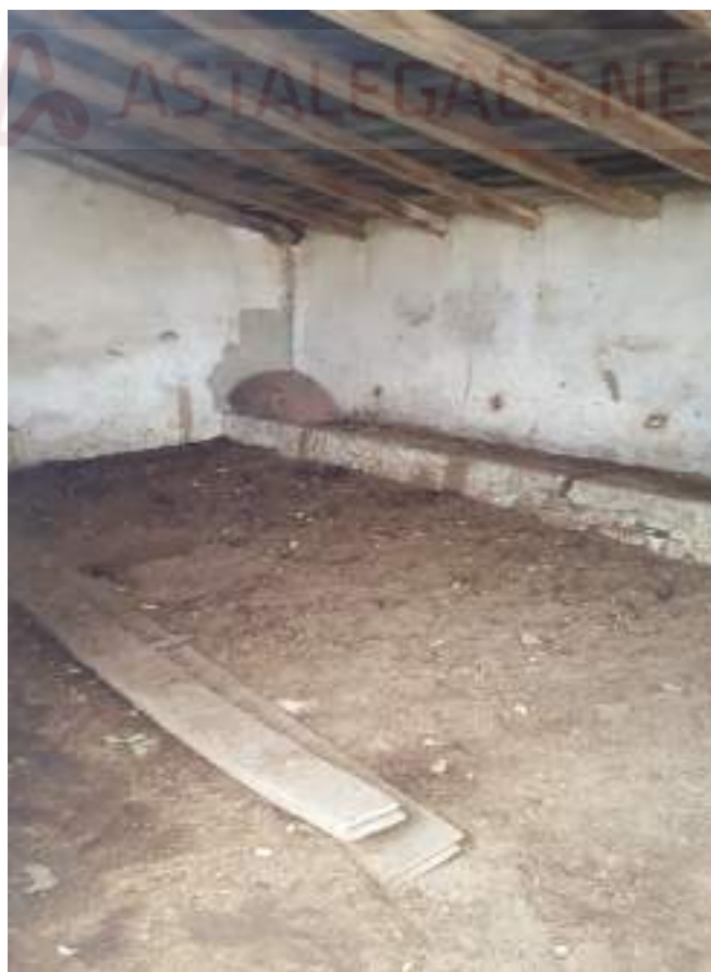
FOTO N. 14 – IMMOBILE N. 1 – FONDO C.DA S.IPPOLITO – FABBRICATO PART. 19 - STALLA
