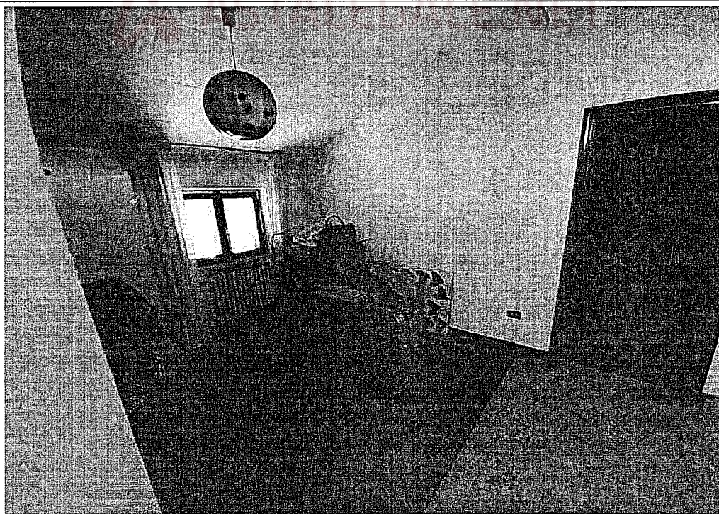
SOGGIORNO PARETE RIMOSSA
