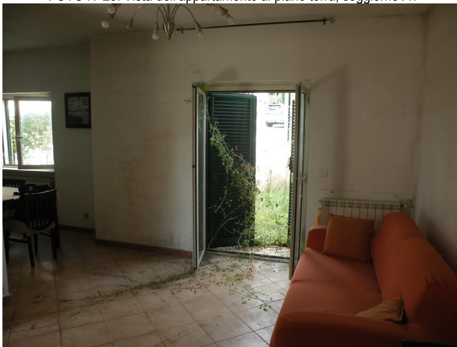
FOTO N°23: Vista dell'appartamento al piano terra, soggiorno /1.
