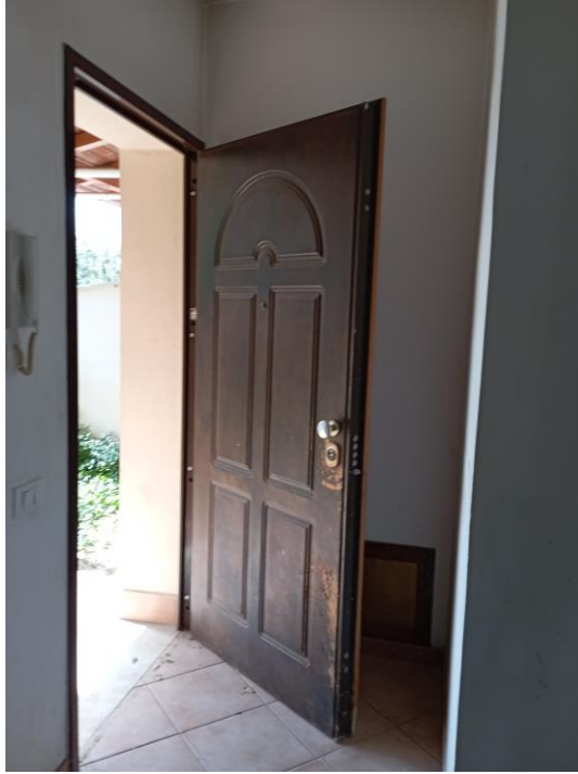
FOTO N°20: Vista dell'appartamento al piano terra, portone di ingresso.
