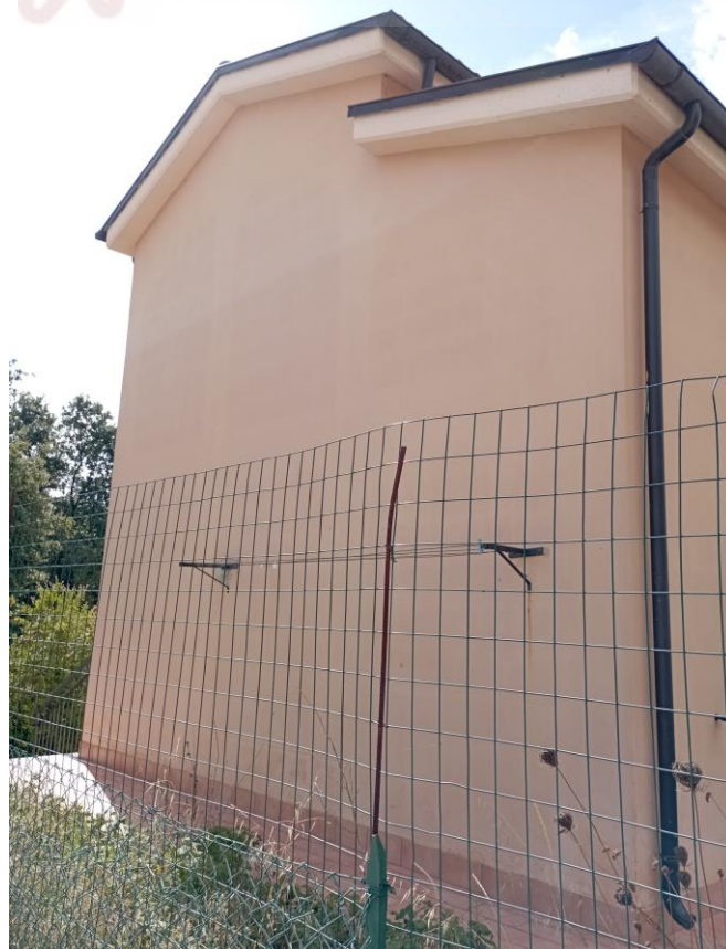
FOTO N°6: Prospetto Nord del fabbricato.
