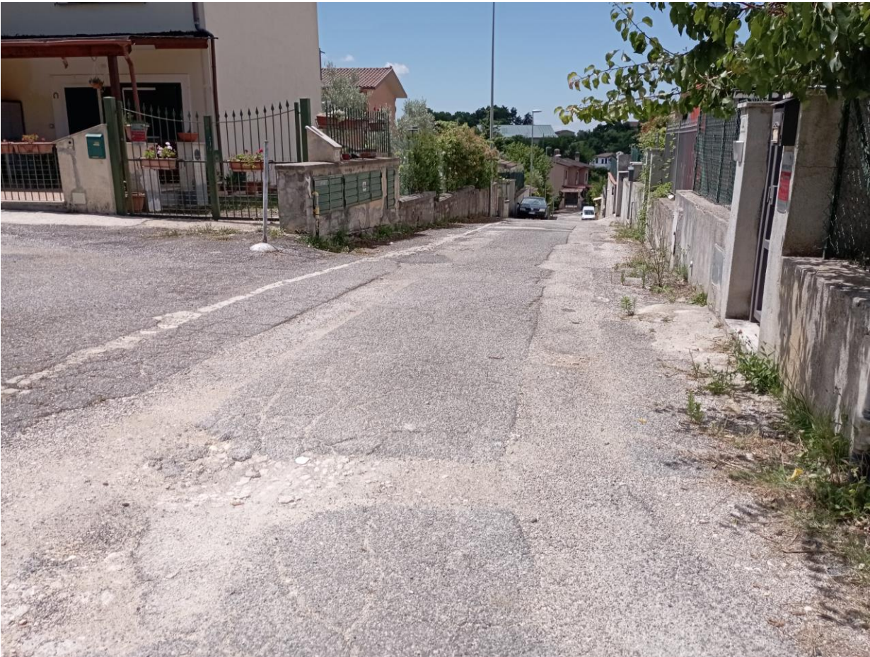
FOTO N°1: Vista della strada di accesso all'immobile.
