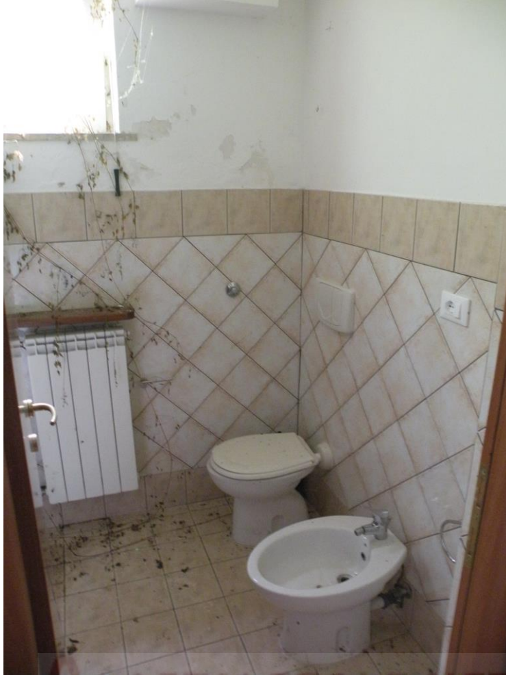
FOTO N°12: Vista dell'appartamento al piano seminterrato, bagno/1.
