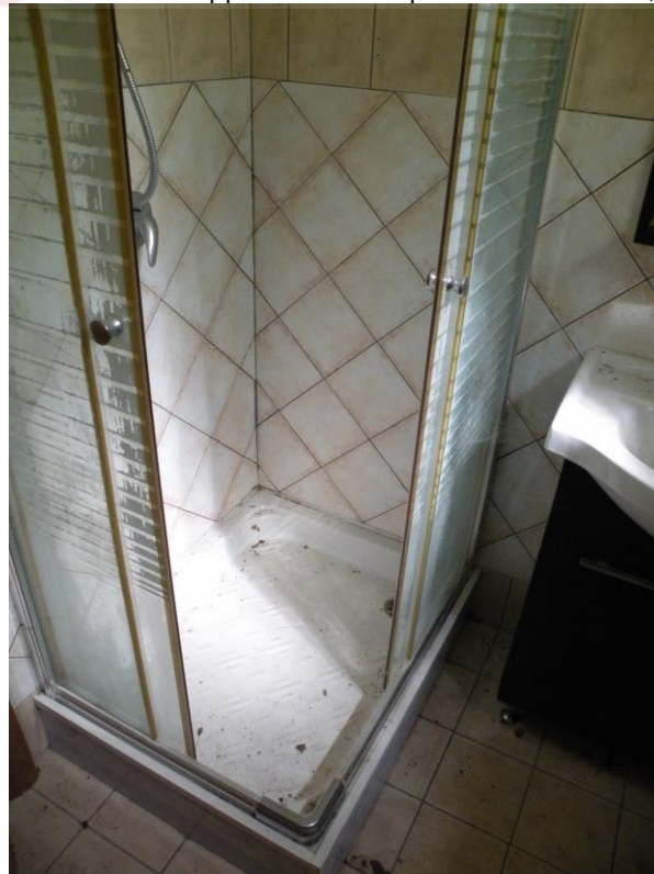
FOTO N°13: Vista dell'appartamento al piano seminterrato, bagno/2.
