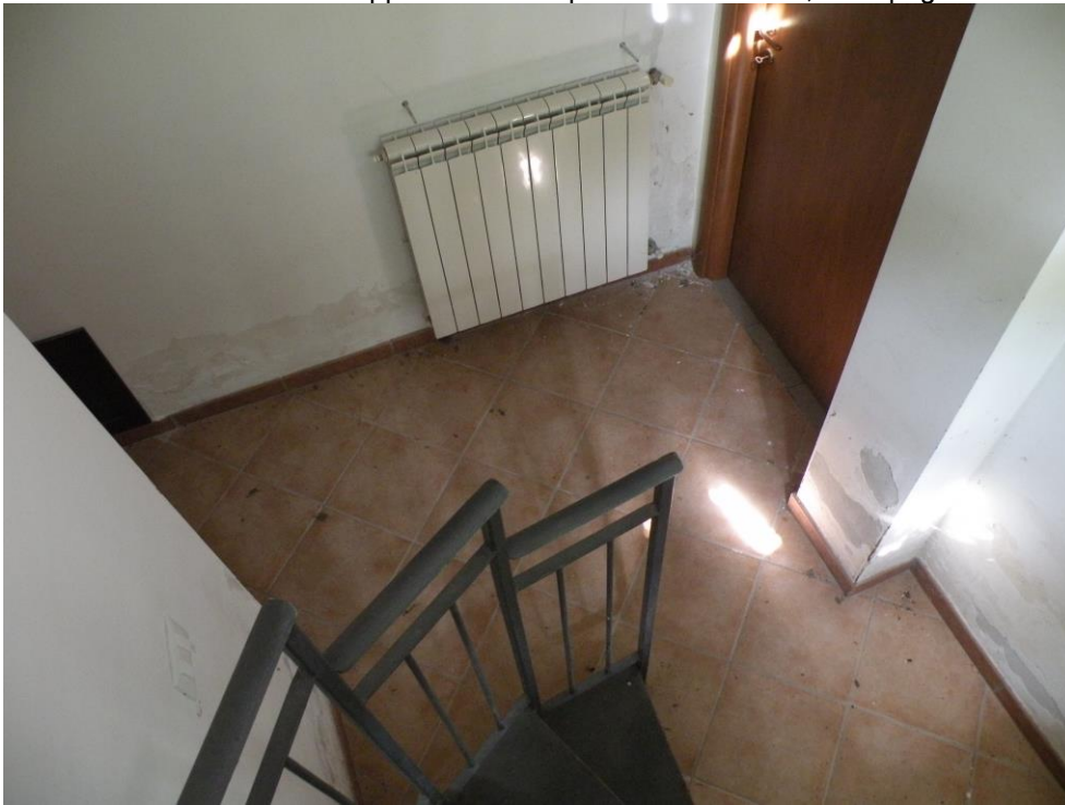
FOTO N°9: Vista dell'appartamento al piano seminterrato, disimpegno/1.
