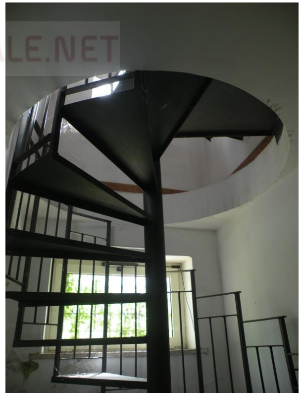
FOTO N°11: Vista dell'appartamento al piano seminterrato, vano scala.
