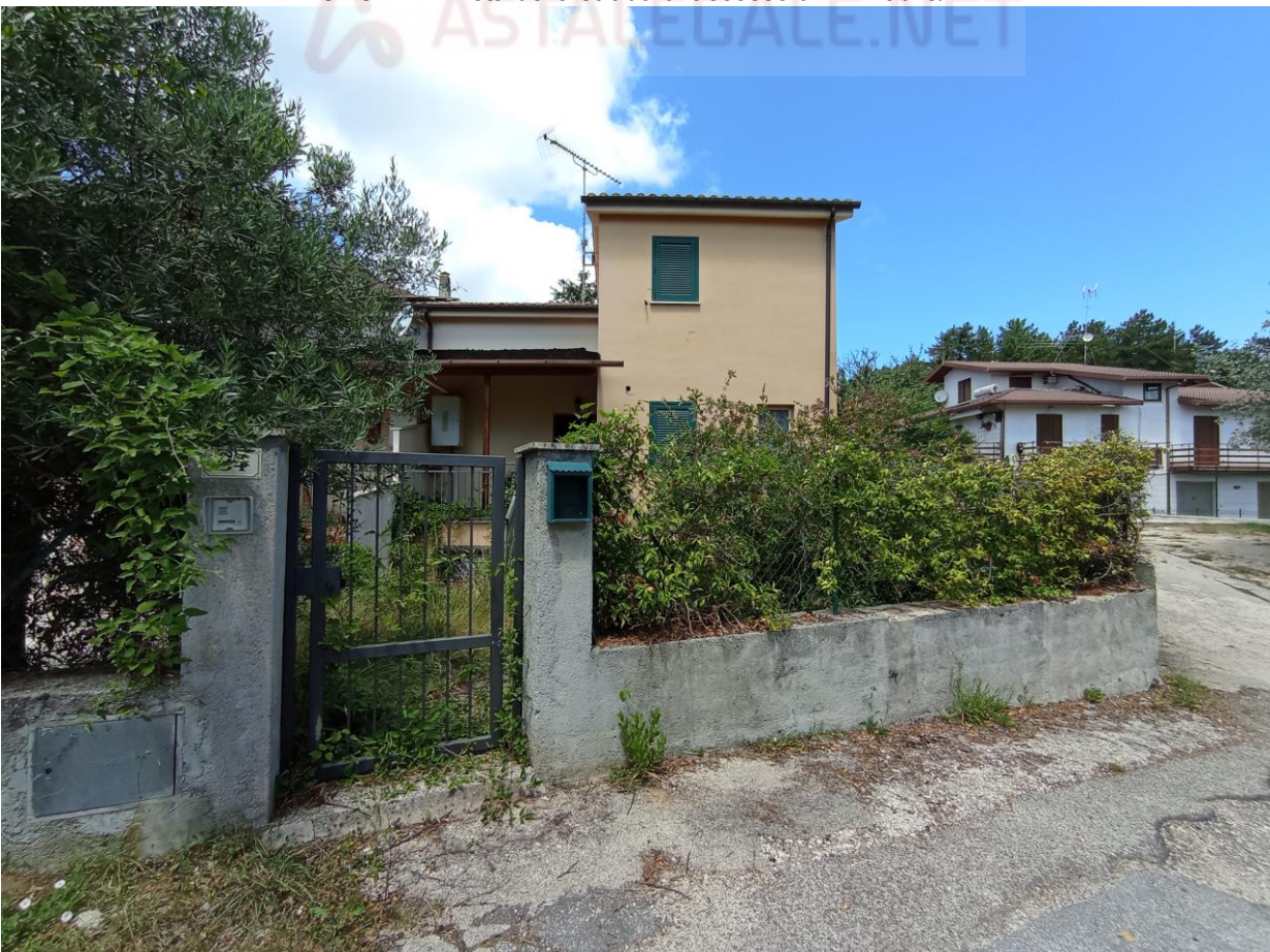
FOTO N°2: Vista della strada di accesso all'immobile/2.
