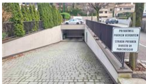
Rampa di accesso al piano interrato
