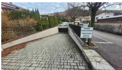
Rampa di accesso al piano interrato
