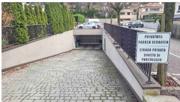
Rampa di accesso ai garage
