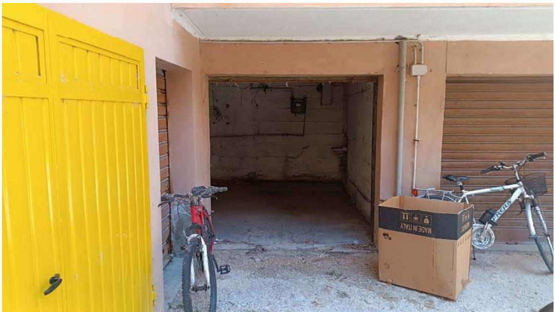
006 - PARTICOLARE ACCESSO MAGAZZINO
