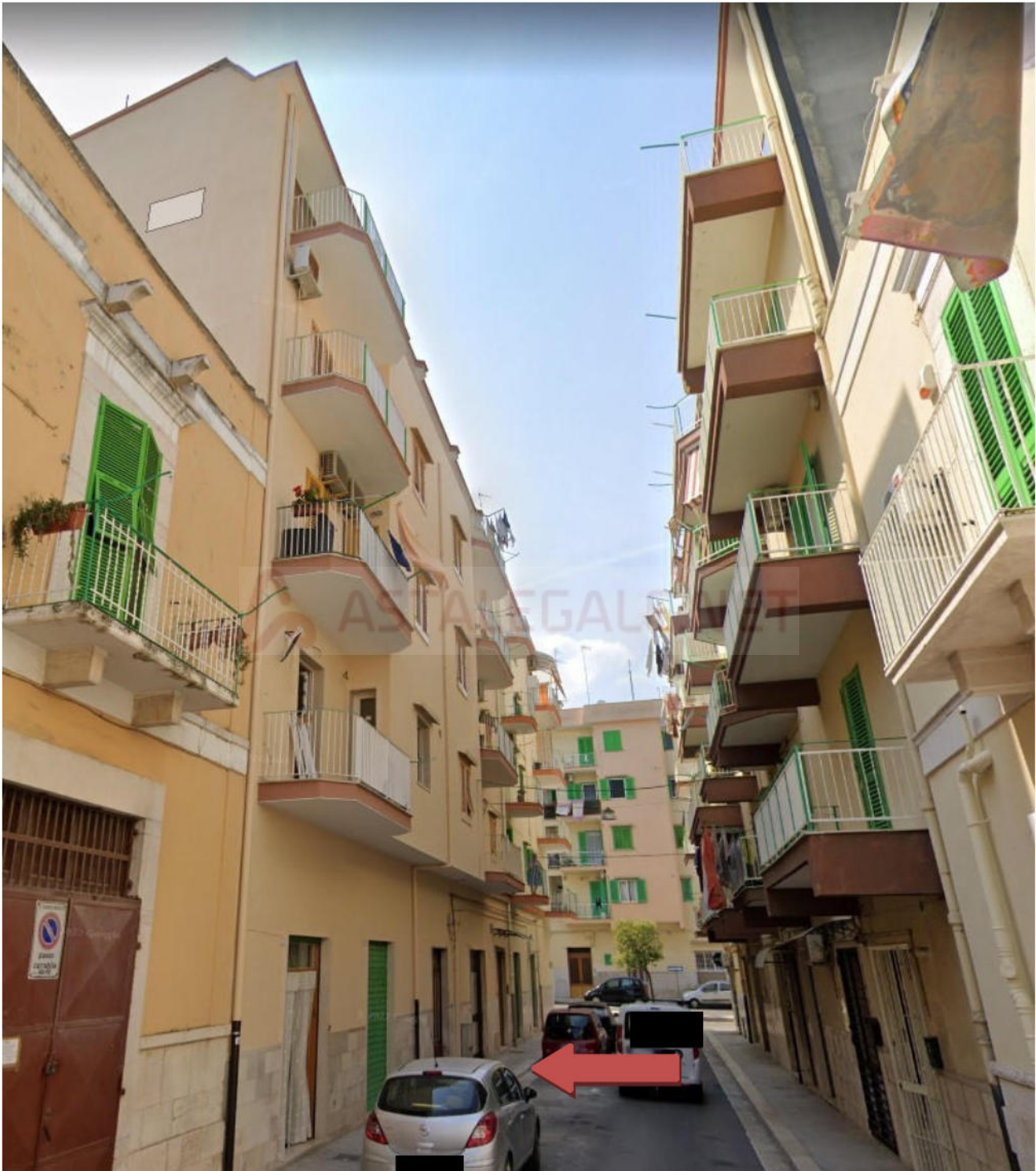
Foto 1 Vista Edificio Residenziale da via Capotorti n°115
