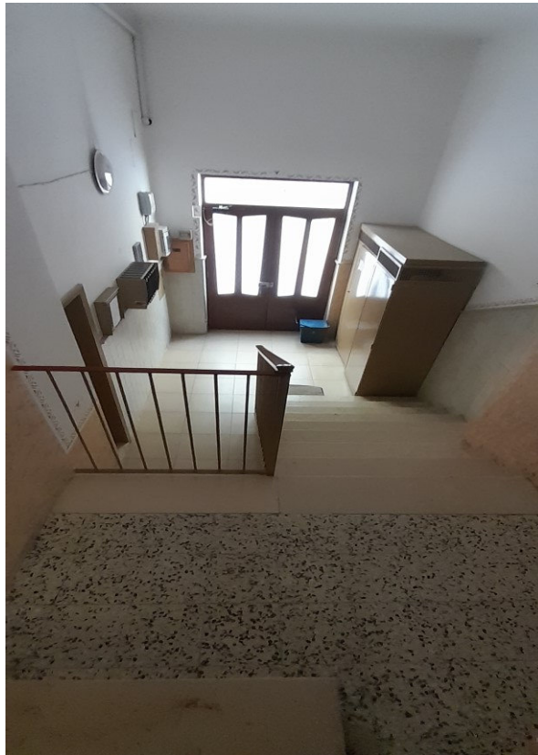
Foto 3 Vista Interna Androne Ingresso Condominiale
