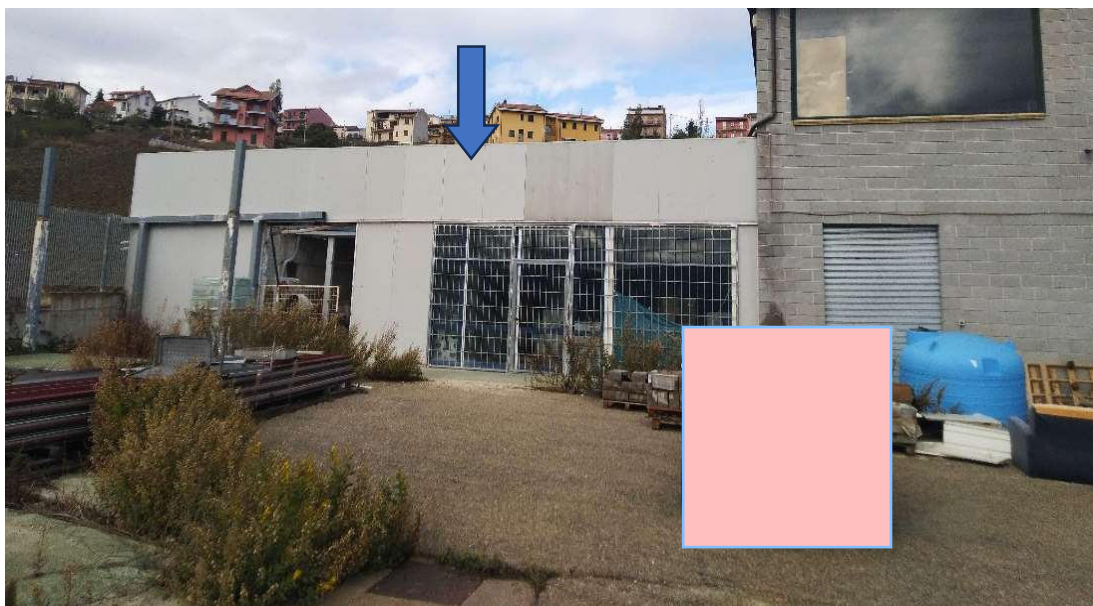
RIF. 2 TAB. 1 - DEPOSITO VISTA LATO ESTERNO
