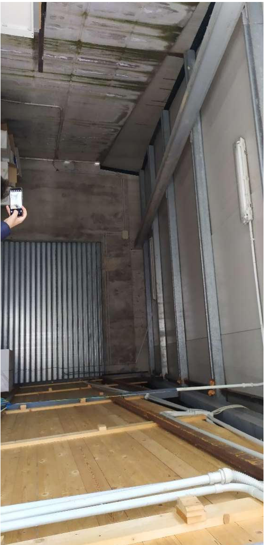
RIF. 5 TAB. 1 - TETTOIA IN ACCIAIO E LAMIERA – PARTE RIENTRATA
