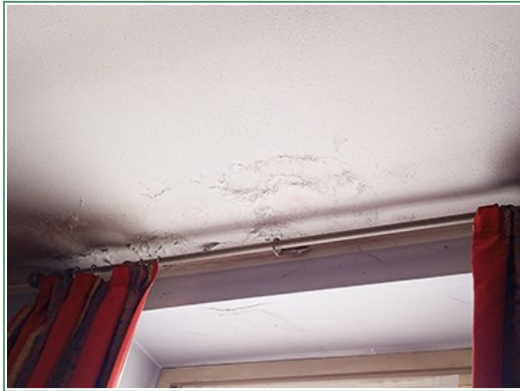
Soffitto della camera a piano primo
