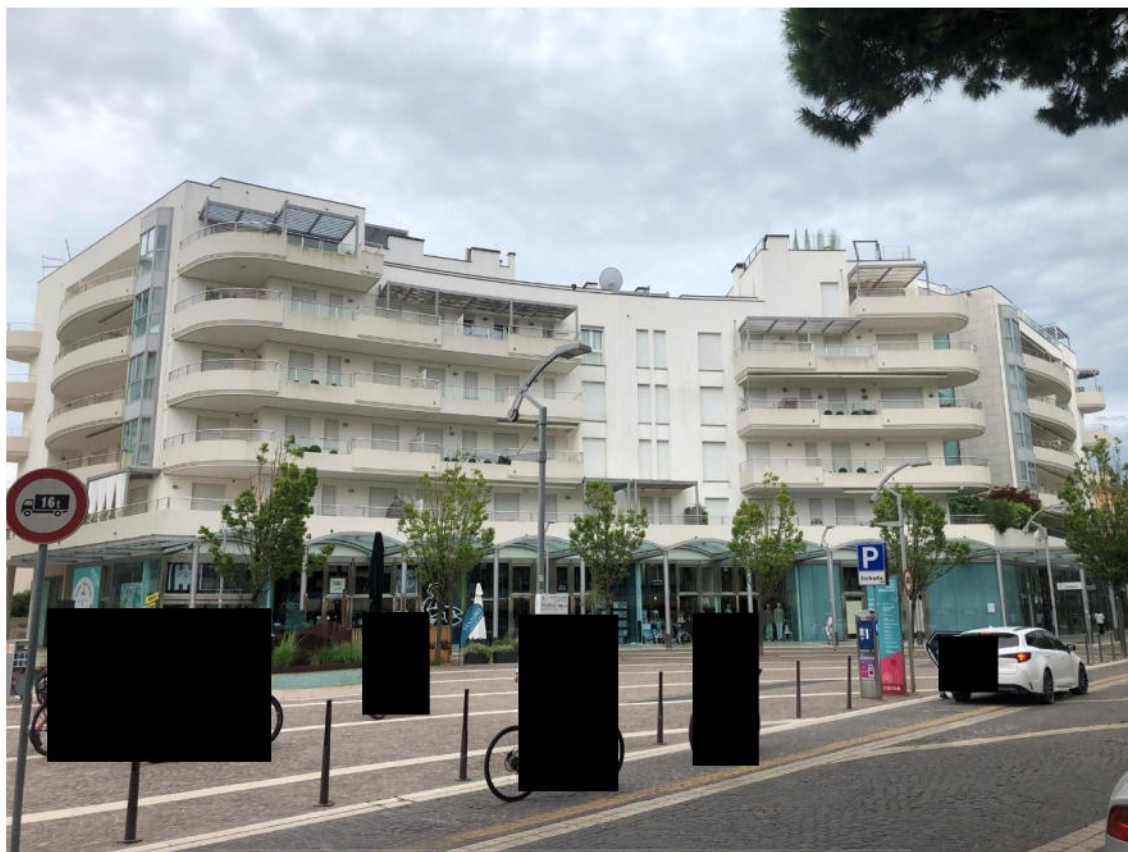
Figura 6 – Facciata del fabbricato su piazza G. Carducci e via Bafile
