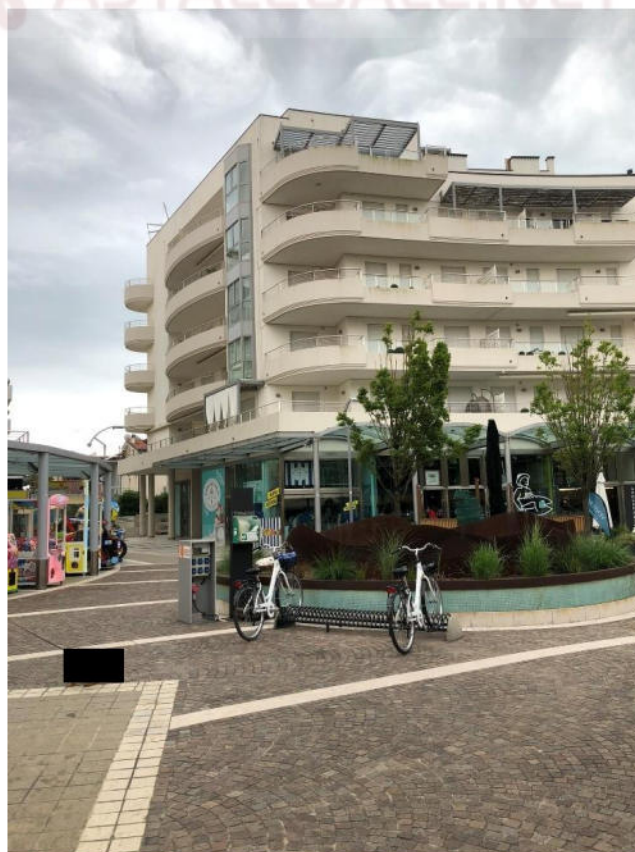
Figura 7 – Angolo nord del fabbricato
