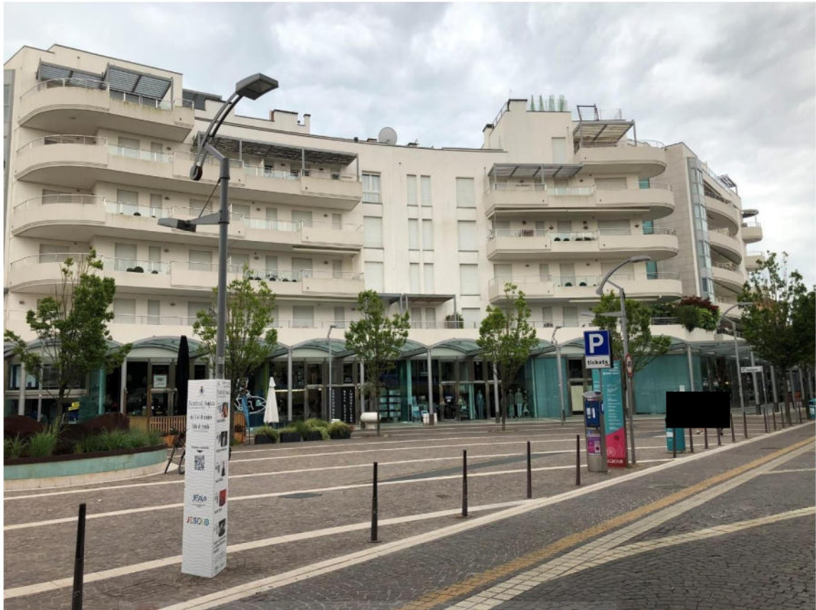
Figura 8 – Facciata del fabbricato su piazza G. Carducci e via Bafile
