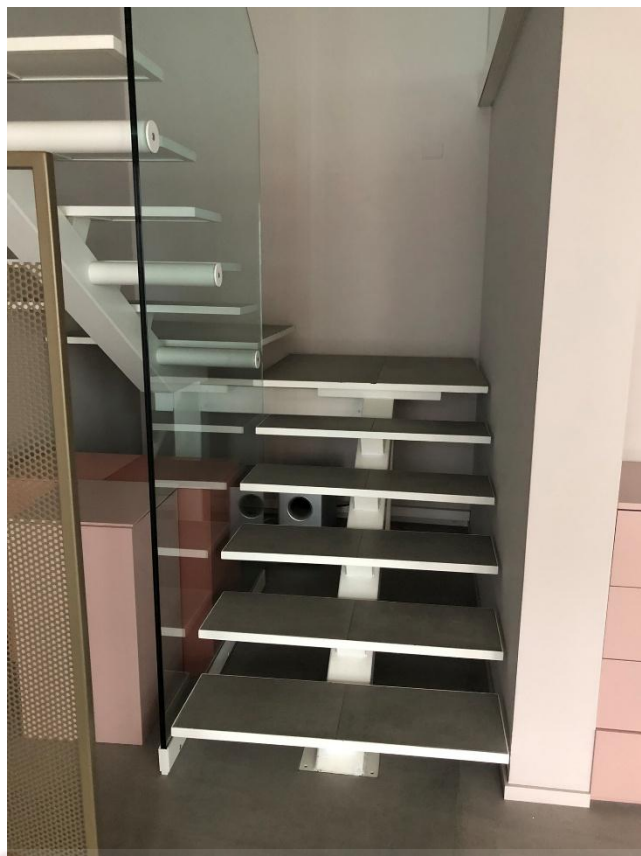
Figura 23 – Scala da piano terra ad ammezzato
