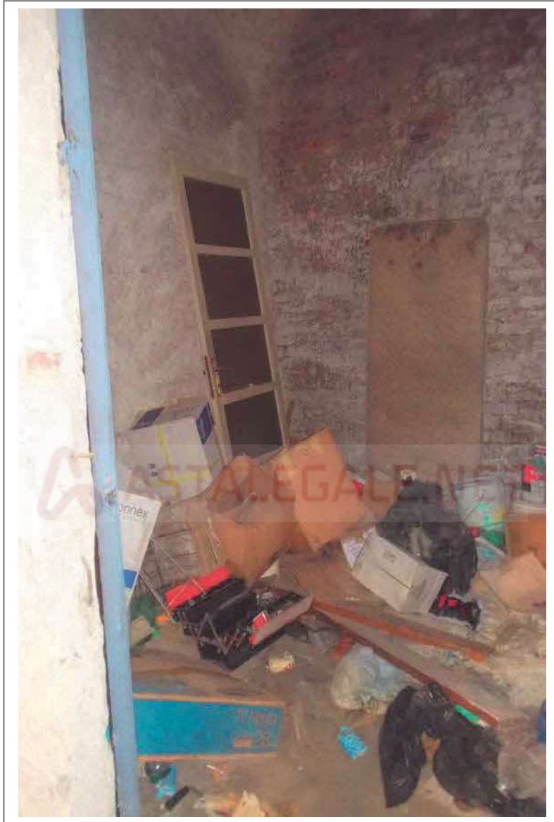
Fotografia n. 12 = Vista interna della cantina
