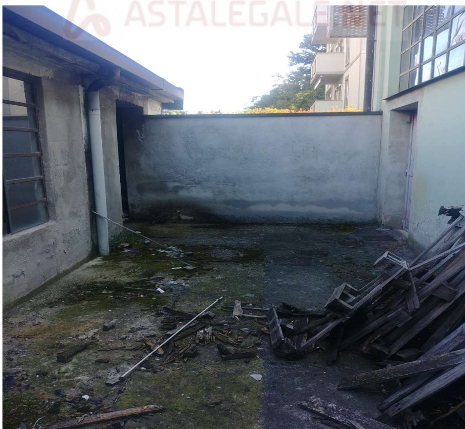
- Vista cortile comune uscita di sicurezza - 4
