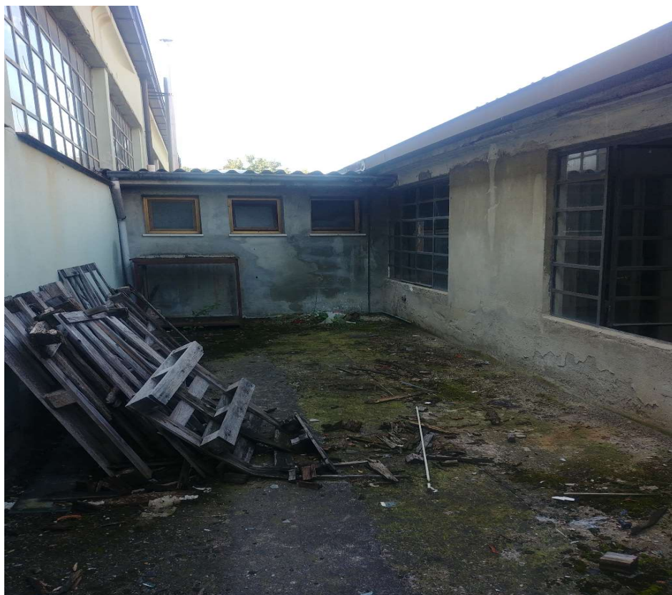
- Vista cortile comune uscita di sicurezza - 3
