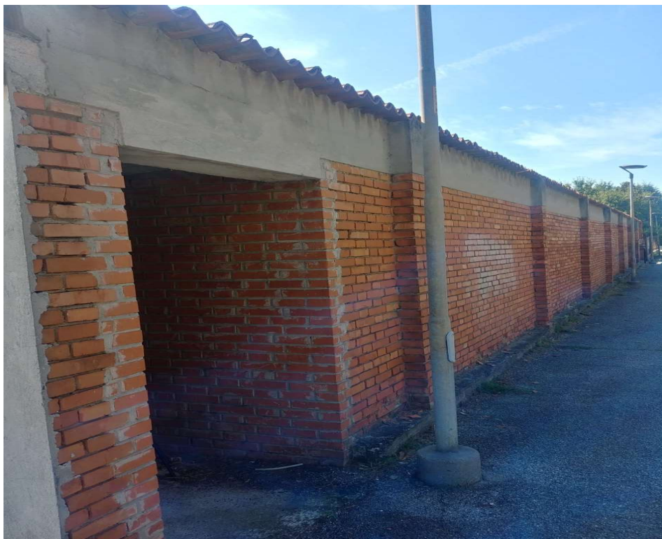
- Vista dalla via Solera/uscita di sicurezza - 2
