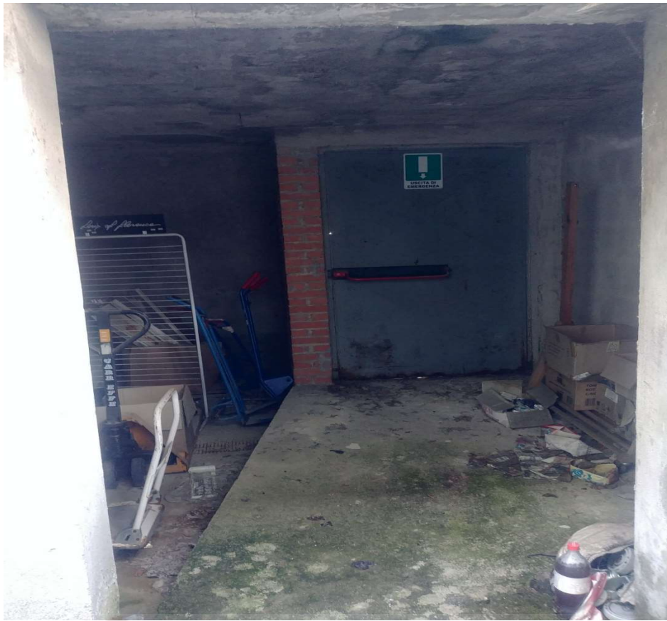
- Vista interna uscita di sicurezza – 5
