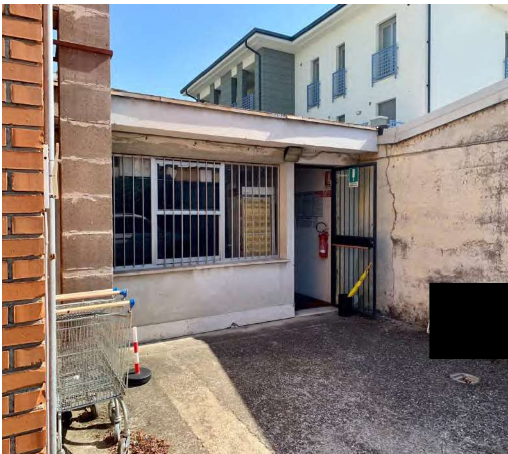
- Vista dal cortile sud-est - 3
