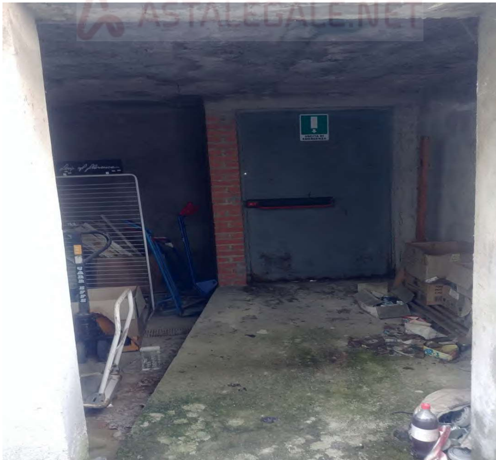
- Vista interna uscita di sicurezza - 8
