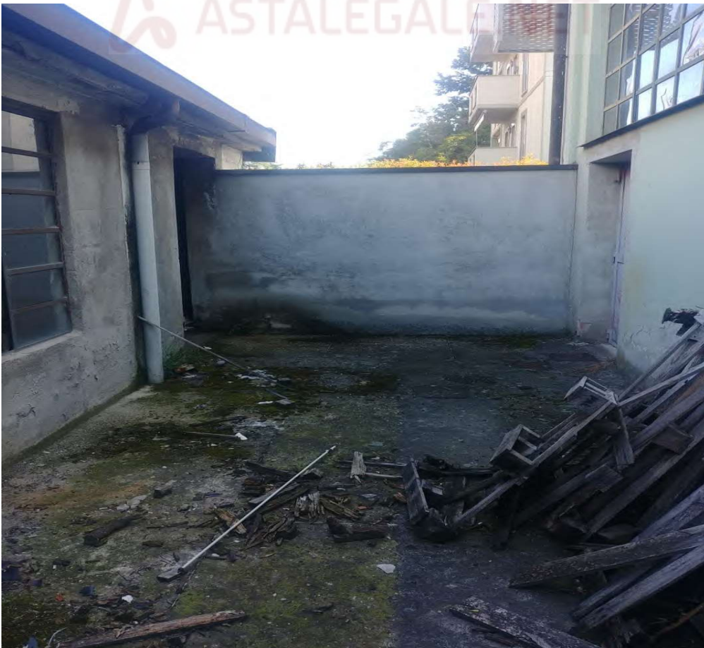
- Vista cortile comune uscita di sicurezza - 6
