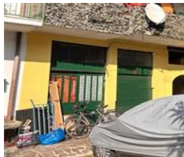
stato dei luoghi al momento della perizia
