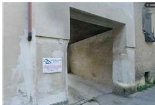
androne d'ingresso alla corte comune
