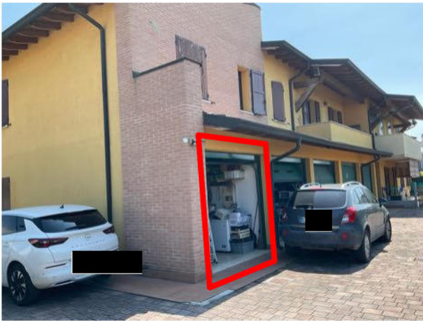
foto 3 - area di manovra comune e autorimessa bene 3
