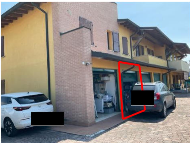
foto 3 - area di manovra comune e autorimessa bene 2
