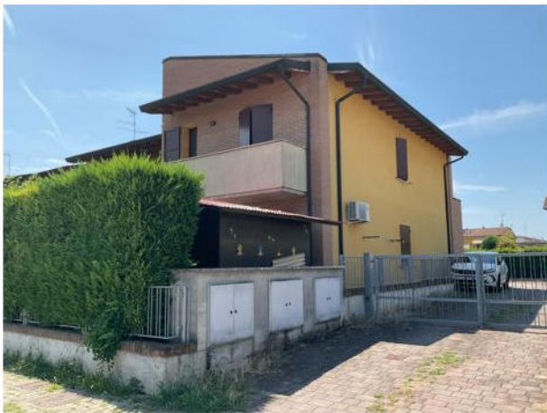
foto 1 - ingresso area di manovra comune
