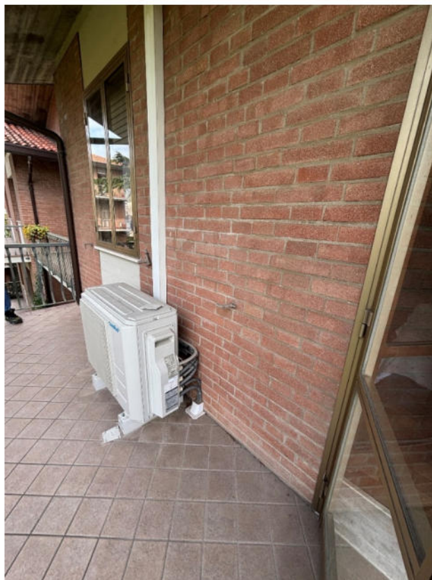
Vista balcone secondo piano
