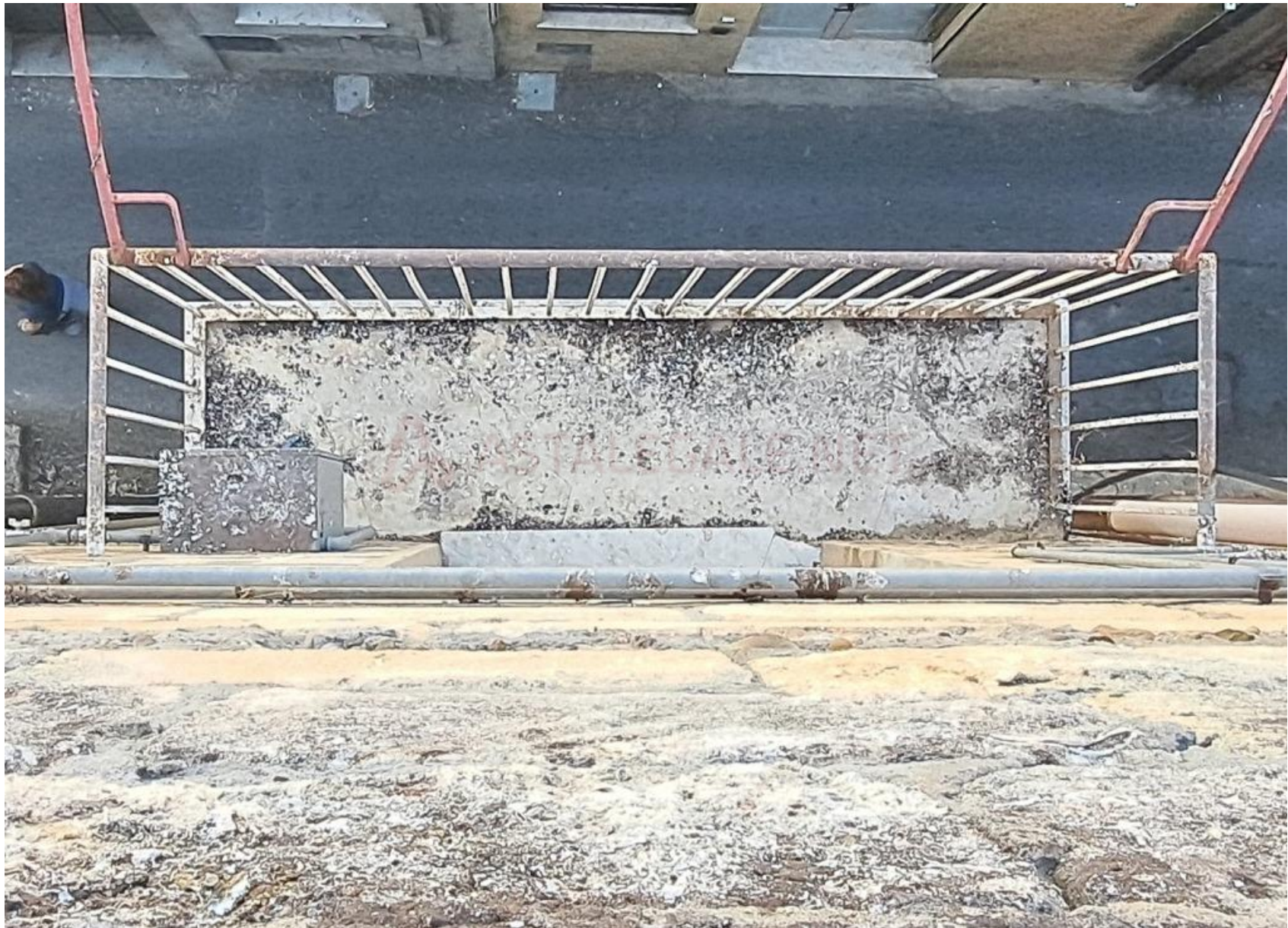
Foto 13 – balcone al secondo piano
