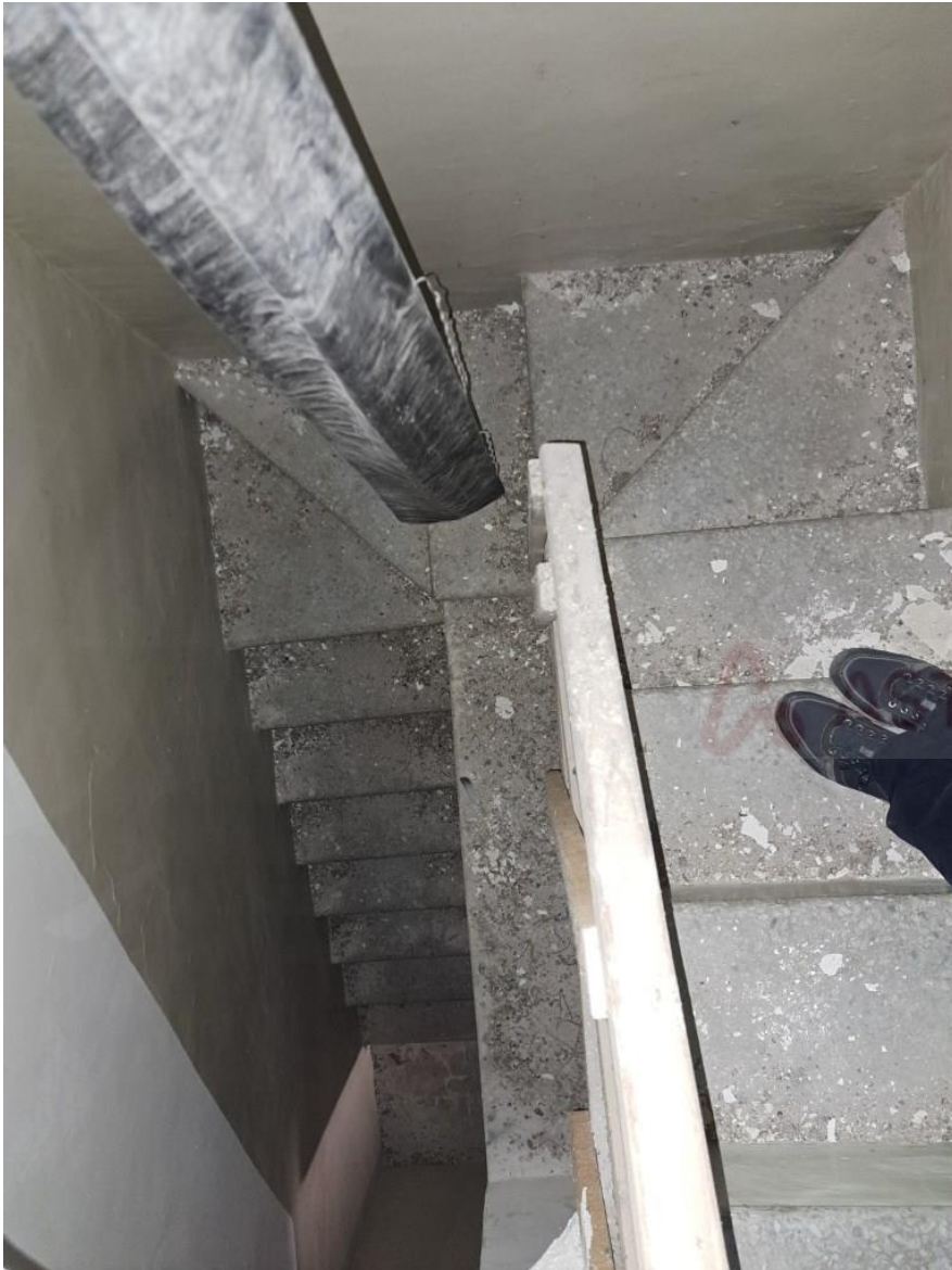
Foto 14 – vano scala interno all'alloggio
