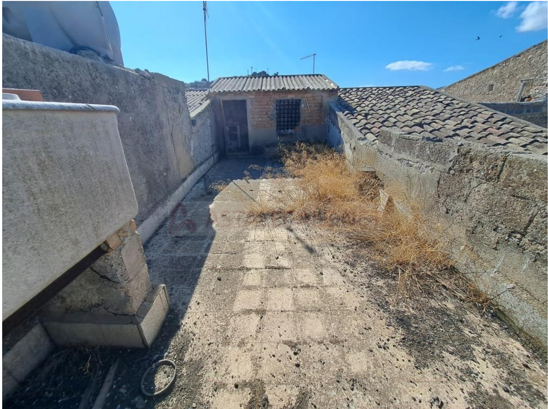
Foto 16 – Terrazza al terzo piano e torrino scala
