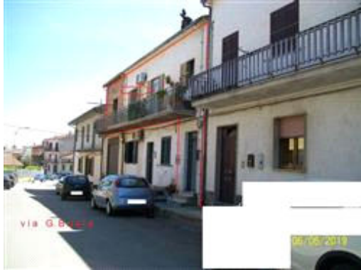
Foto n° 1 - Prospetto su via G. Basta.
