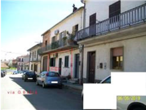
Foto n° 1 - Prospetto su via G. Basta.
