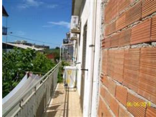
Foto n° 2 - Prospetto su corte retrostante.
