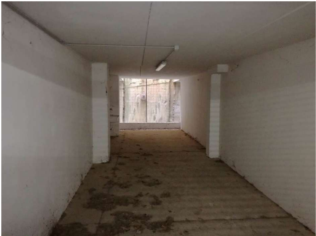
Foto 50 GARAGE n.16 P.1° INTERRATO – SUB55
