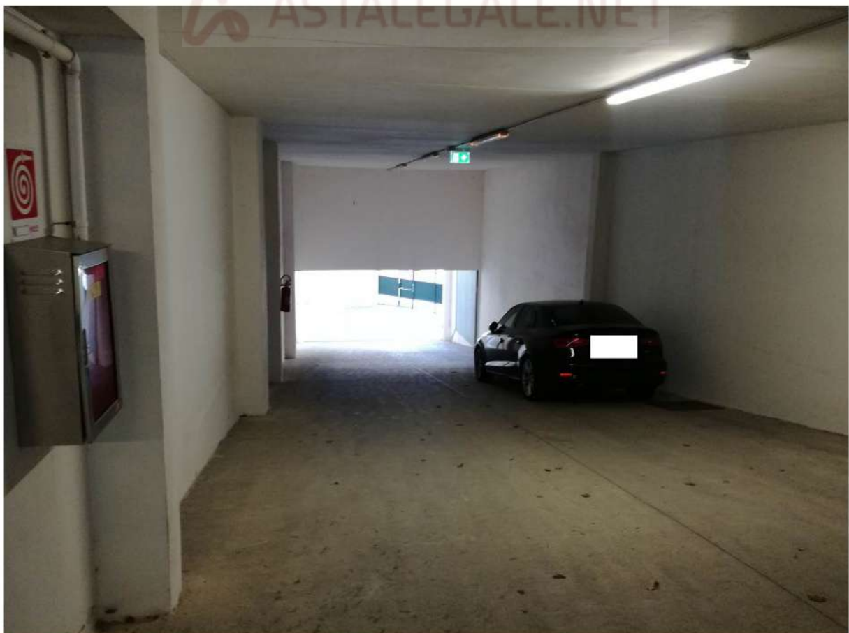
Foto 46 USCITA/RAMPA ACCESSO P.1° INTERRATO
