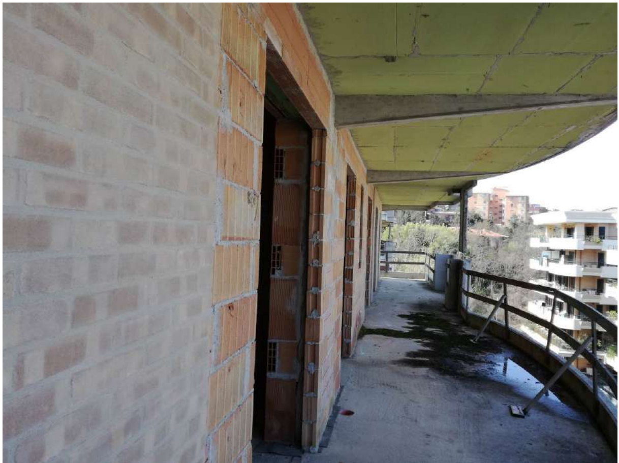
Foto 19 balconi allo stato grezzo nei due edifici
