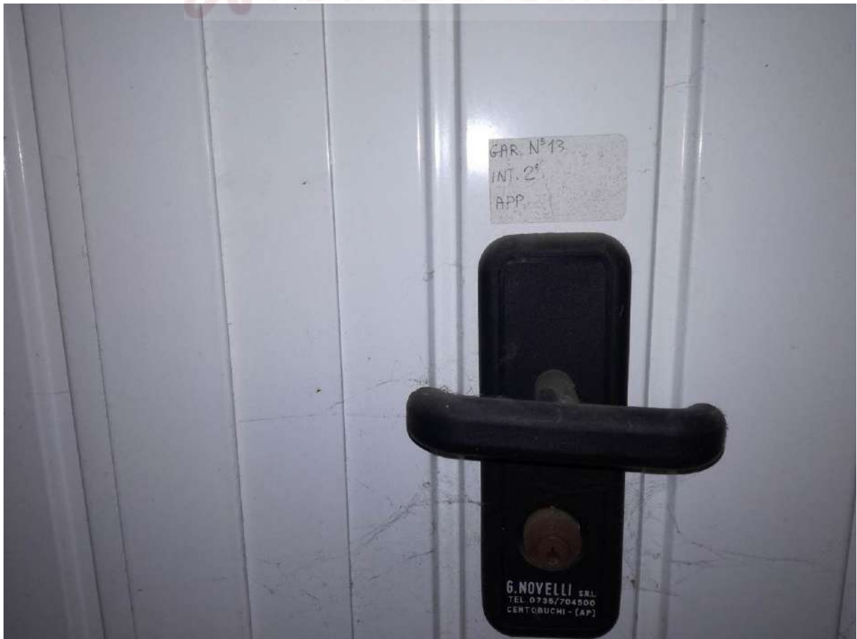
Foto 57 GARAGE n.13 P.2° INTERRATO – SUB69
