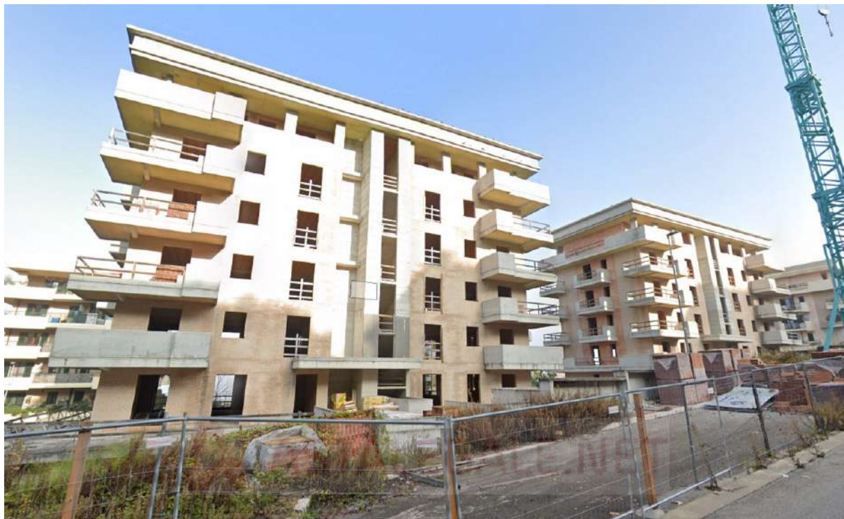
Foto 1 vista d'insieme prospetto sud
