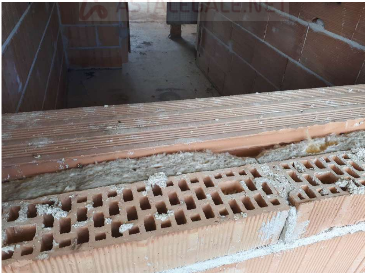
Foto 22 tamponatura esterna realizzata con isolante termico
