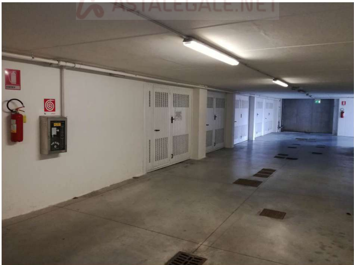
Foto 55 SPAZI DI MANOVRA P.2° INTERRATO
