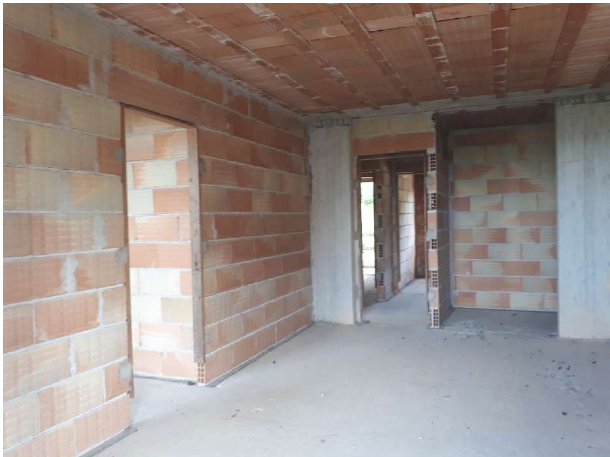
Foto 21 interno allo stato grezzo nei due edifici, porzioni con tamponature e divisori interni realizzati
