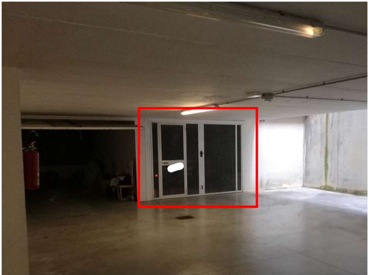
Foto 63 GARAGE n.11 P.2° INTERRATO – SUB64 (OCCUPATO)
