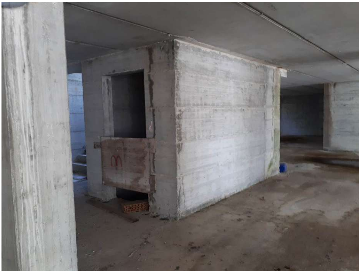
Foto 35 piano interrato S1 allo stato grezzo, blocco ascensore
