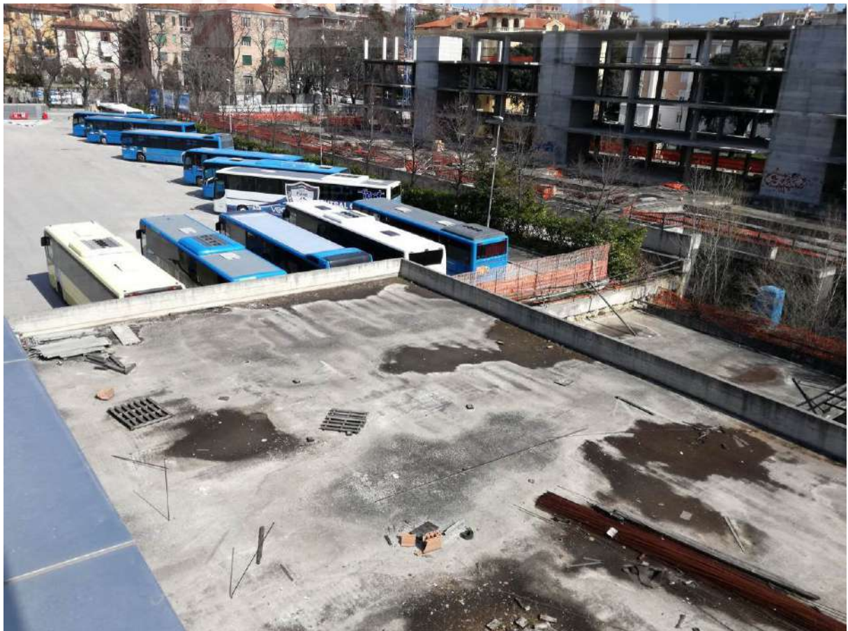
Foto 15 lastrico solare (sub3)
