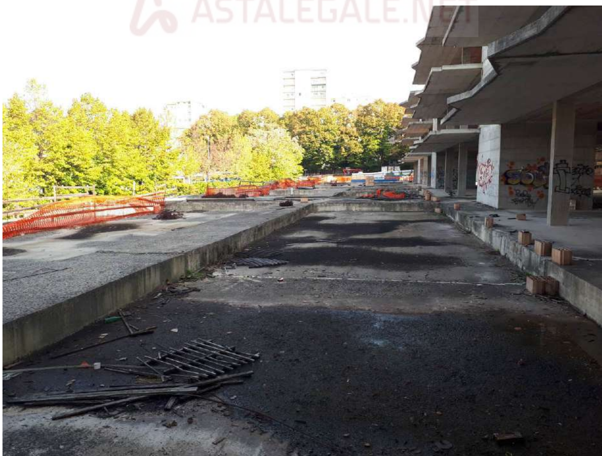
Foto 21 spazi esterni lungo il prospetto ovest
