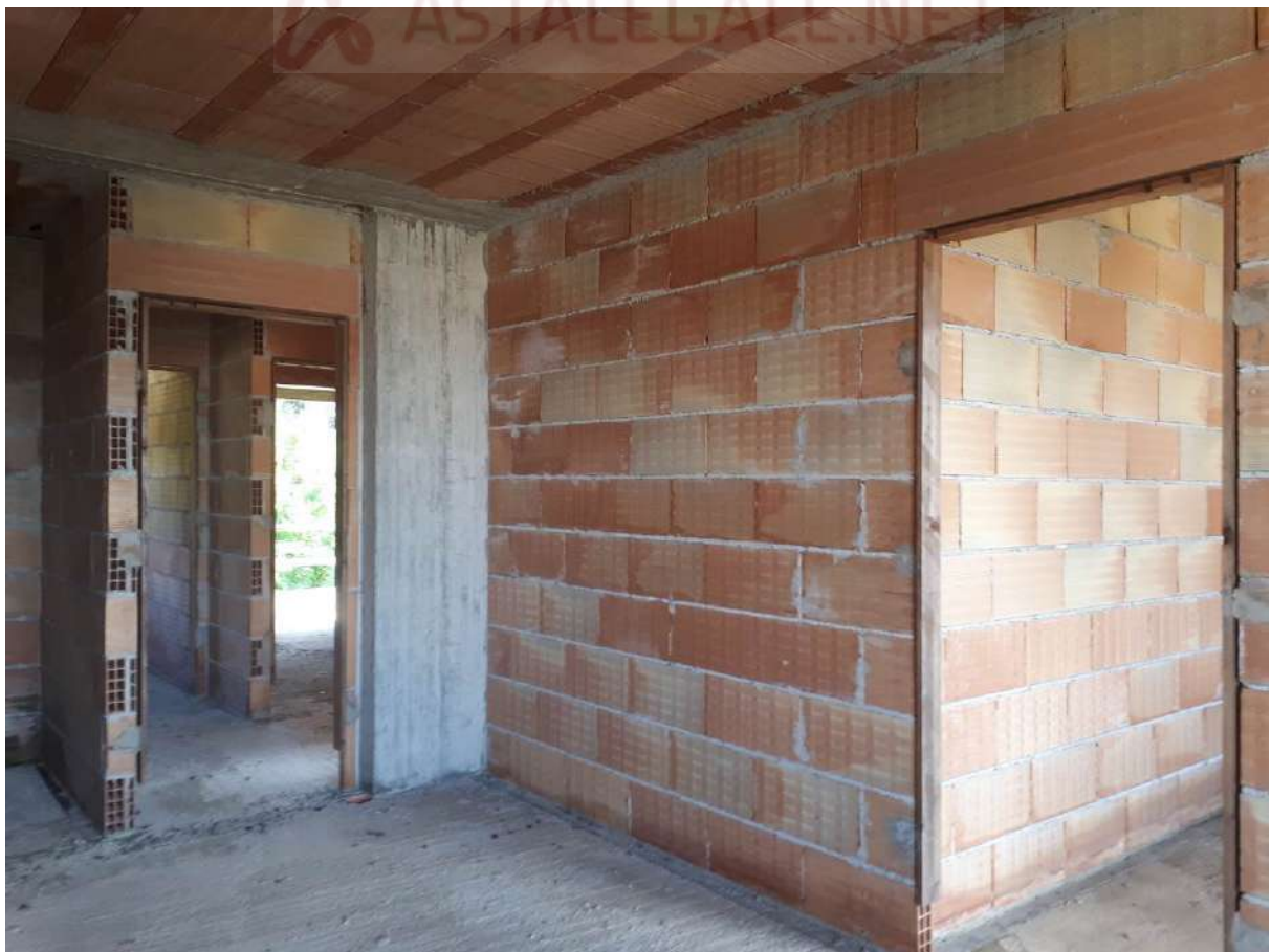
Foto 28 interno allo stato grezzo nei due edifici, porzioni con tamponature e divisori interni realizzati
