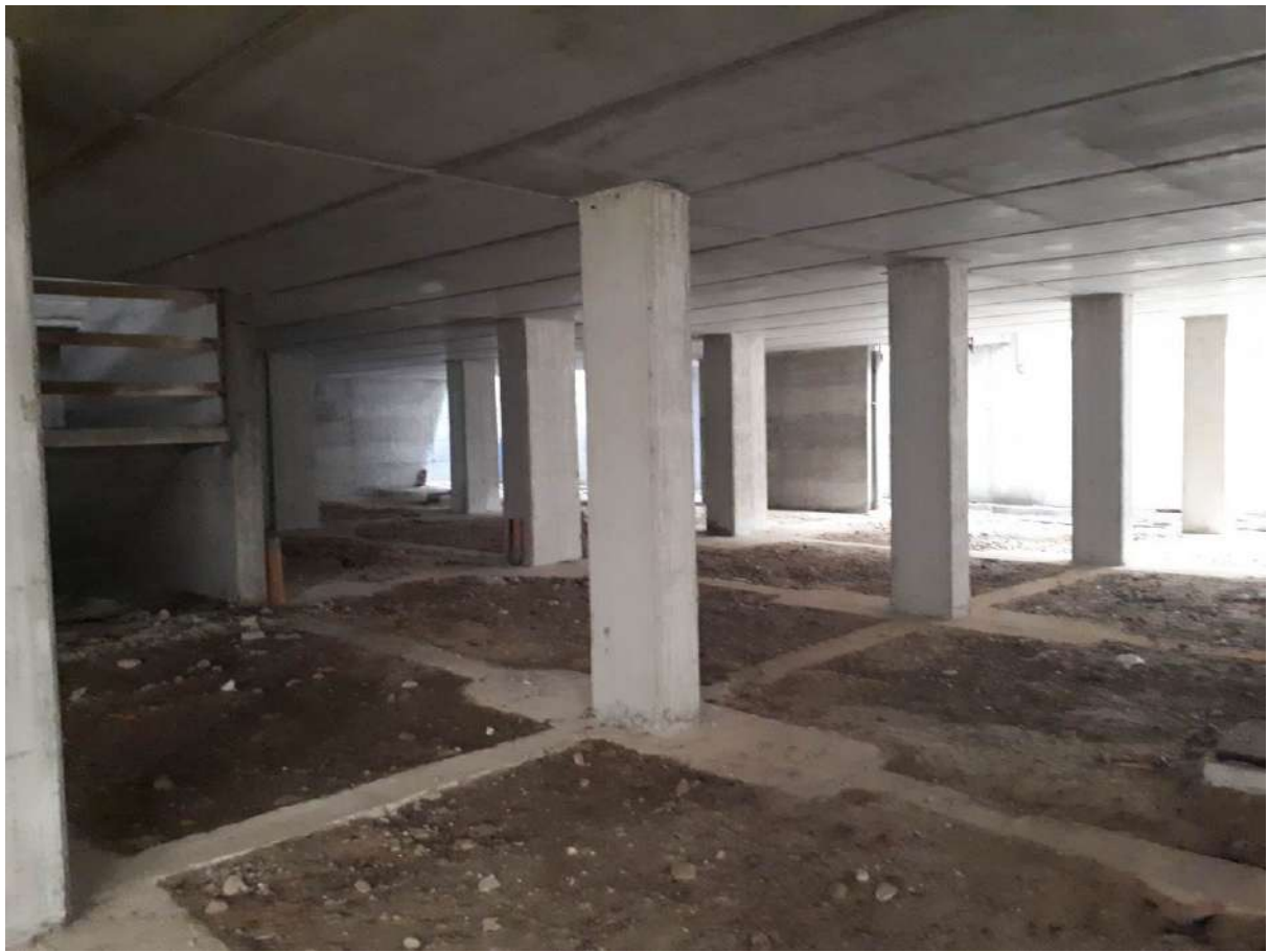
Foto 31 piano interrato S2 allo stato grezzo
