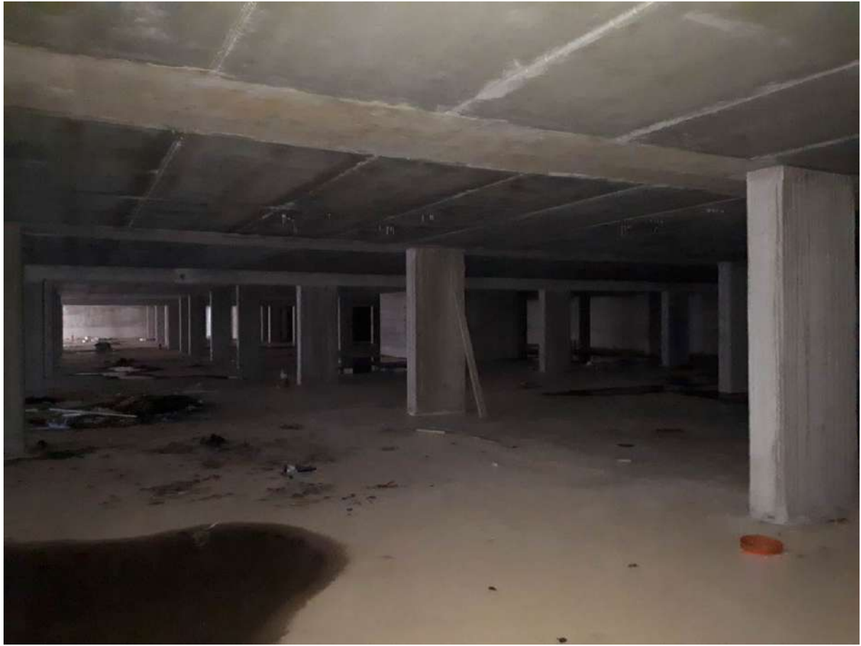
Foto 34 piano secondo interrato
