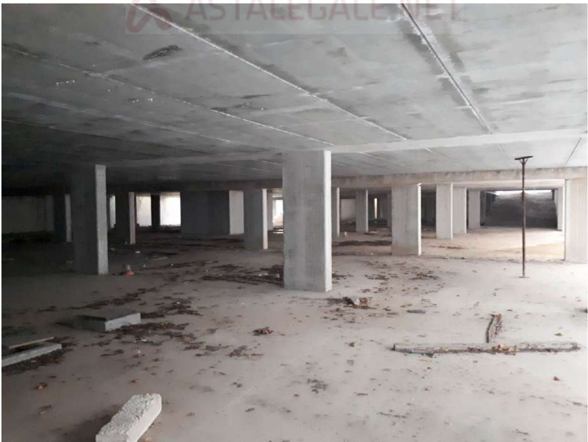
Foto 33 piano secondo interrato
