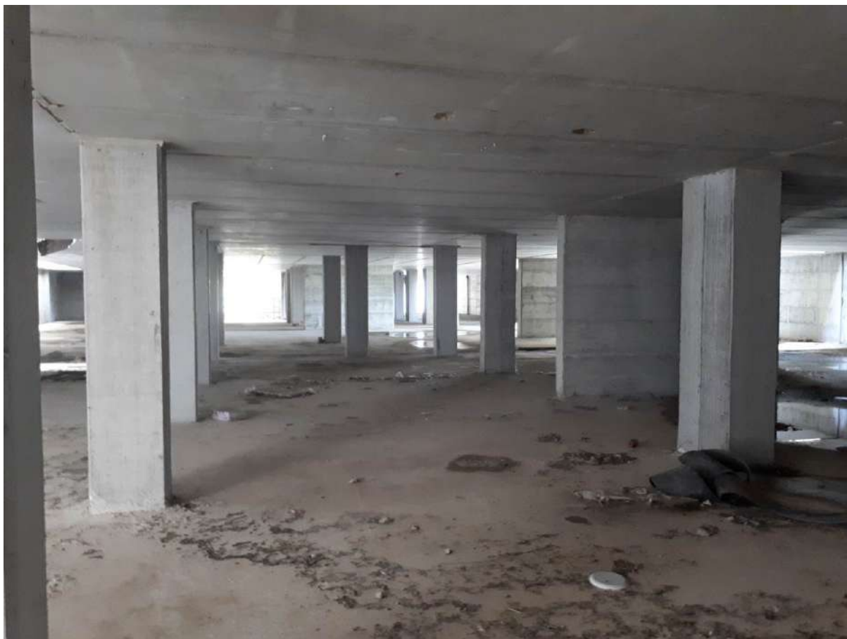
Foto 33 piano interrato S1 allo stato grezzo
