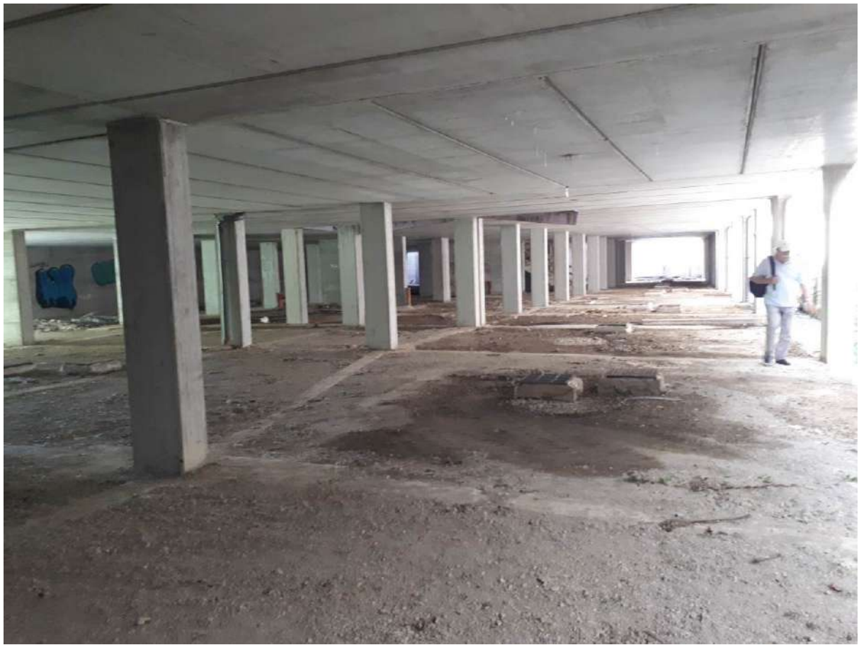
Foto 29 piano interrato S2 allo stato grezzo
