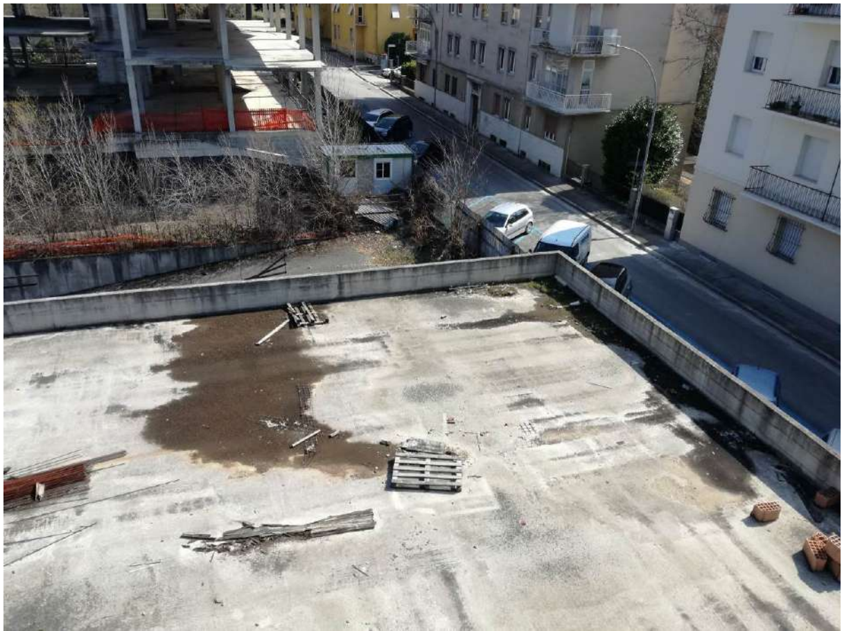
Foto 14 lastrico solare (sub3)
