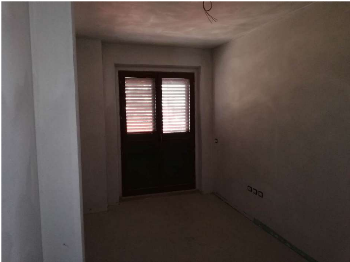
Foto 9 APPARTAMENTO n.2 P.2° SEMININTERRATO – SUB31 – CAMERA SINGOLA
