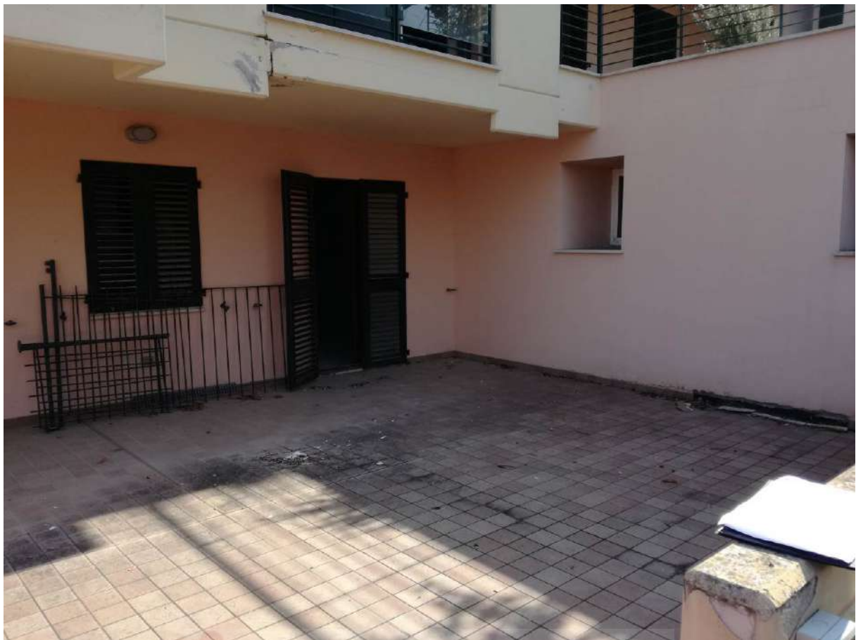
Foto 13 APPARTAMENTO n.2 P.2° SEMININTERRATO – SUB31 – CORTE PAVIMENTATA AD OVEST
