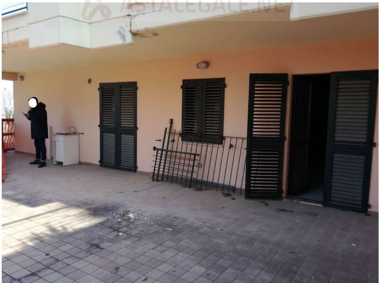
Foto 12 APPARTAMENTO n.2 P.2° SEMININTERRATO – SUB31 – CORTE PAVIMENTATA AD OVEST
