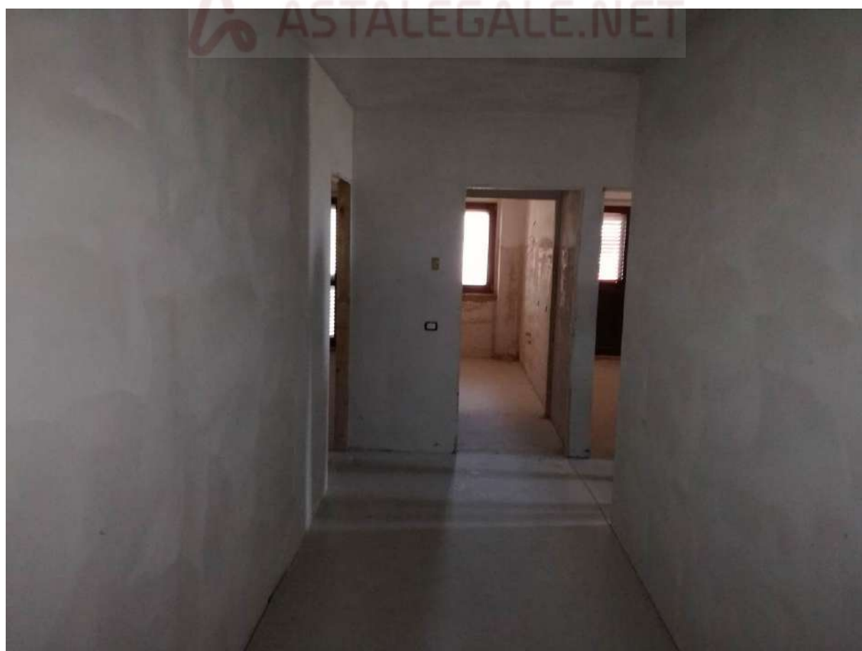
Foto 6 APPARTAMENTO n.2 P.2° SEMININTERRATO – SUB31 - INGRESSO
