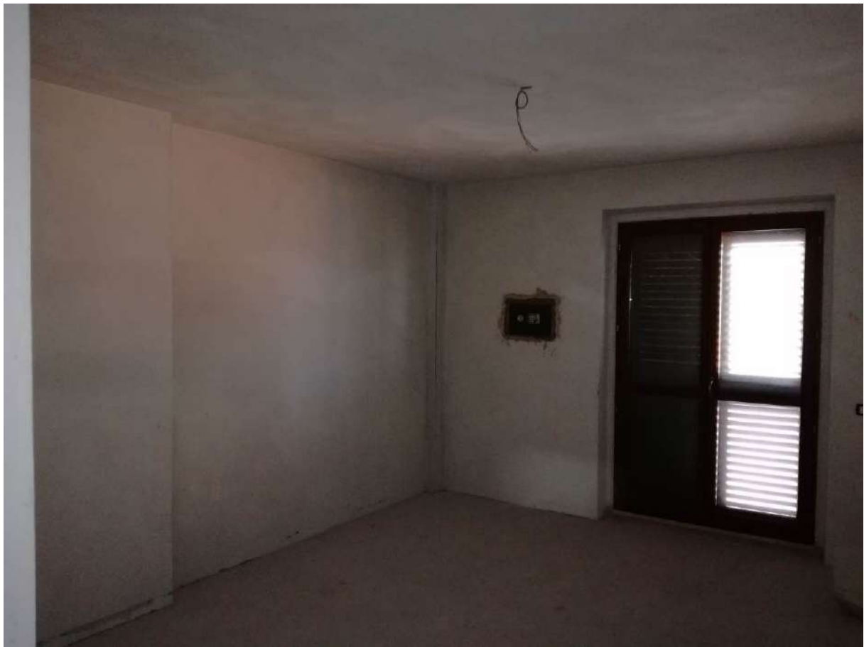
Foto 7 APPARTAMENTO n.2 P.2° SEMININTERRATO – SUB31 – CAMERA MATRIMONIALE
