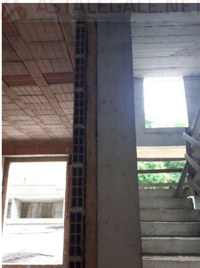
Foto 24 tamponatura interna realizzata con isolante termico
