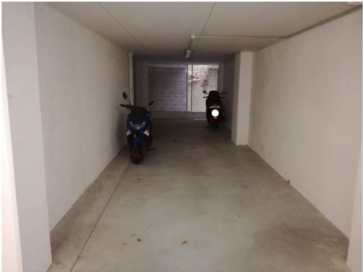
Foto 54 GARAGE n.14 P.1° INTERRATO – SUB57 (senza serranda)
