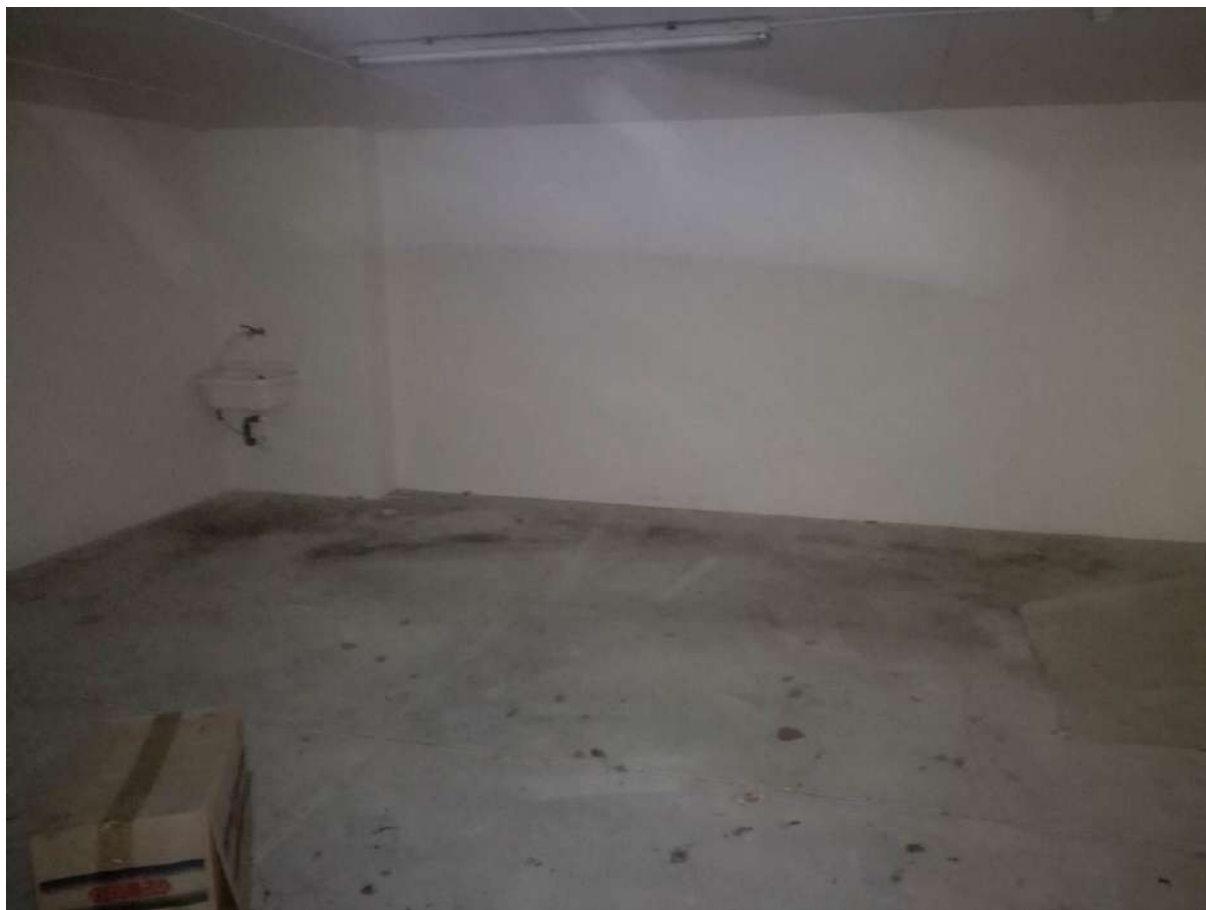
Foto 65 GARAGE n.17 P.2° INTERRATO – SUB65
