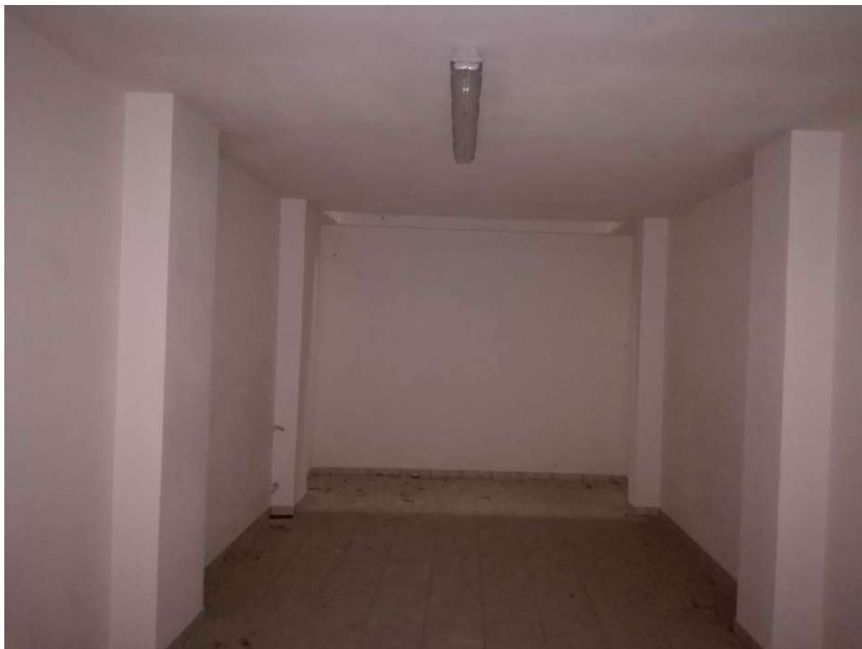
Foto 35 DEPOSITO n.4 P.2° SEMININTERRATO – SUB43
