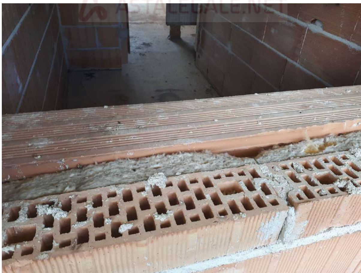
Foto 22 tamponatura esterna realizzata con isolante termico
