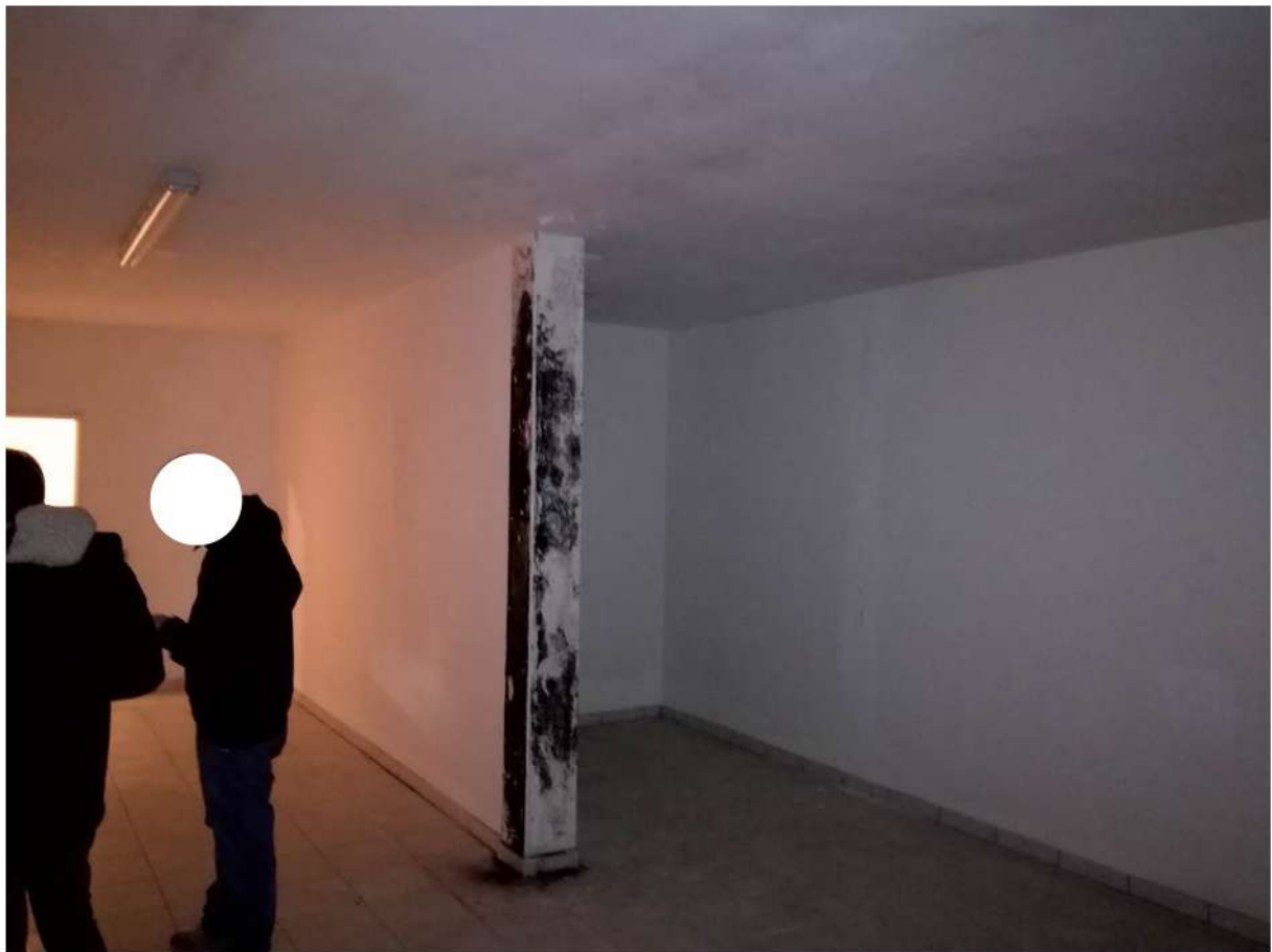
Foto 45 DEPOSITO n.8 P.2° SEMININTERRATO – SUB39
