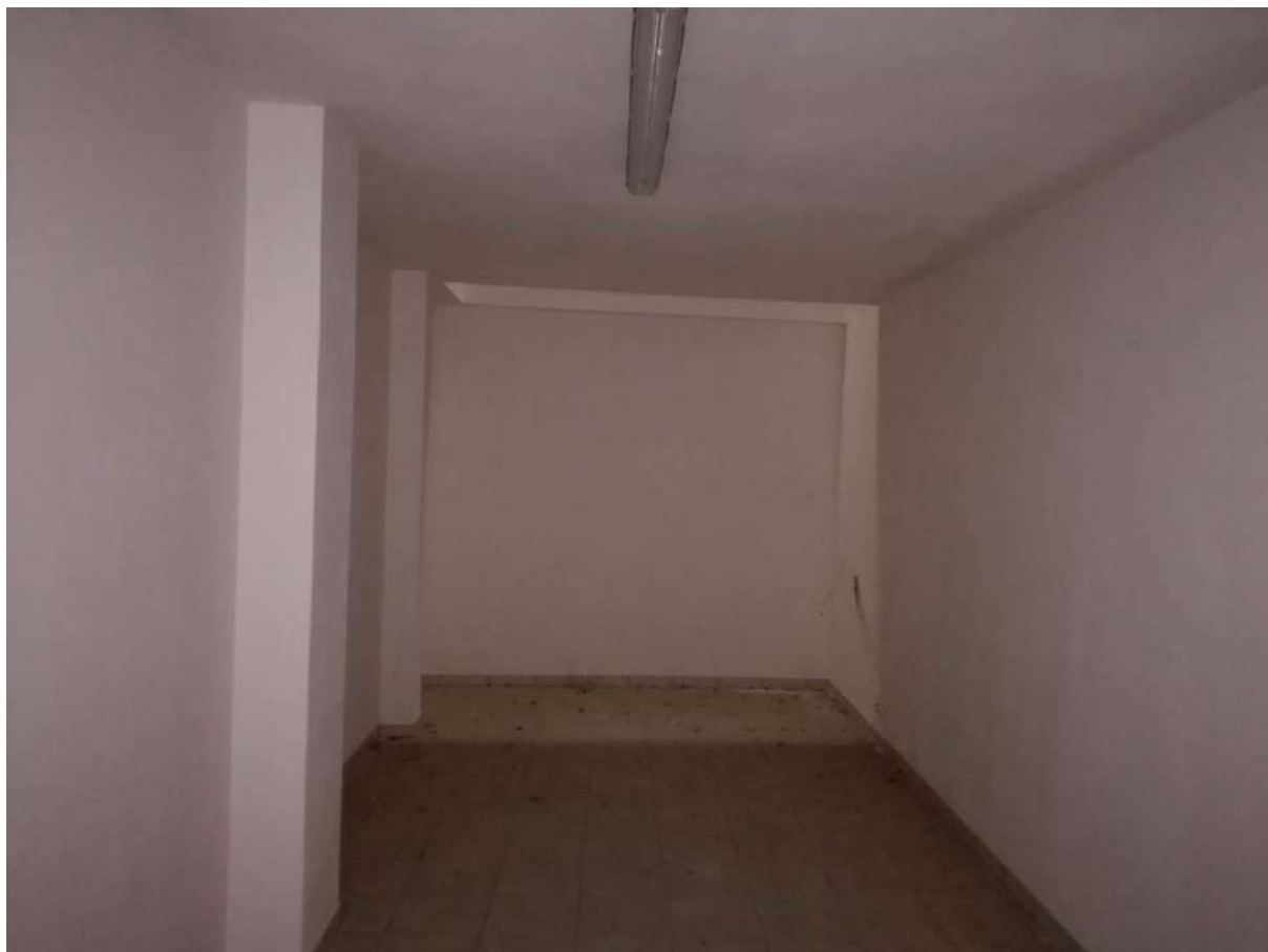
Foto 37 DEPOSITO n.5 P.2° SEMININTERRATO – SUB42
