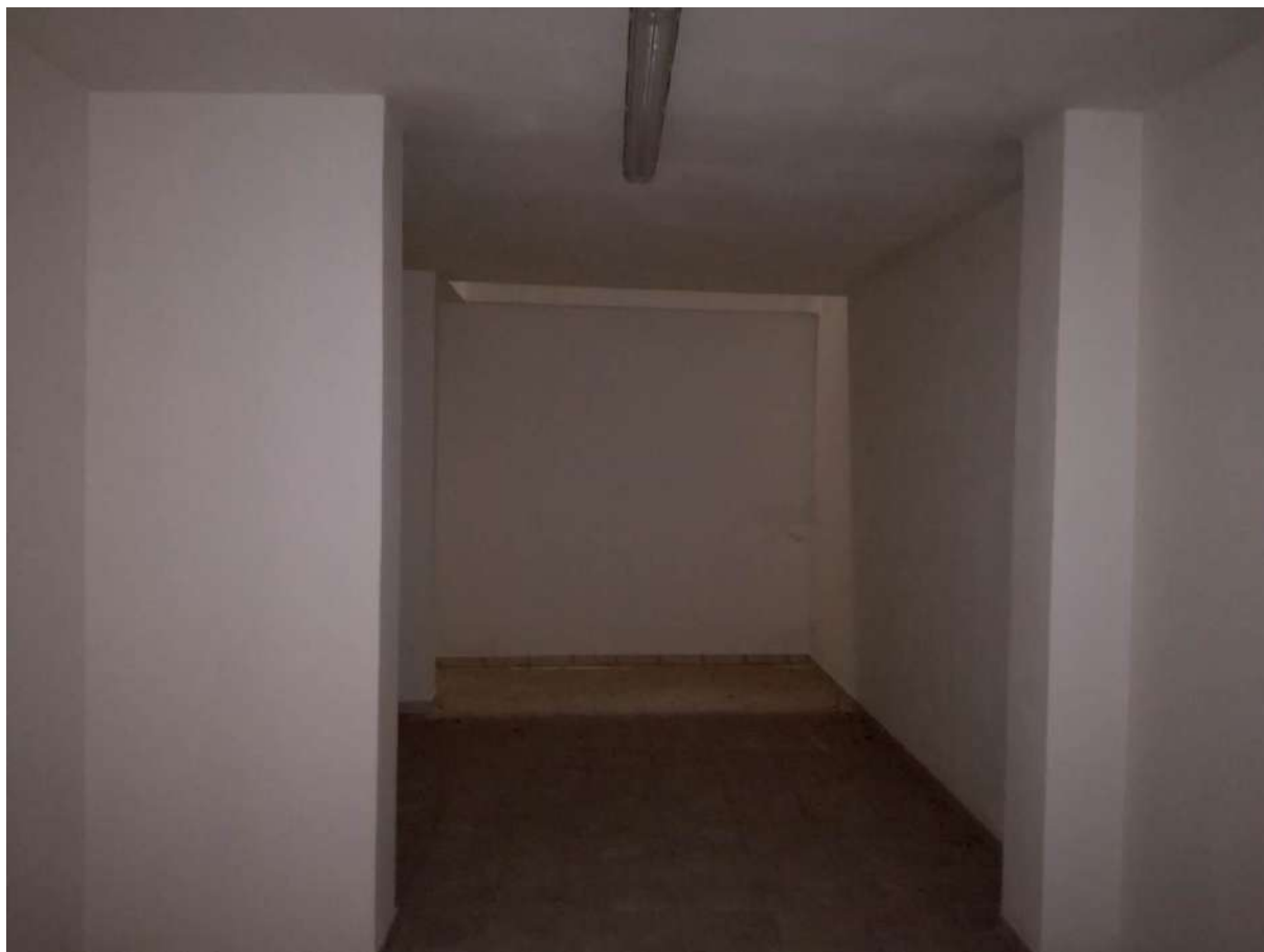
Foto 39 DEPOSITO n.6 P.2° SEMININTERRATO – SUB41
