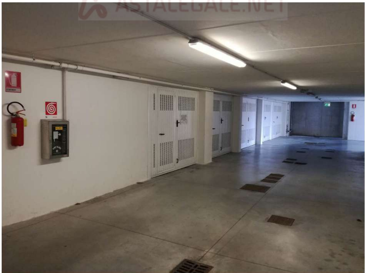
Foto 55 SPAZI DI MANOVRA P.2° INTERRATO
