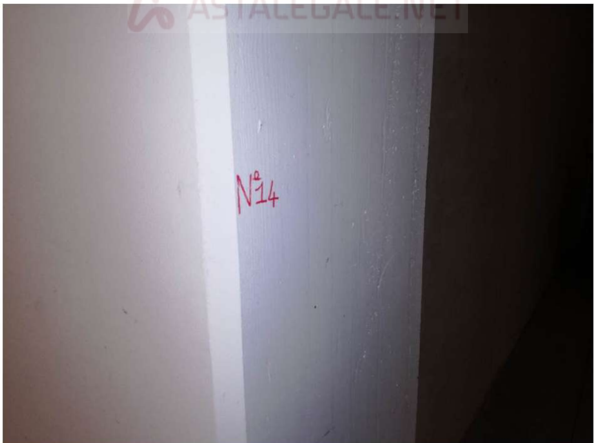
Foto 53 GARAGE n.14 P.1° INTERRATO – SUB57 (senza serranda)
