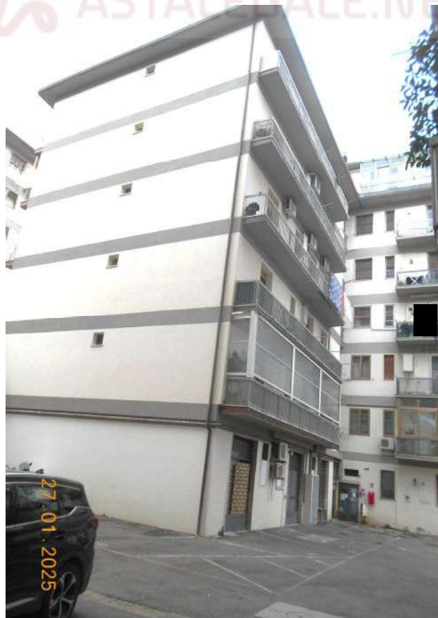
Fotografia n° 2 Facciata laterale e tergale
