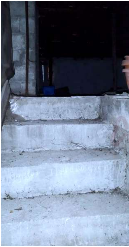
Foto n°21:-- Vano Scala tra i piani 1° e 2°;
