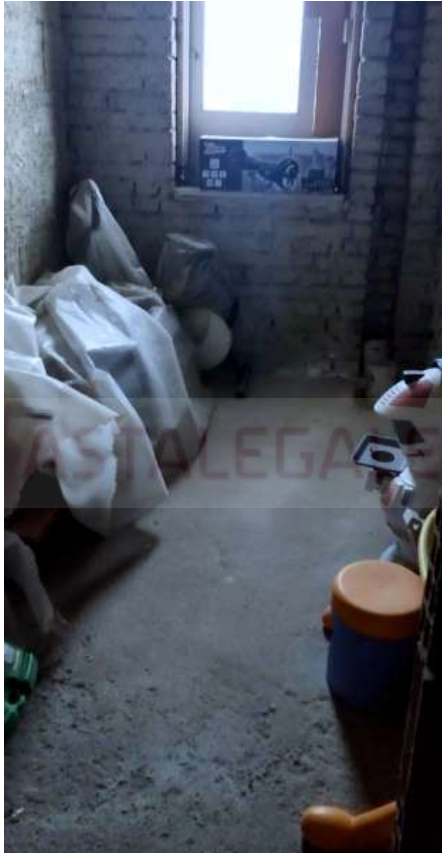
Foto n°22:-- Piano 2°, Locale da adibire a WC;
