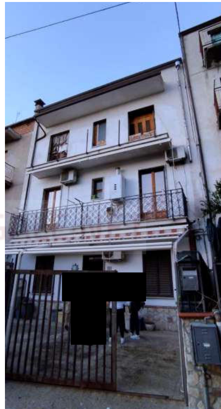
Foto n°6: – Prospetto Sud del fabbricato Comune di Bisignano(CS), fg. n°38, p.IIa n°586 Ingresso alla corte;
