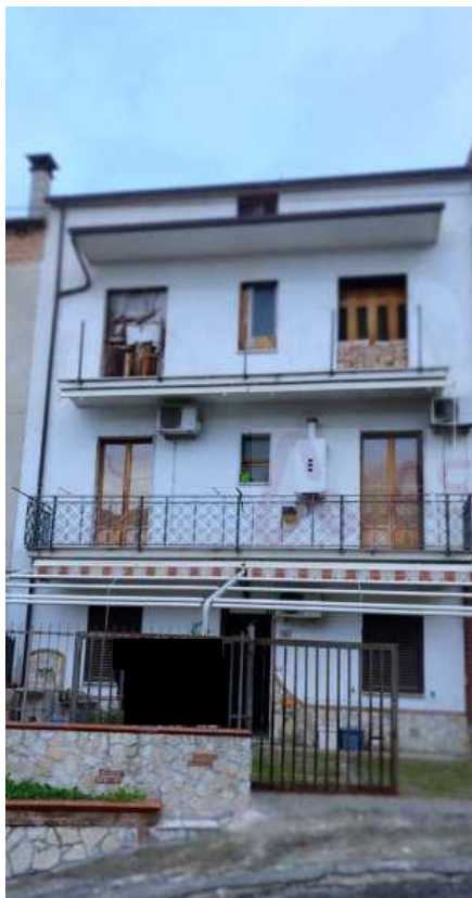
Foto n°5: – Prospetto Sud del fabbricato Comune di Bisignano(CS), fg. n°38, p.IIa n°586;
