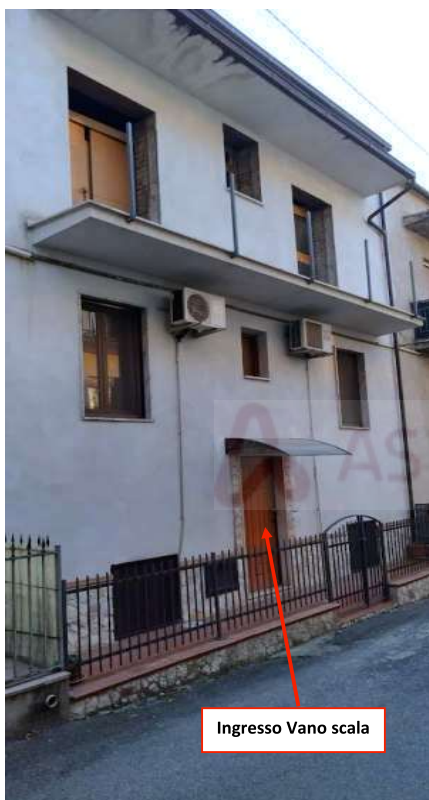
Foto n°3: – Prospetto Nord del fabbricato Comune di Bisignano (CS), fg. n°38, p.lla n°586;
