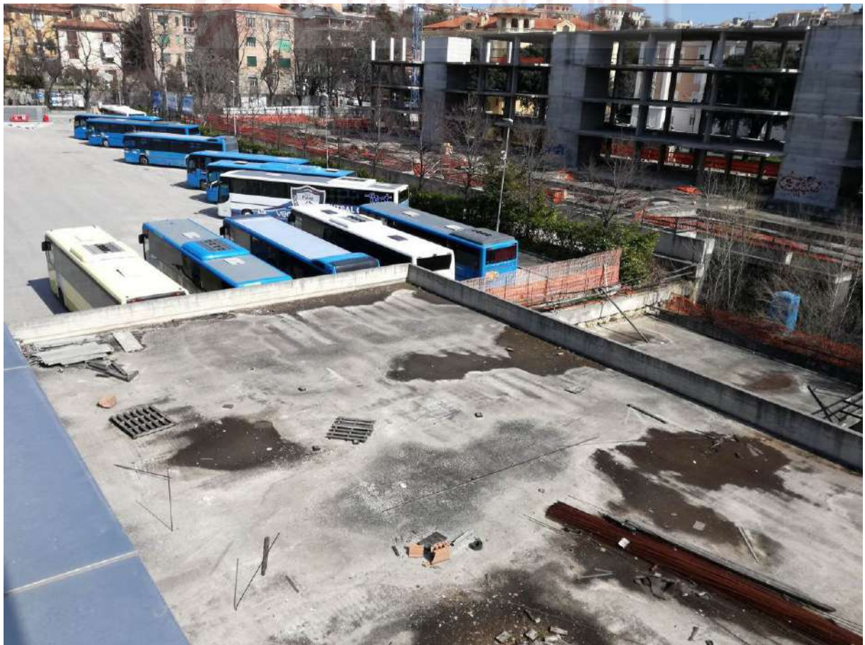
Foto 15 lastrico solare (sub3)
