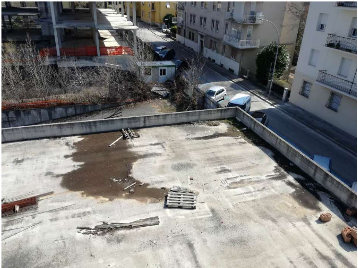
Foto 14 lastrico solare (sub3)
