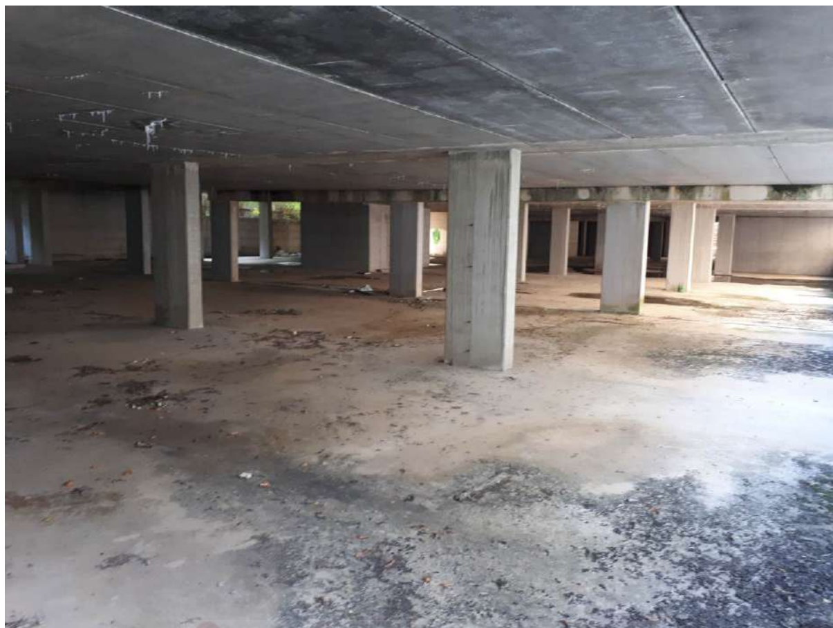
Foto 30 piano primo interrato
