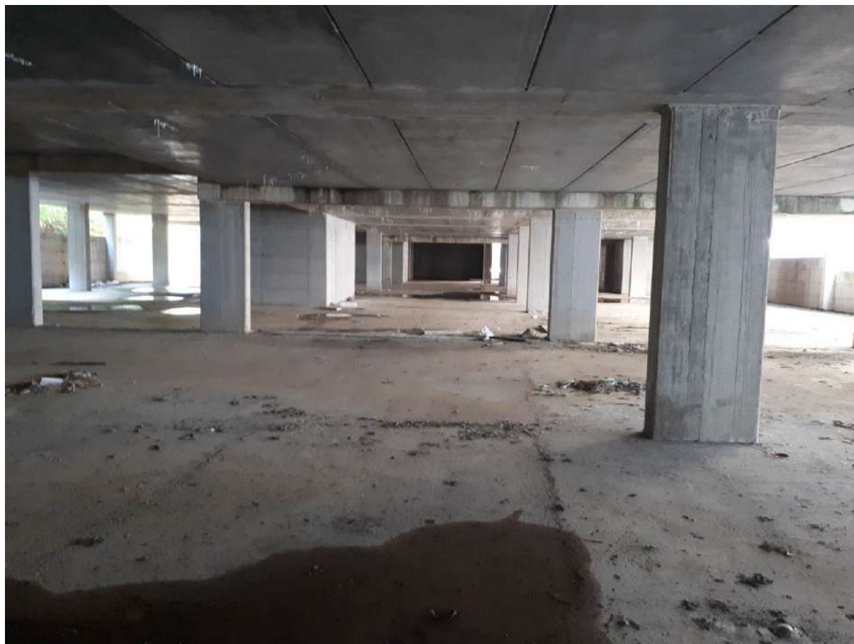
Foto 32 piano primo interrato
