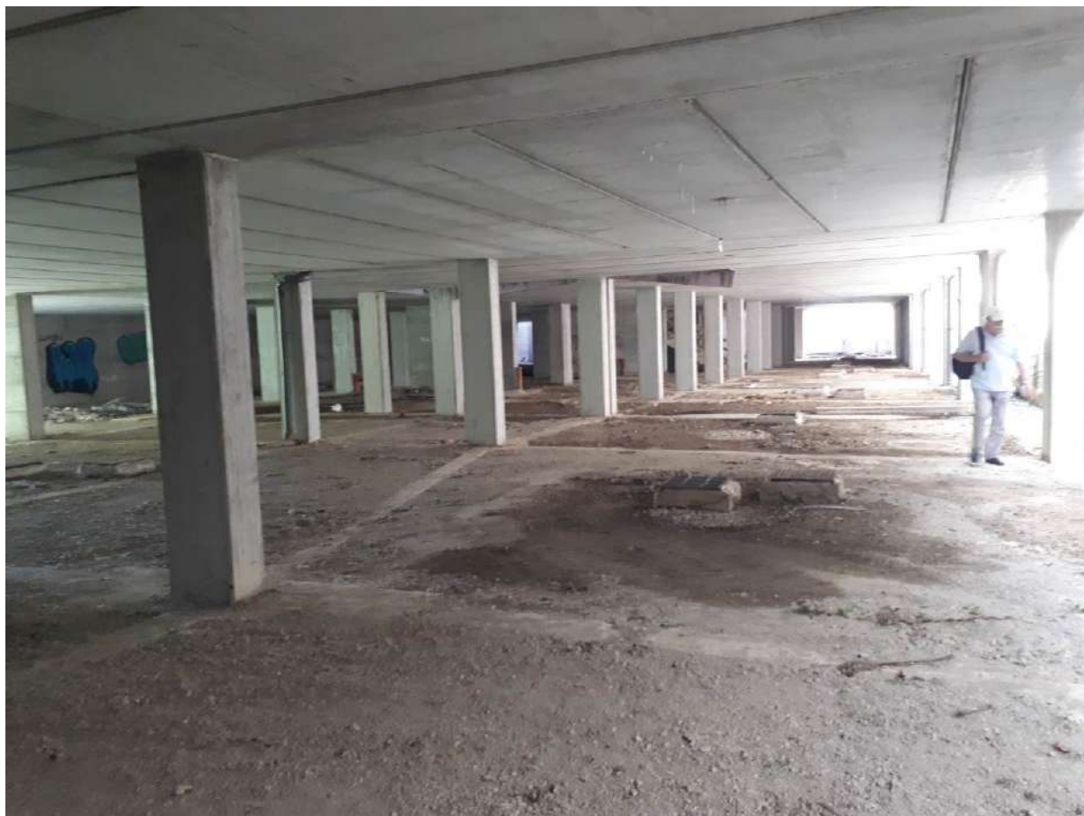
Foto 29 piano interrato S2 allo stato grezzo
