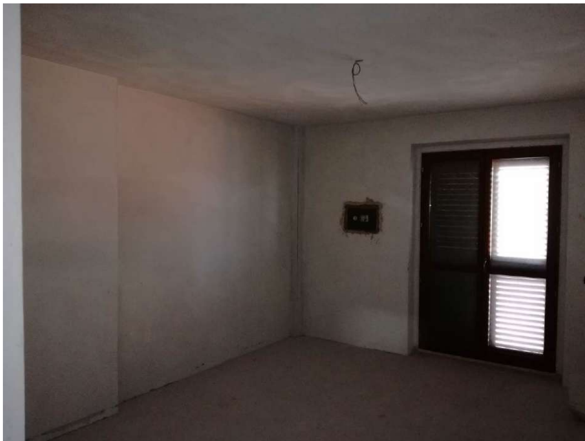
Foto 7 APPARTAMENTO n.2 P.2° SEMININTERRATO – SUB31 – CAMERA MATRIMONIALE
