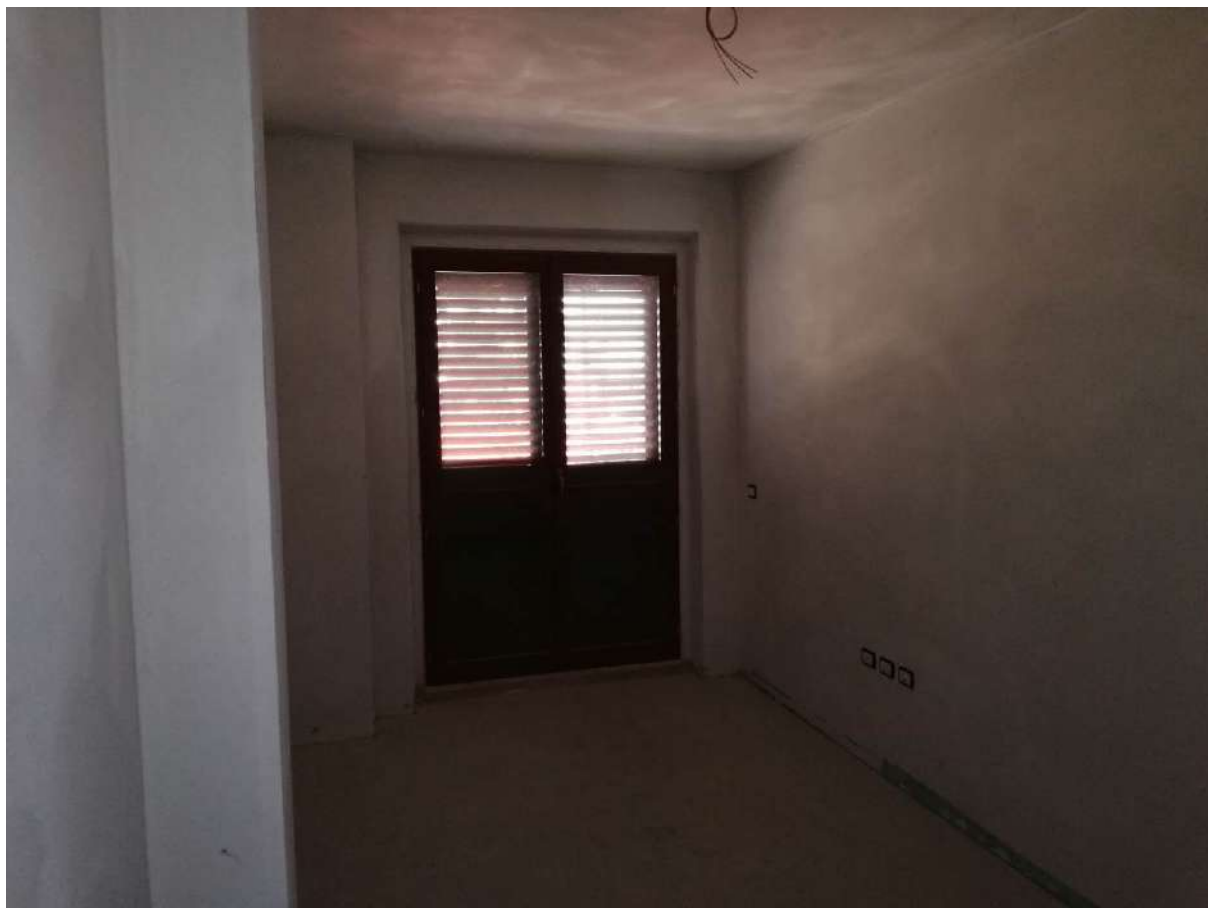
Foto 9 APPARTAMENTO n.2 P.2° SEMININTERRATO – SUB31 – CAMERA SINGOLA
