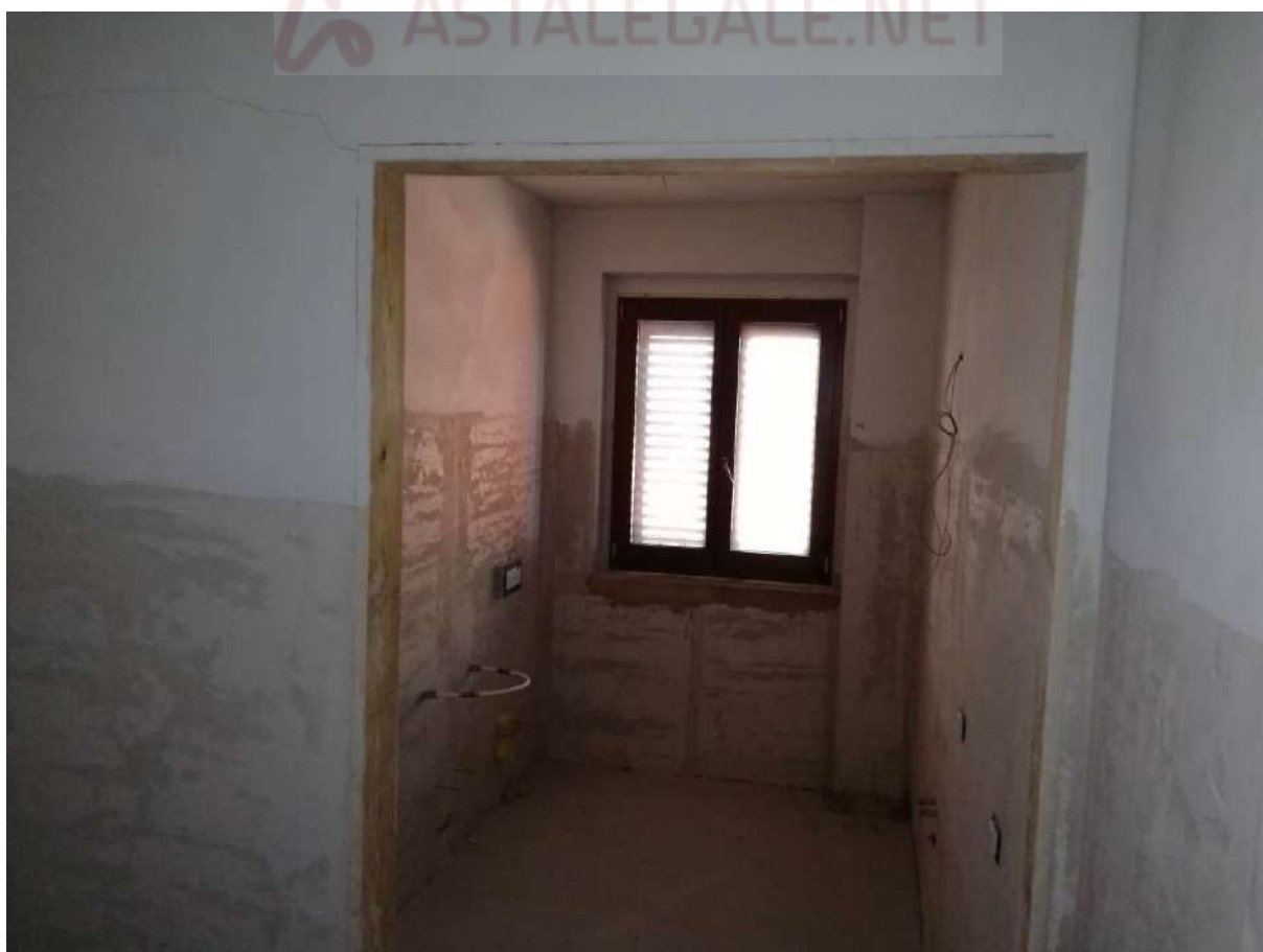
Foto 10 APPARTAMENTO n.2 P.2° SEMININTERRATO – SUB31 - BAGNO
