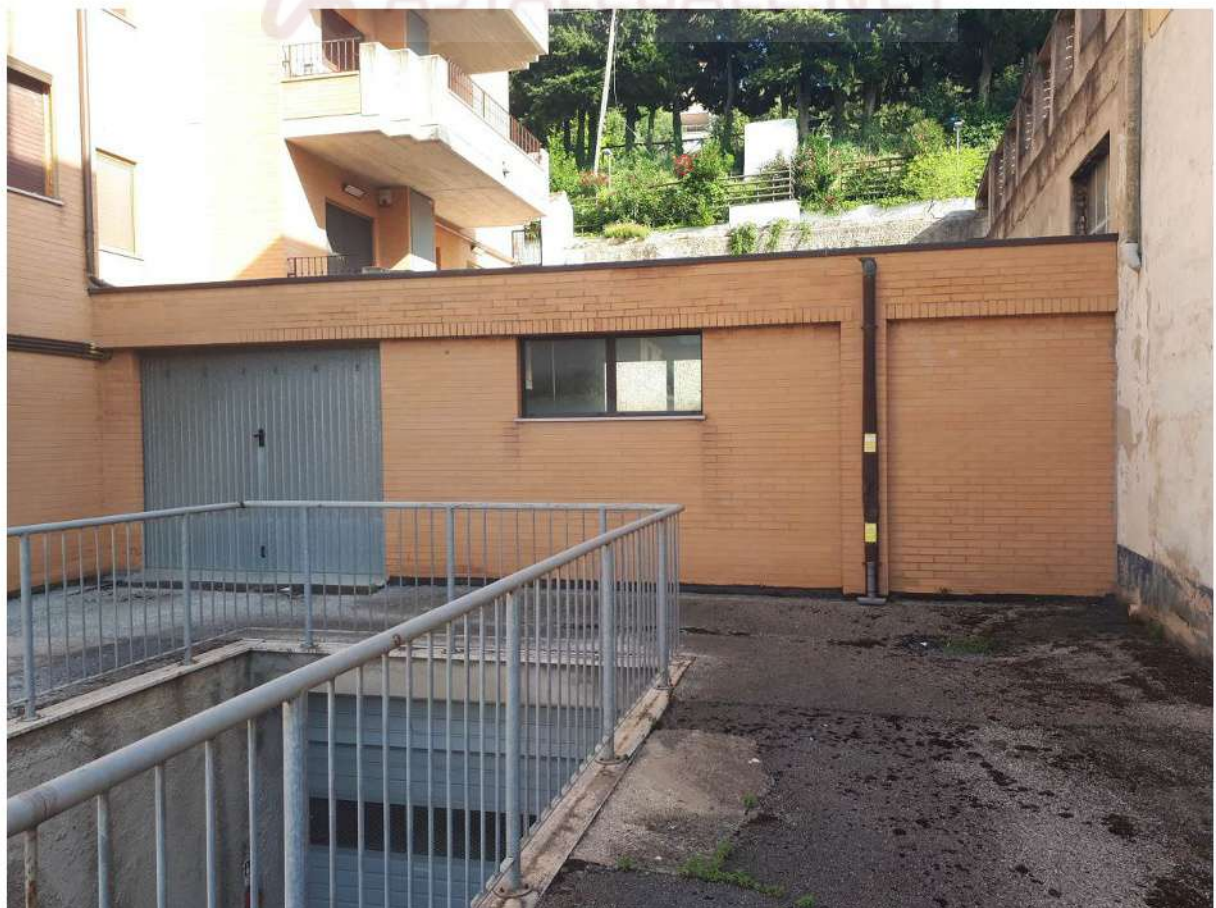
Foto 14 magazzino fg.65 part.100 sub 47
