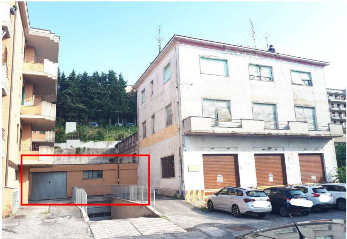
Foto 13 magazzino fg.65 part.100 sub 47
