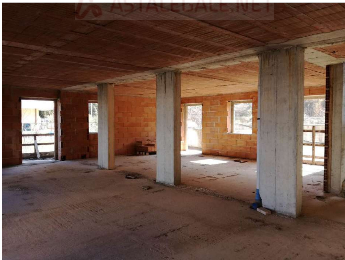
Foto 18 interno allo stato grezzo nei due edifici
