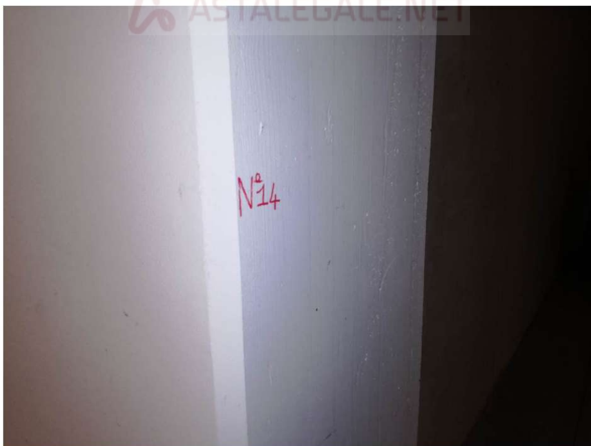
Foto 53 GARAGE n.14 P.1° INTERRATO – SUB57 (senza serranda)
