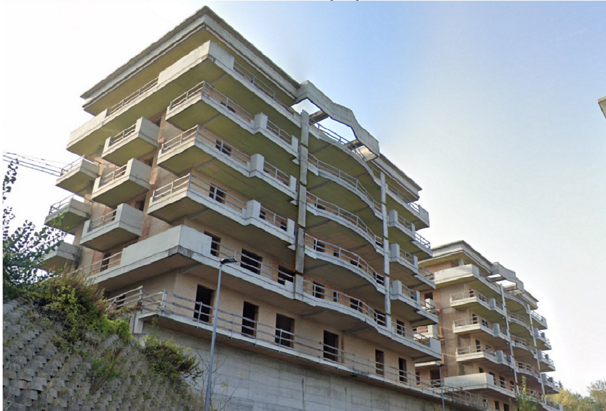
Foto 2 vista d'insieme prospetto nord
