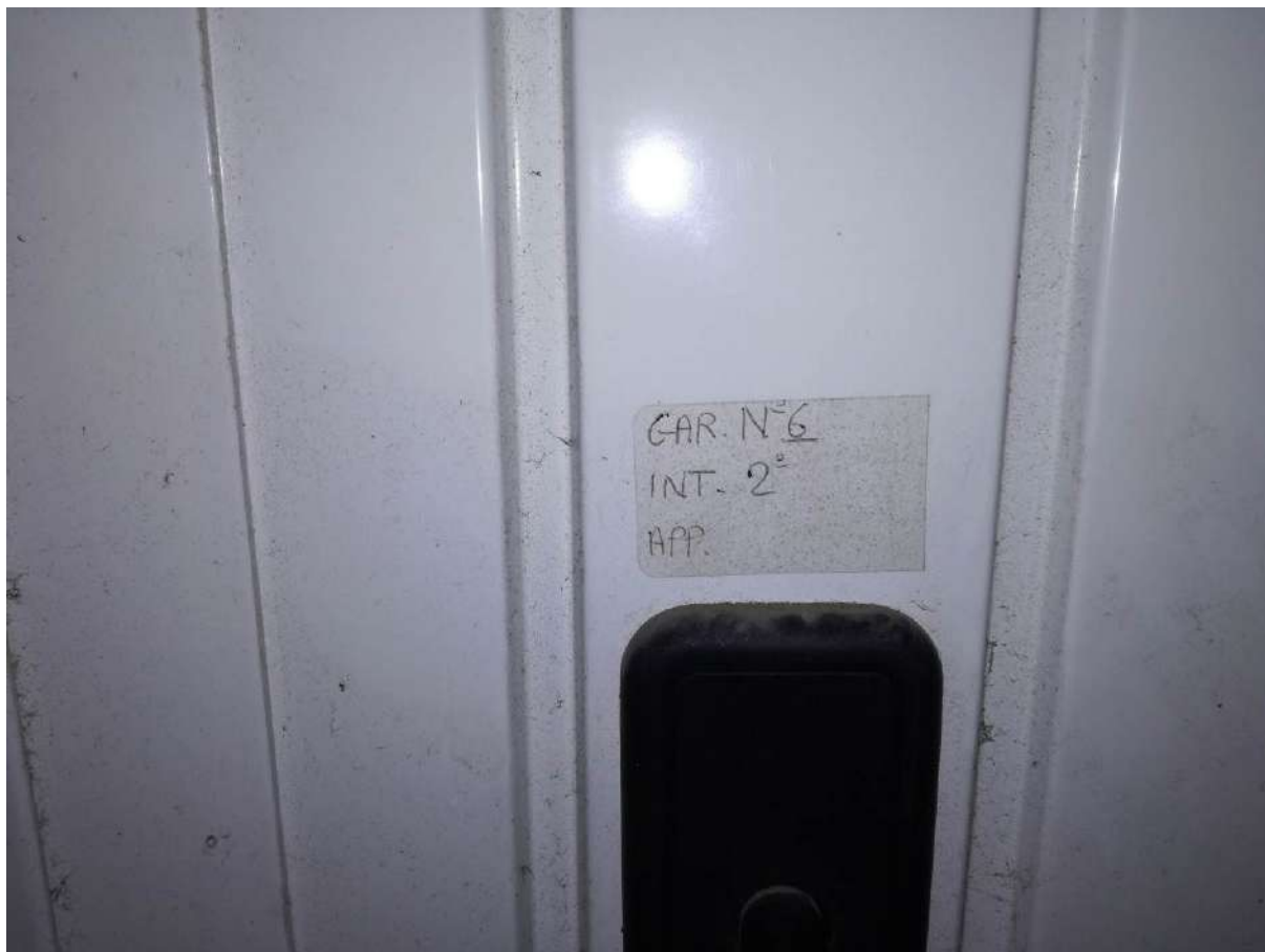
Foto 61 GARAGE n.6 P.2° INTERRATO – SUB74
