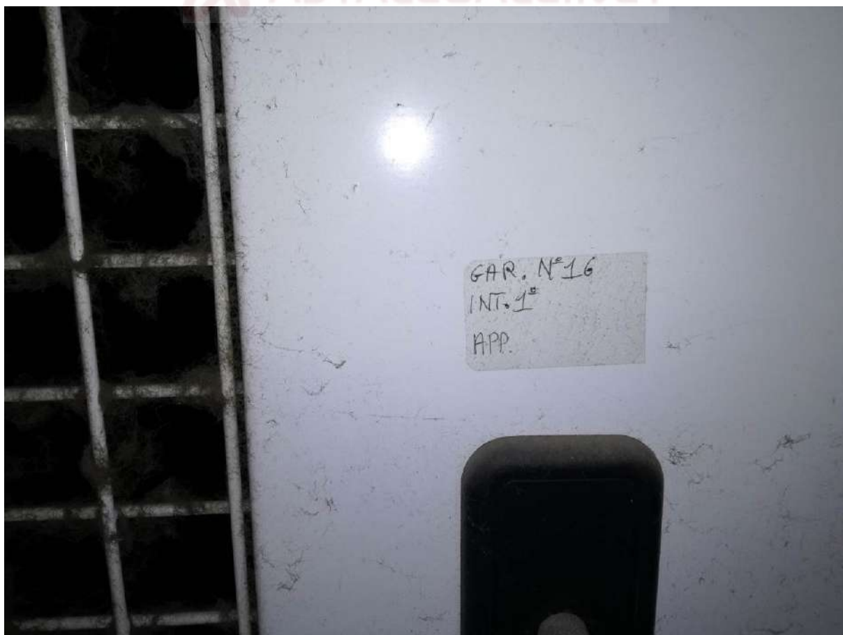
Foto 49 GARAGE n.16 P.1° INTERRATO – SUB55
