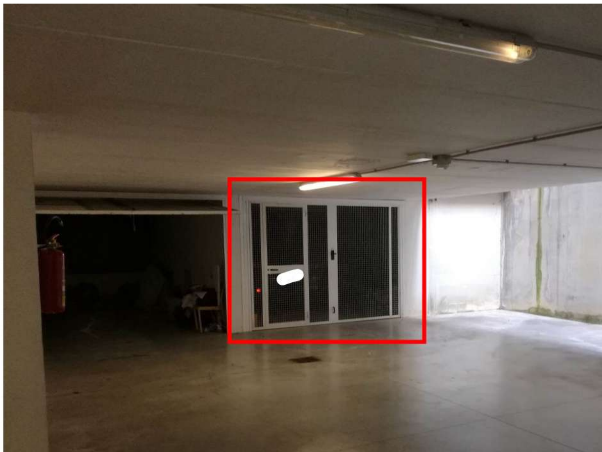
Foto 63 GARAGE n.11 P.2° INTERRATO – SUB64 (OCCUPATO)
