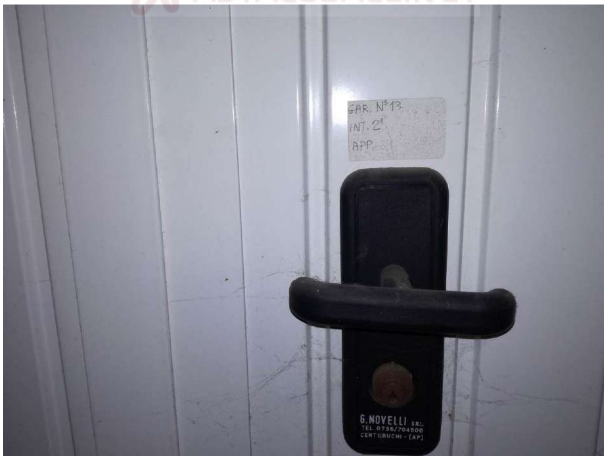
Foto 57 GARAGE n.13 P.2° INTERRATO – SUB69
