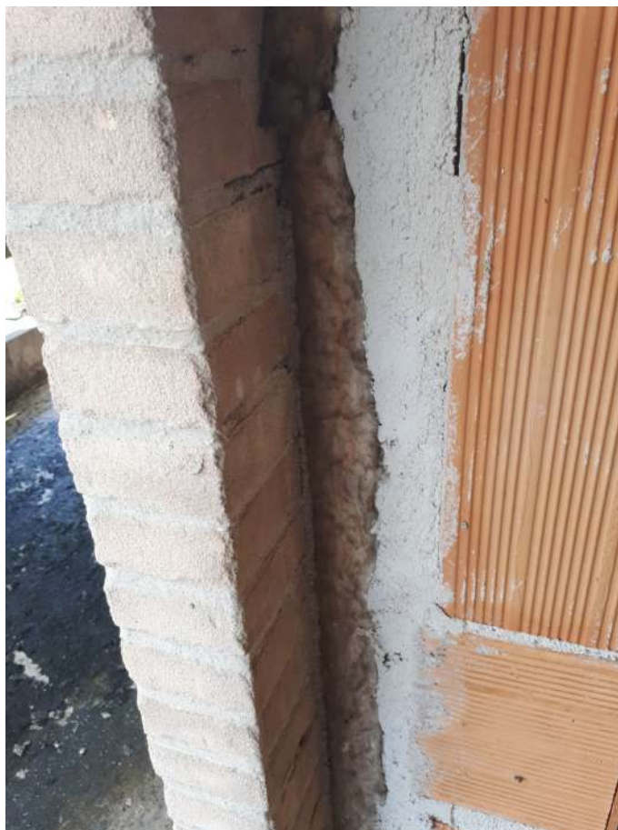
Foto 23 tamponatura esterna realizzata con isolante termico
