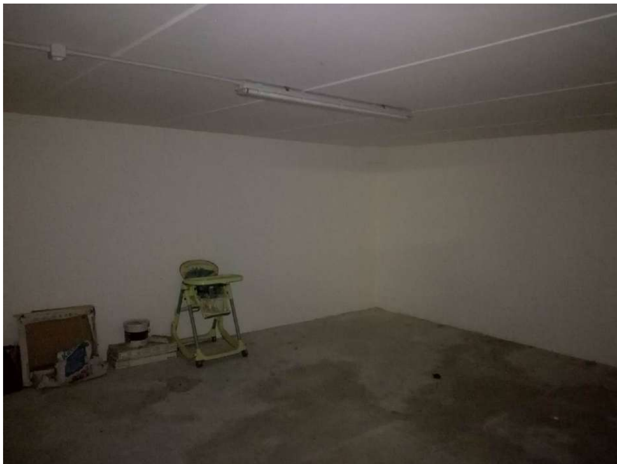
Foto 58 GARAGE n.13 P.2° INTERRATO – SUB69
