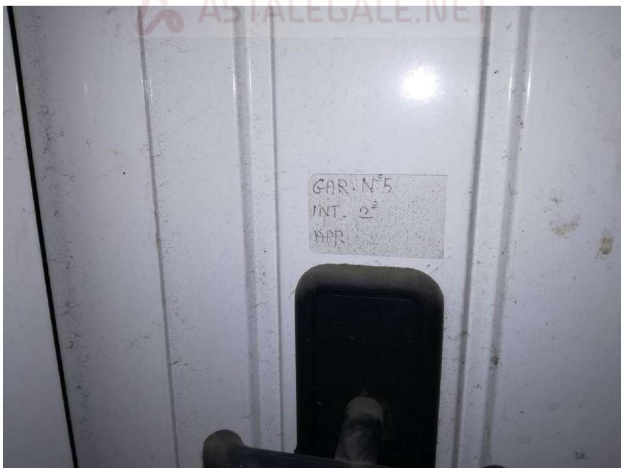
Foto 59 GARAGE n.5 P.2° INTERRATO – SUB75
