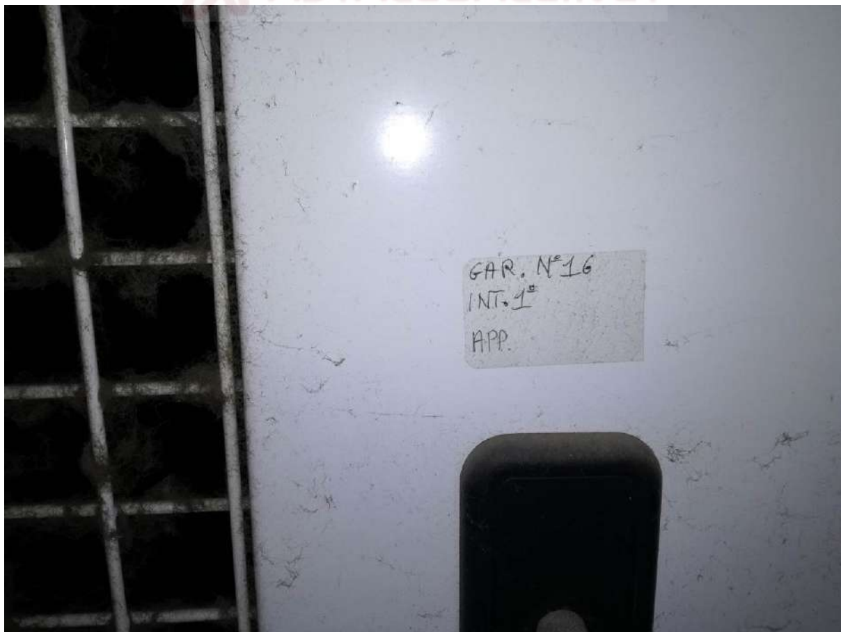
Foto 49 GARAGE n.16 P.1° INTERRATO – SUB55
