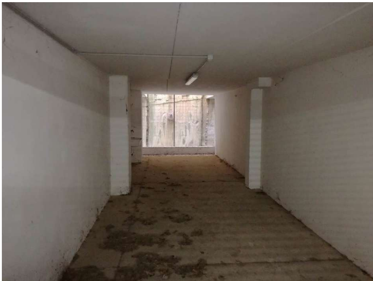
Foto 50 GARAGE n.16 P.1° INTERRATO – SUB55
