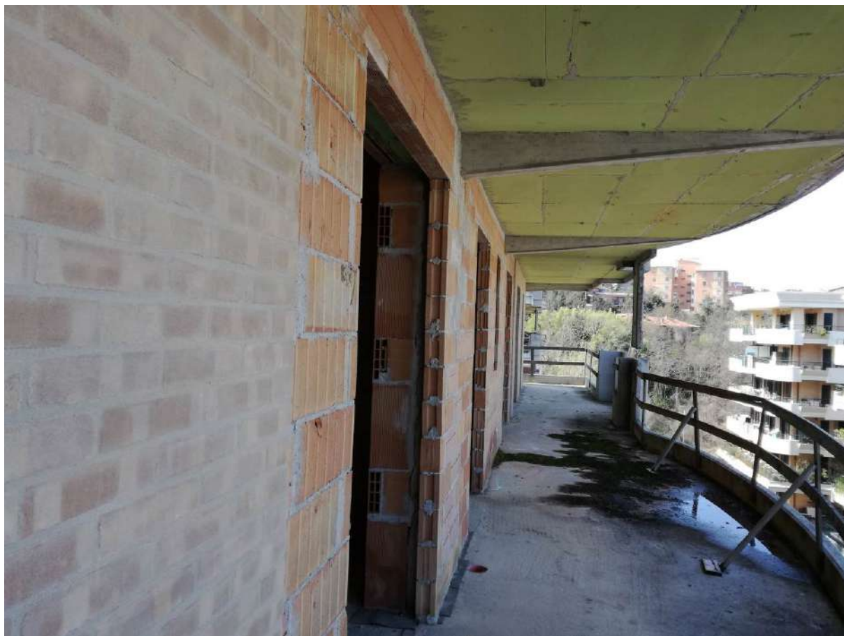
Foto 19 balconi allo stato grezzo nei due edifici
